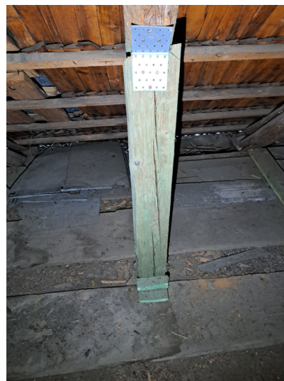
Zdj.9 Podparcie tymczasowe krokwi
