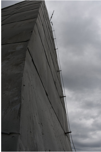
Zdj. 1 Pokrycie wieży
