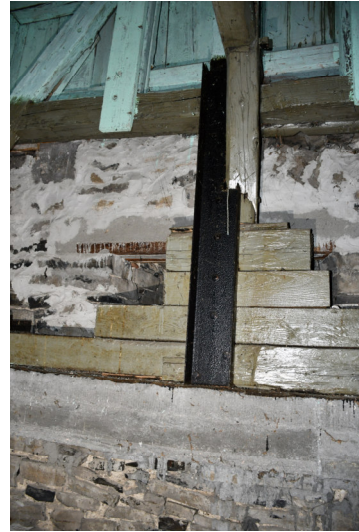
Zdj. 5, 6 Konstrukcje kotwiące w wieży widoczna belka żelbetowa oczepowa
