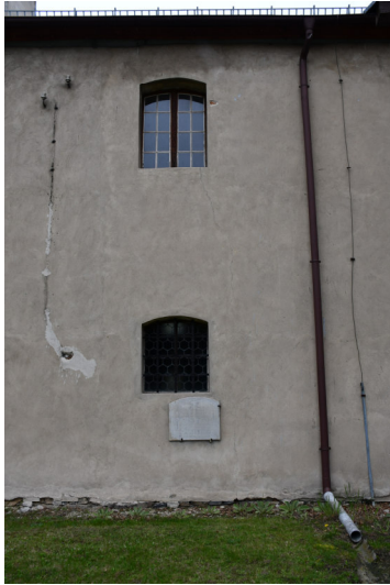
Zdj. 17,18 Elewacja płd uszkodzenia tynków i zarysowania
