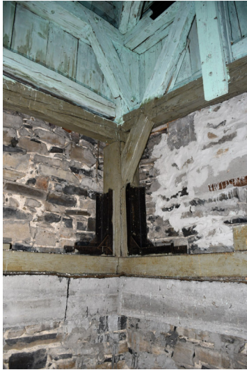
Zdj. 5, 6 Konstrukcje kotwiące w wieży widoczna belka żelbetowa oczepowa
