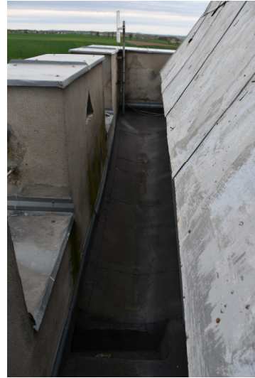
Zdj. 2 Taras wieży
