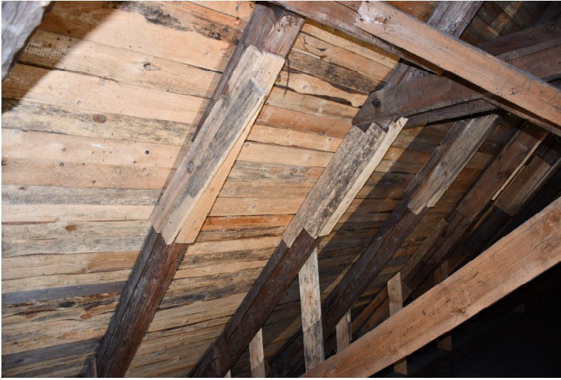
Zdj.10 Dach nad nawą główną połąć północna
