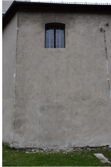
Zdj. 17,18 Elewacja płd uszkodzenia tynków i zarysowania
