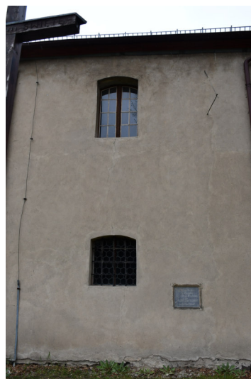
Zdj. 16,16 Elewacja płd uszkodzenia tynków i zarysowania
