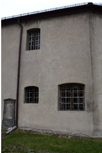
Zdj. 16,16 Elewacja płd uszkodzenia tynków i zarysowania
