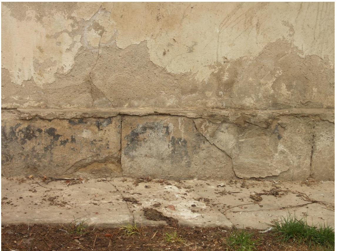
12. Cokół od strony dziedzińca. Uszkodzenia okładziny, uzupełnienia cementowe.
