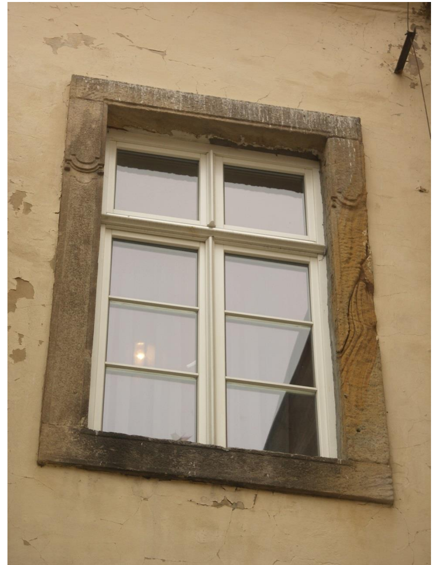
14. Obramienie okienne I piętra. Korozja piaskowca – wymycie wzdłuż warstw sedymentacyjnych.
