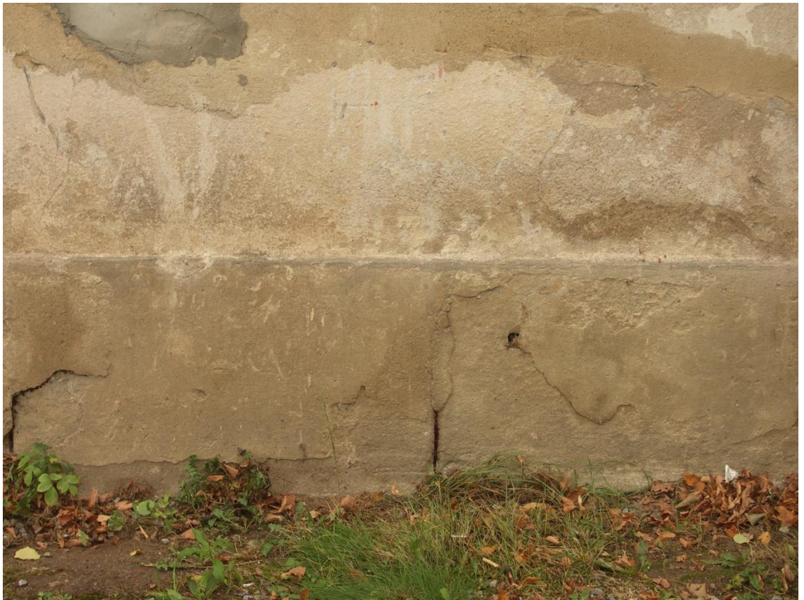
11. Cokół budynku nr 5. Tynk cementowy na okładzinie.
