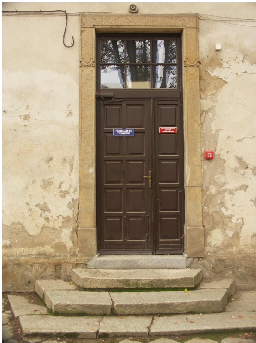
7. Jeden z portali budynku nr 5. Przemieszczone stopnie schodów. Próg obłożony cienkimi płytami granitowymi.
