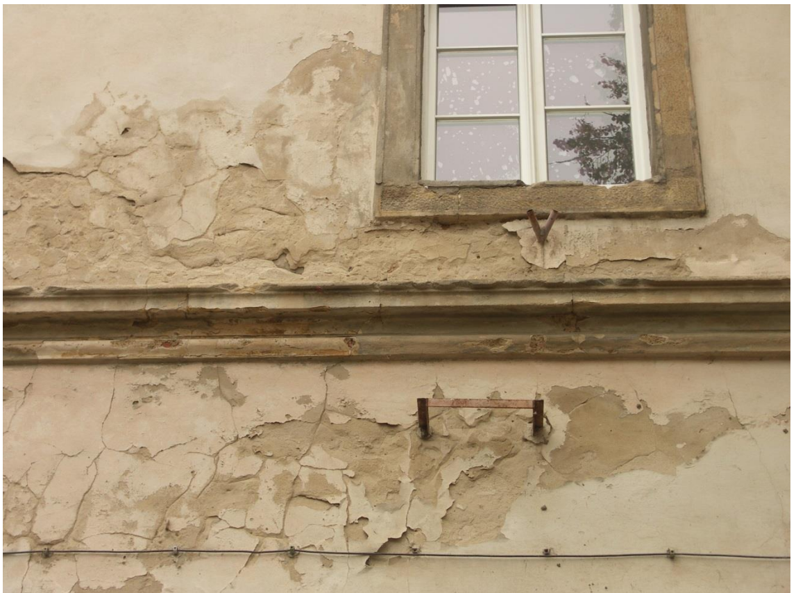
6. Fragment elewacji budynku nr 5. Piaskowcowy gzyms zakryty zaprawami.
