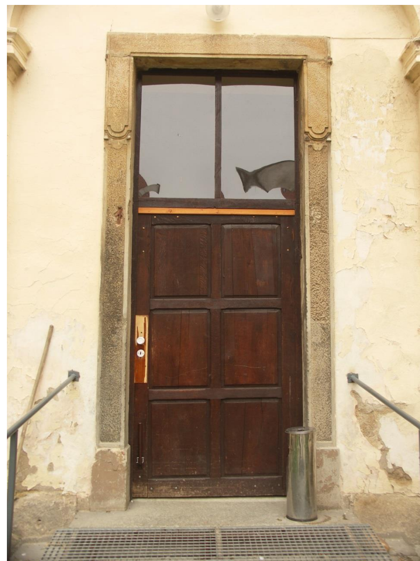
8. Portal w budynku nr 5 – od strony dziedzińca. Węgry odtworzone w zaprawie cementowej.
