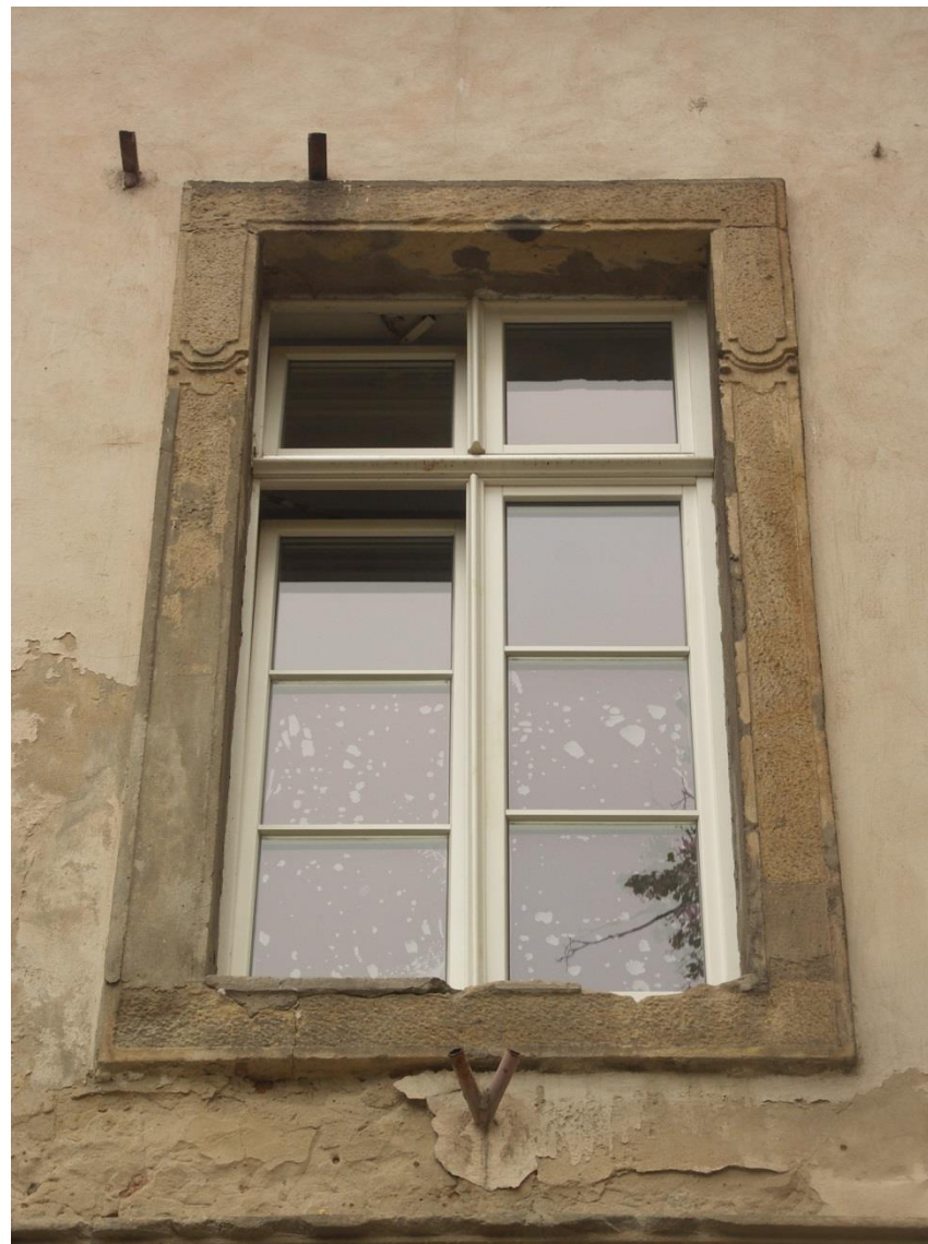
4. Okno budynku nr 5. Liczne uzupełnienia zaprawami cementowymi.
