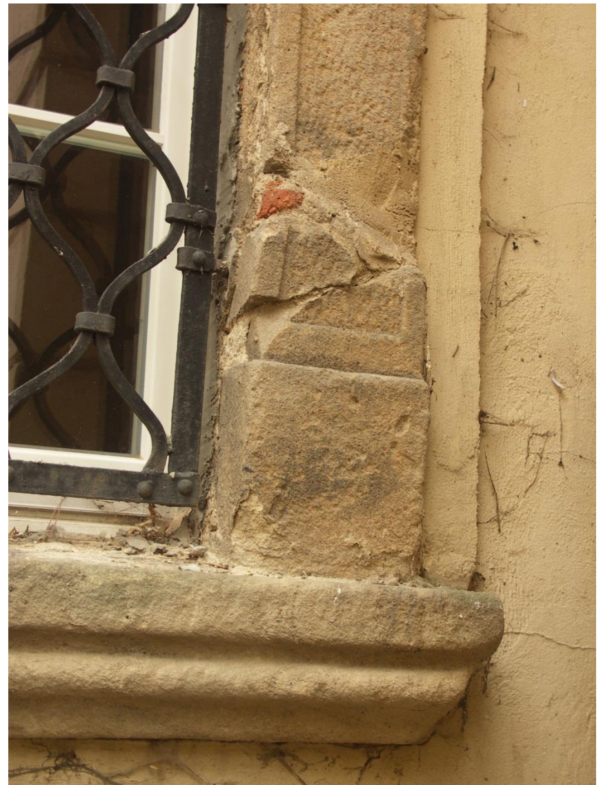
18. Okno od strony dziedzińca. Uszkodzenia sklejone cementem .
