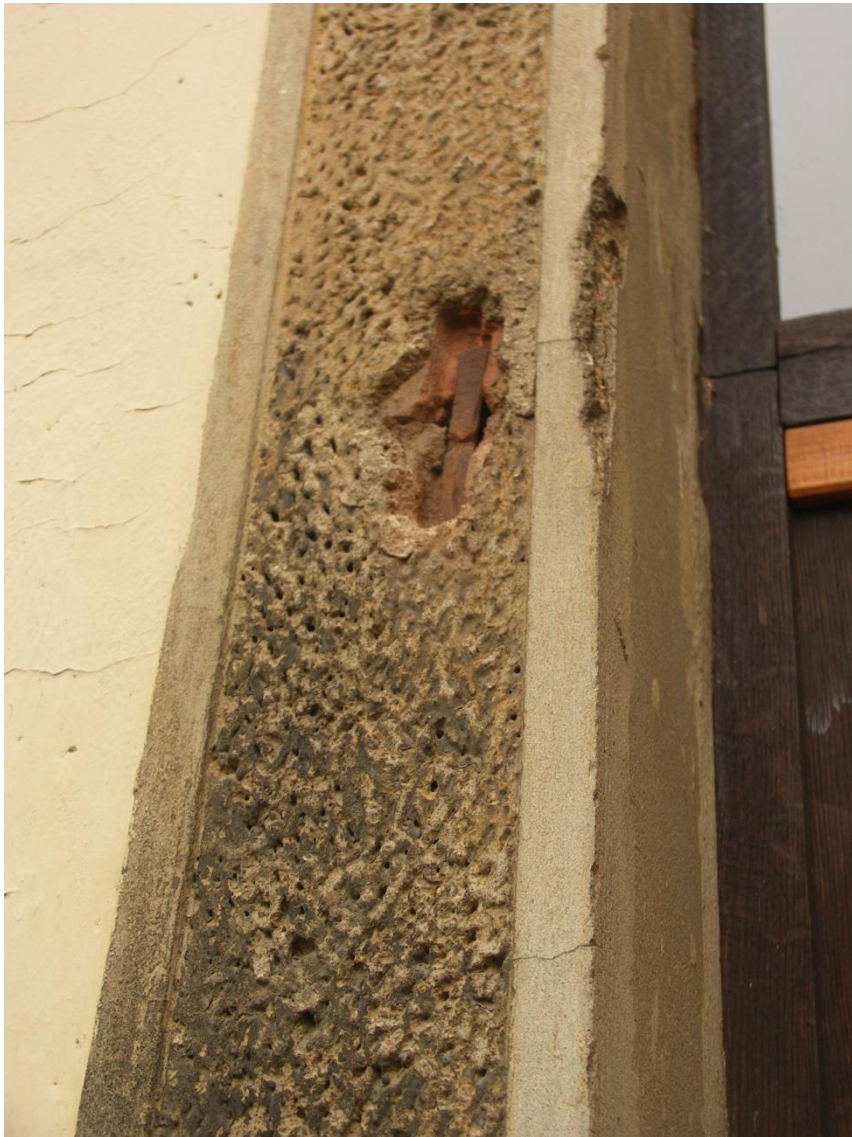
9. Fragment węgara z zaprawy cementowej.
