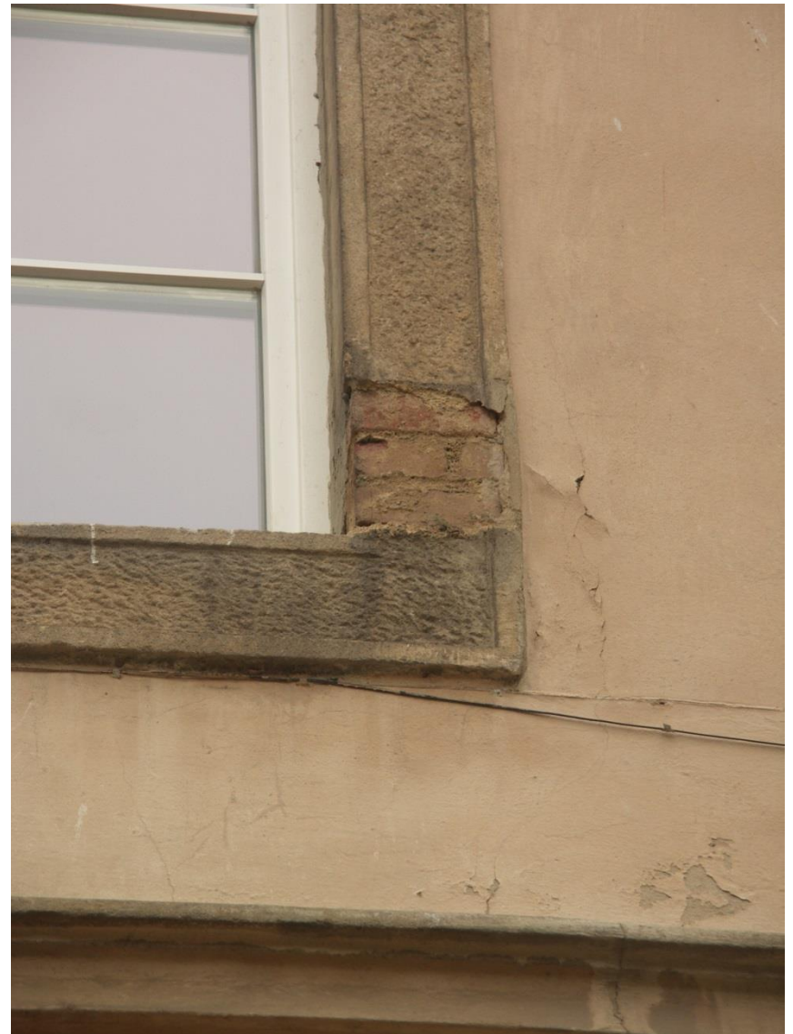
10. Fragment okna I piętra. Uzupełnienie obramienia cegłą.
