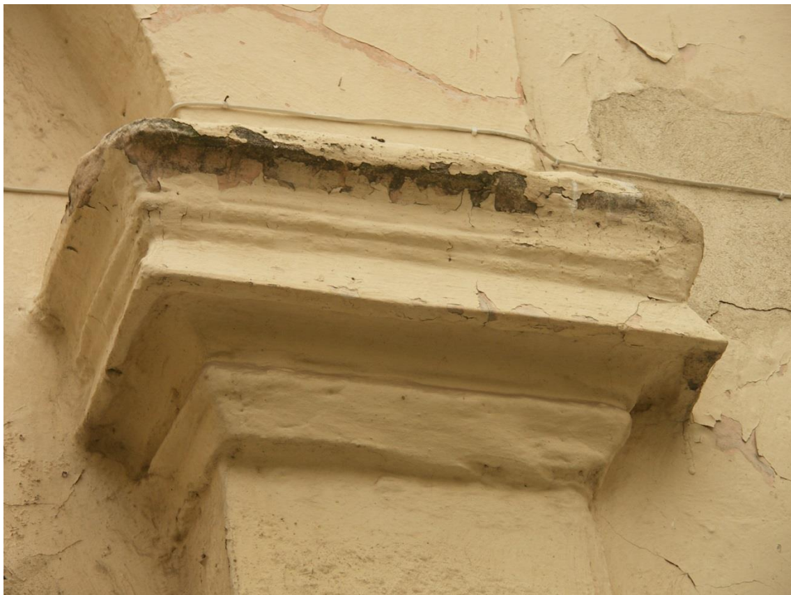
15. Impost z piaskowca. Powierzchnia zakryta farbami. Liczne uszkodzenia mechaniczne.
