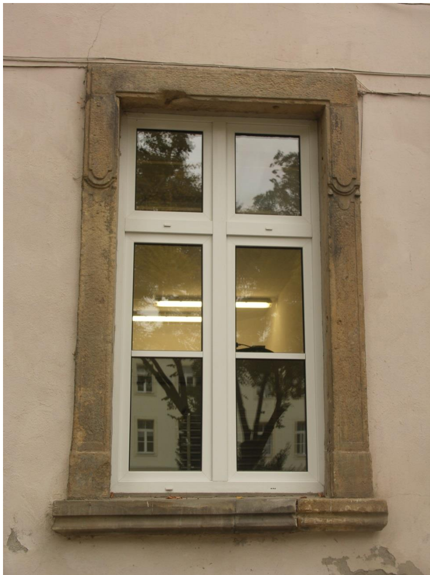
3. Okno budynku nr 5. Parapet uzupełniony innym kamieniem.
