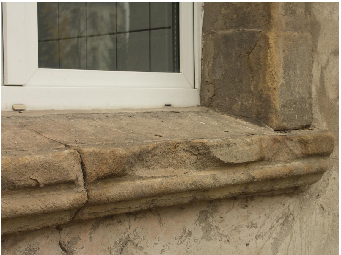
5. Parapet okna – budynek nr 5. Liczne ubytki mechaniczne. Parapet z wyrobionym spadem z betonu.
