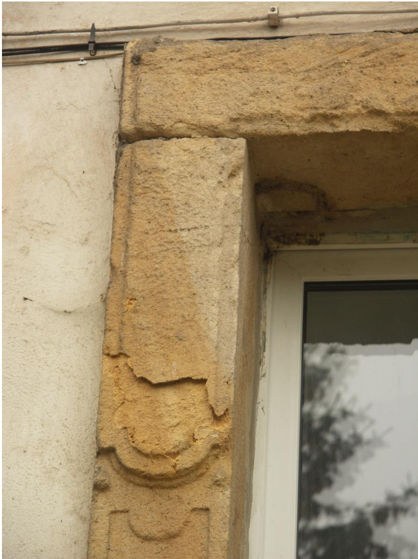
13. Fragment obramienia okiennego. Korozja strukturalna piaskowca.
