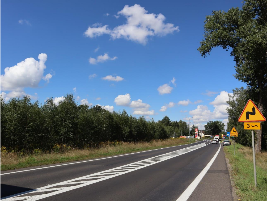
Fot. 7.6. Zadrzewienia w rejonie km 25+800 m drogi krajowej nr 30 (strona południowo-zachodnia).
