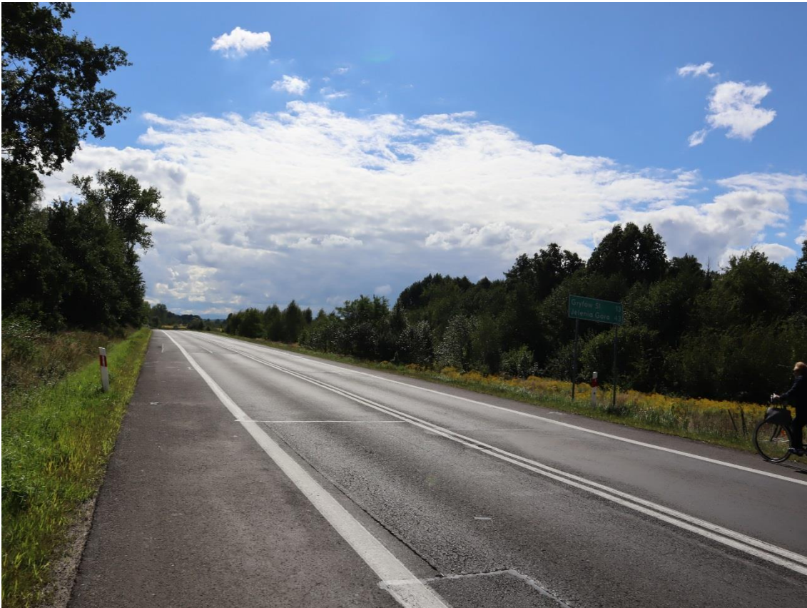
Fot. 7.7. Zadrzewienia w rejonie km 25+900 m drogi krajowej nr 30 (strona południowo-zachodnia).
