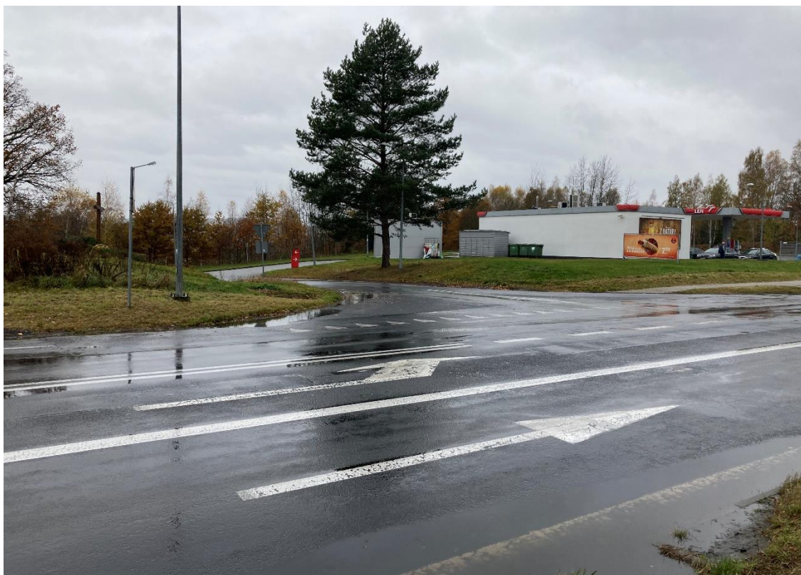
Fot. 6.2. Widok skrzyżowania drogi powiatowej nr 2242d z drogą krajową nr 30.
