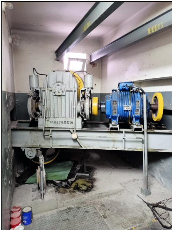
Widok maszynowni, zespół napędowy.
