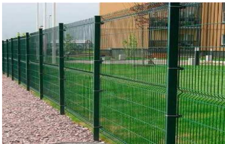
Ogrodzenie panelowe montowane na słupkach w fundamentach betonowych
