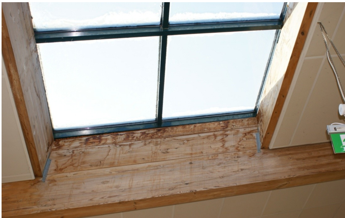
Rys. Świetlik nad widownią
