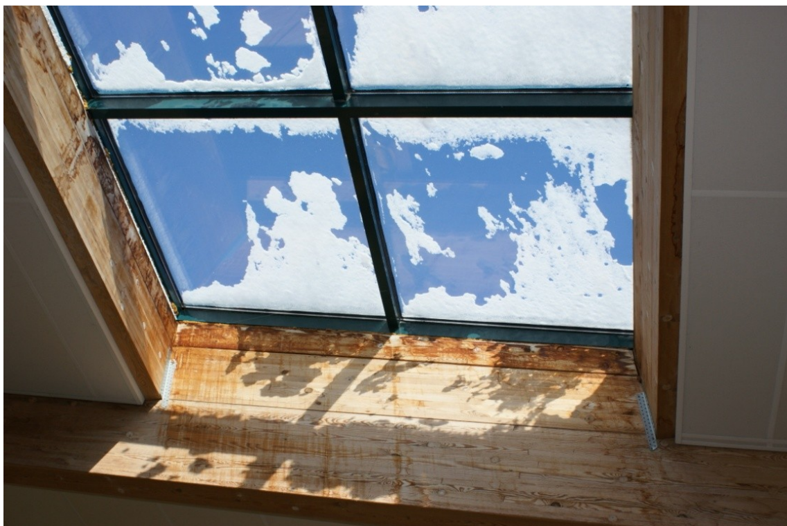
Rys. Świetlik nad widownią
