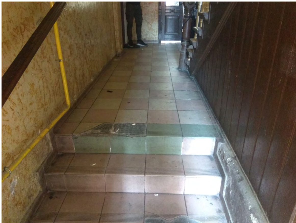
Widoczne ubytki płytek
