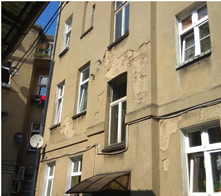
Widoczne ubytki na elewacji w podwórzu
