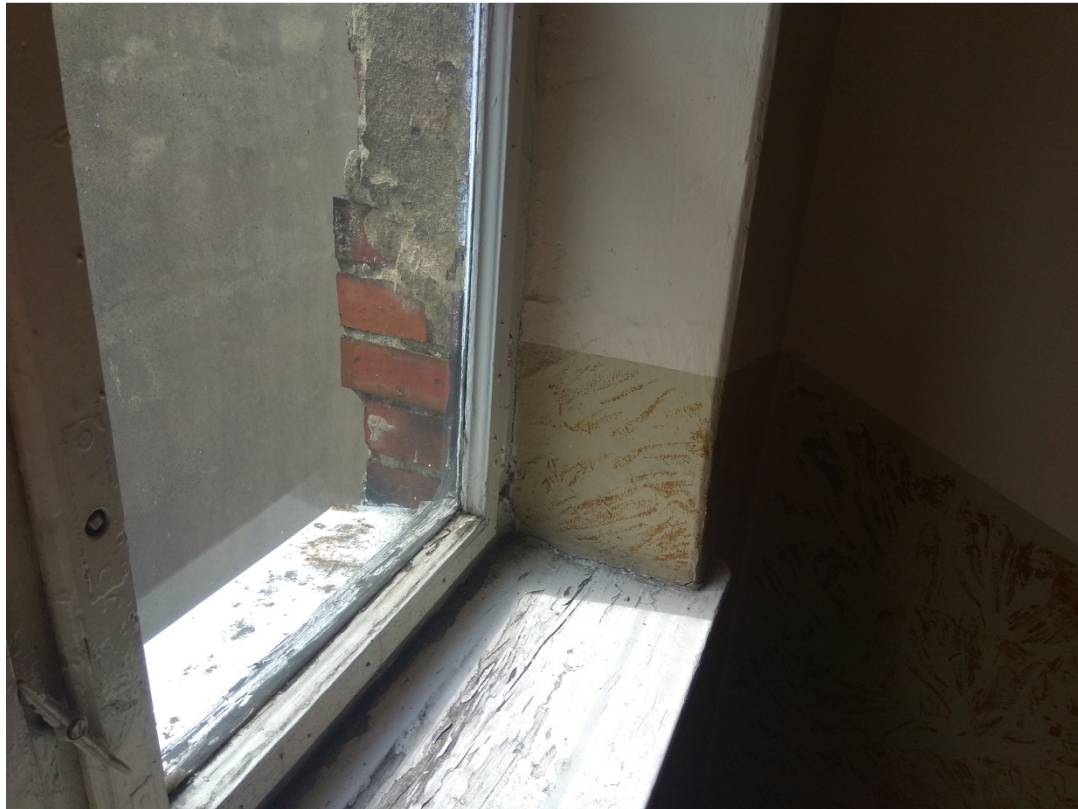
Zniszczone okno drewniane na klatce schodowej
