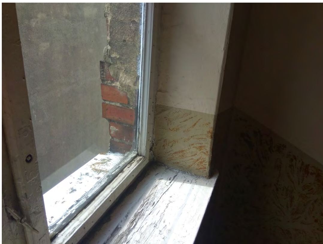
Zniszczone okno drewniane na klatce schodowej
