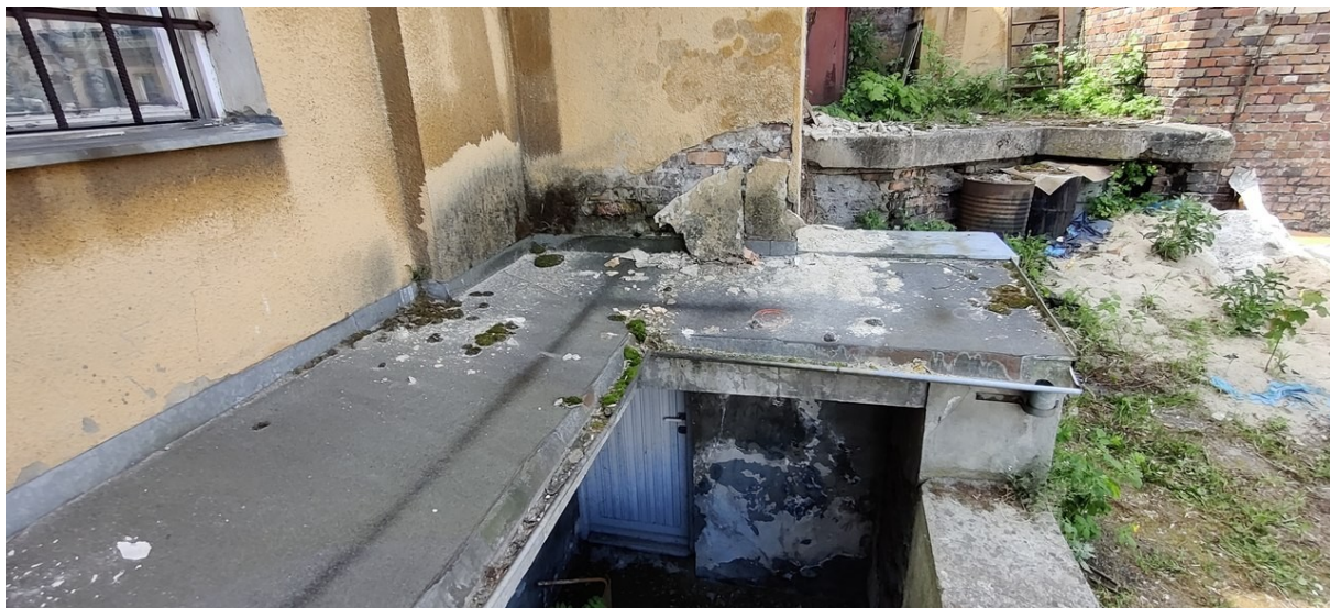
Zejsście do przegłębienia technologicznego od strony dziedzińca wewnętrznego.
