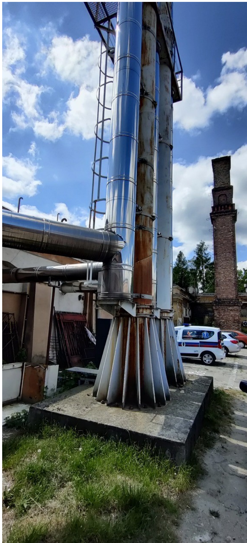
Fundament konstrukcji wsporczej kominów wolnostojących stalowych; w głębi widoczny komin murowany.
