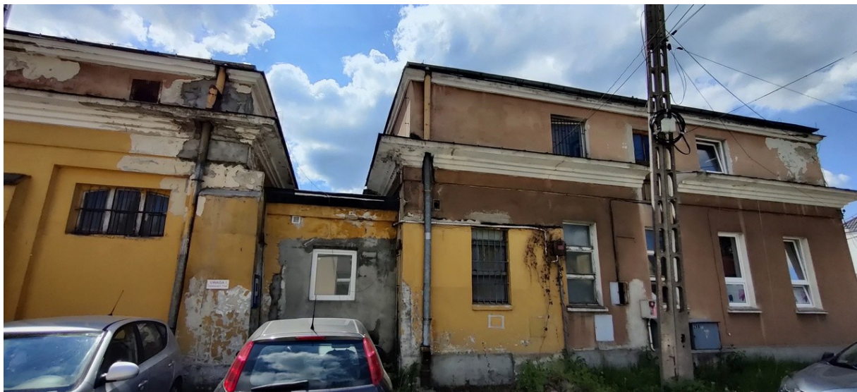
Elewacja północno-wschodnia; po prawej widoczny pawilon „I” nieobjęty rozbiórką.
