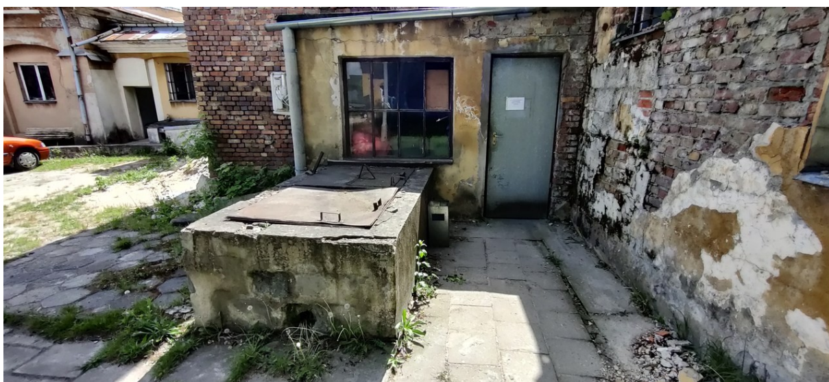
Przybudówka w rejonie komina murowanego od strony dziedzińca wewnętrznego.
