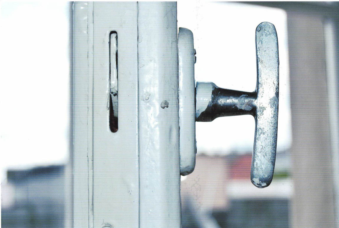
Fot. 16 Grudziądz, ul. Narutowicza 6 – Szkoła Podstawowa nr 3 im. J. Korczaka - okno TYP O/I – widok na okucie uchwytove, dwuramienną klameczkę
