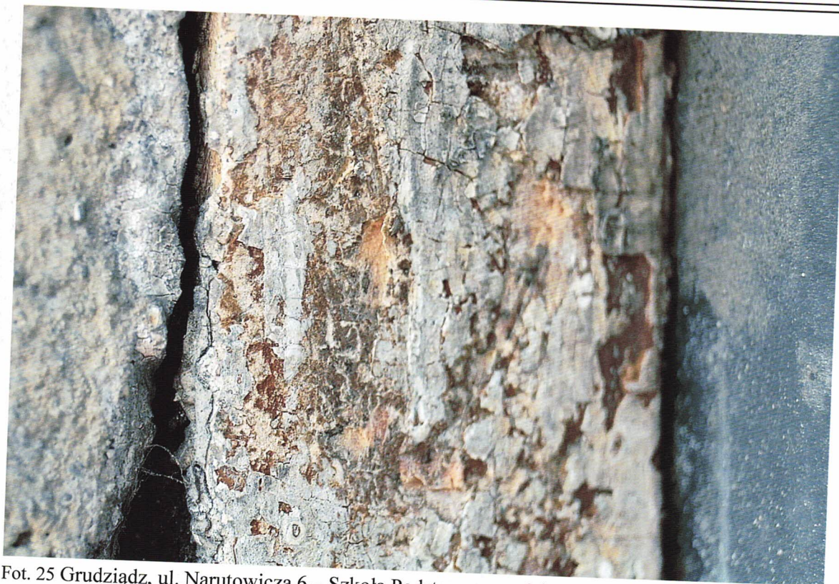
Fot. 24 Grudziądz, ul. Narutowicza 6 – Szkoła Podstawowa nr 3 im. J. Korczaka - widok na warstwy malarskie pierwotnej stolarki okiennej
