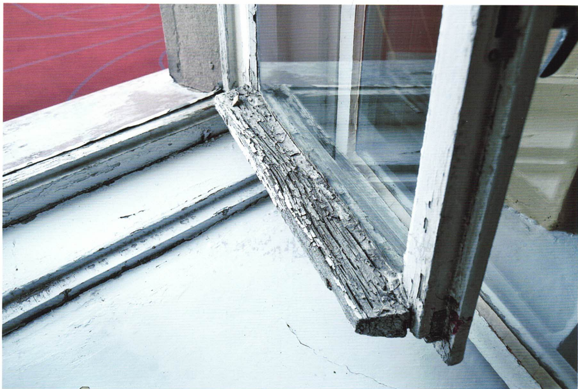
Fot. 13 Grudziądz, ul. Narutowicza 6 – Szkoła Podstawowa nr 3 im. J. Korczaka - okno TYP O/I – widok na fragment skrzynki, skrzydeł okiennych oraz parapetów
