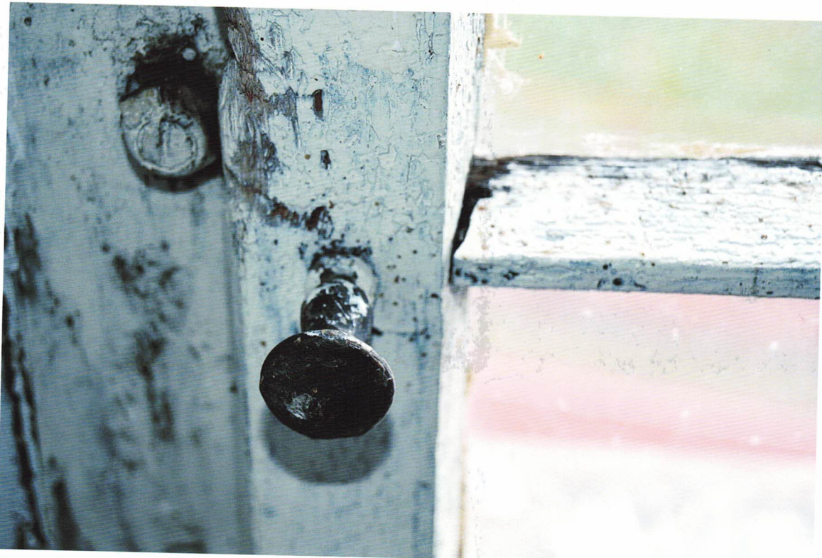
Fot. 23 Grudziądz, ul. Narutowicza 6 – Szkoła Podstawowa nr 3 im. J. Korczaka - widok na fragment skrzydła okiennego oraz gałeczkę okienną pierwotnej stolarki okiennej
