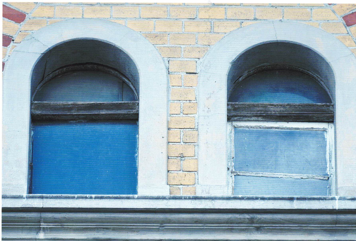
Fot. 18 Grudziądz, ul. Narutowicza 6 – Szkoła Podstawowa nr 3 im. J. Korczaka - widok na pierwotną stolarkę okienną zachowaną w ścinie kolankowej elewacji wschodniej Fot.. Ewa Bożejewicz 2021 r.
