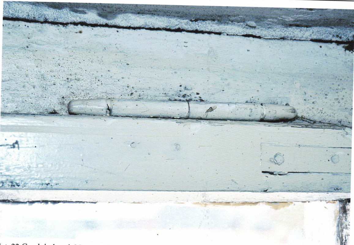
Fot. 22 Grudziądz, ul. Narutowicza 6 – Szkoła Podstawowa nr 3 im. J. Korczaka - widok na zawias czopowy pierwotnej stolarki okiennej
