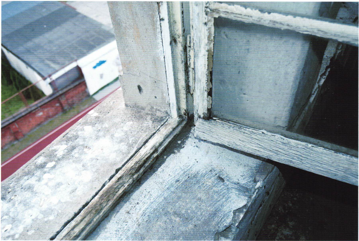
Fot. 20 Grudziądz, ul. Narutowicza 6 – Szkoła Podstawowa nr 3 im. J. Korczaka - widok na fragment krosna i skrzydła okiennego pierwotnej stolarki okiennej
