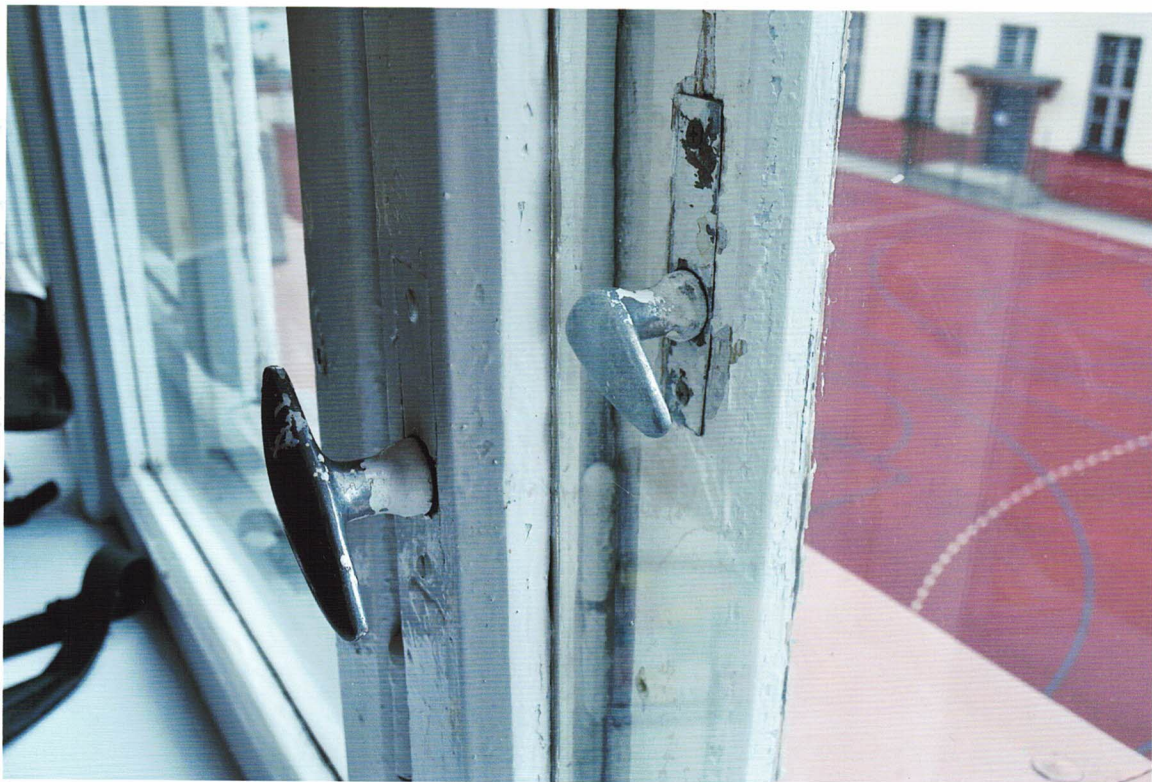
Fot. 15 Grudziądz, ul. Narutowicza 6 – Szkoła Podstawowa nr 3 im. J. Korczaka - okno TYP O/I – widok na okucie uchwytowe, dwuramienną i jednoramienną klameczkę
