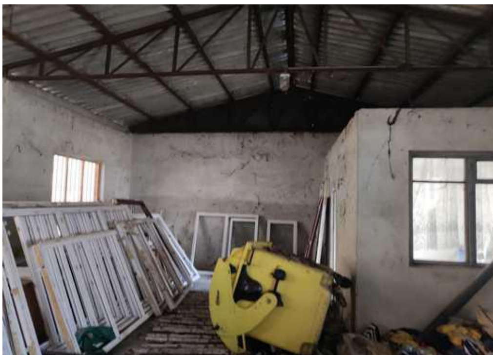
Zdjęcie nr 13. Budynek magazynowy.
