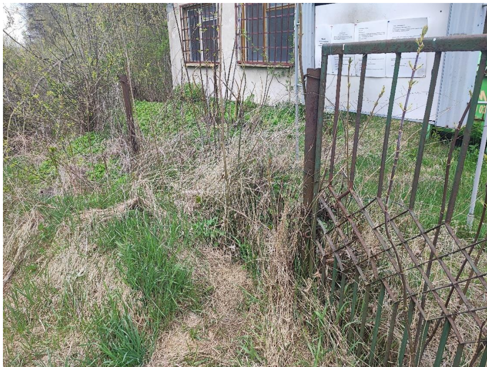
Zdjęcie nr 16. Ogrodzenie.
