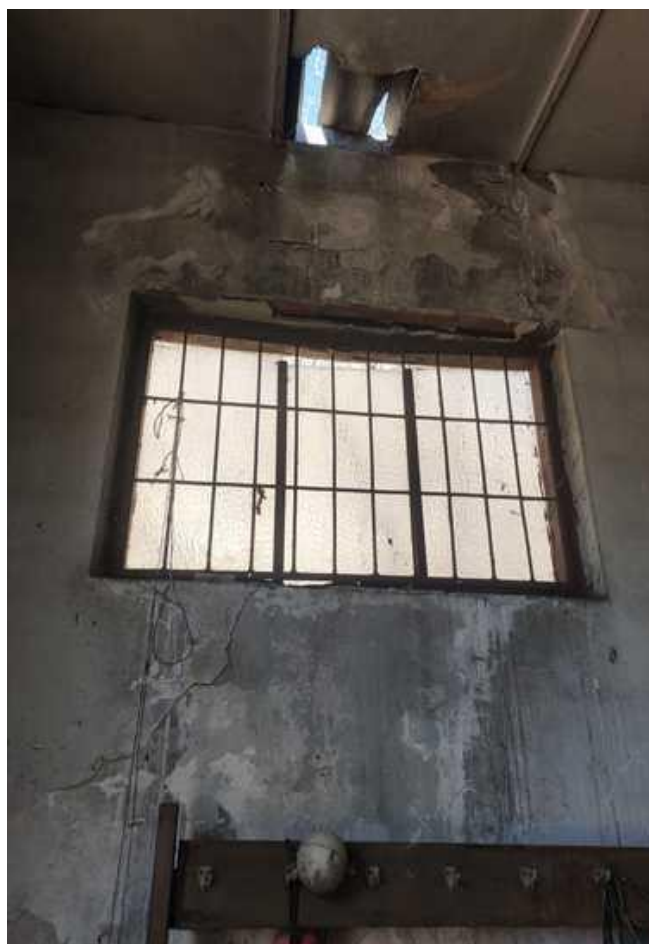
Zdjęcie nr 11. Budynek magazynowy.
