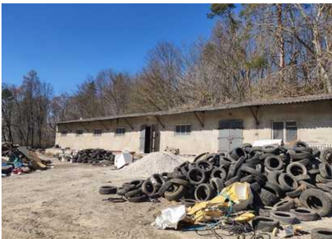
Zdjęcie nr 7. Budynek magazynowy, plac.
