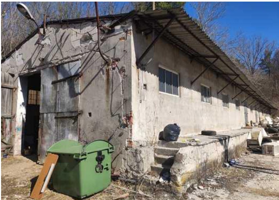
Zdjęcie nr 8. Budynek magazynowy.
