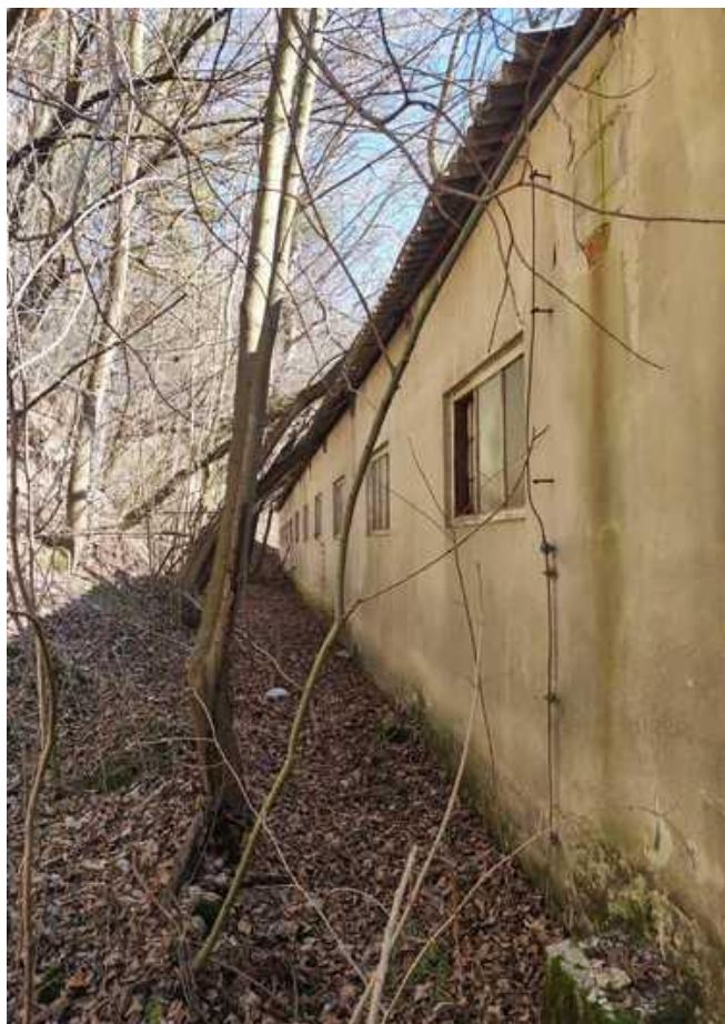
Zdjęcie nr 12. Budynek magazynowy – strona północna.
