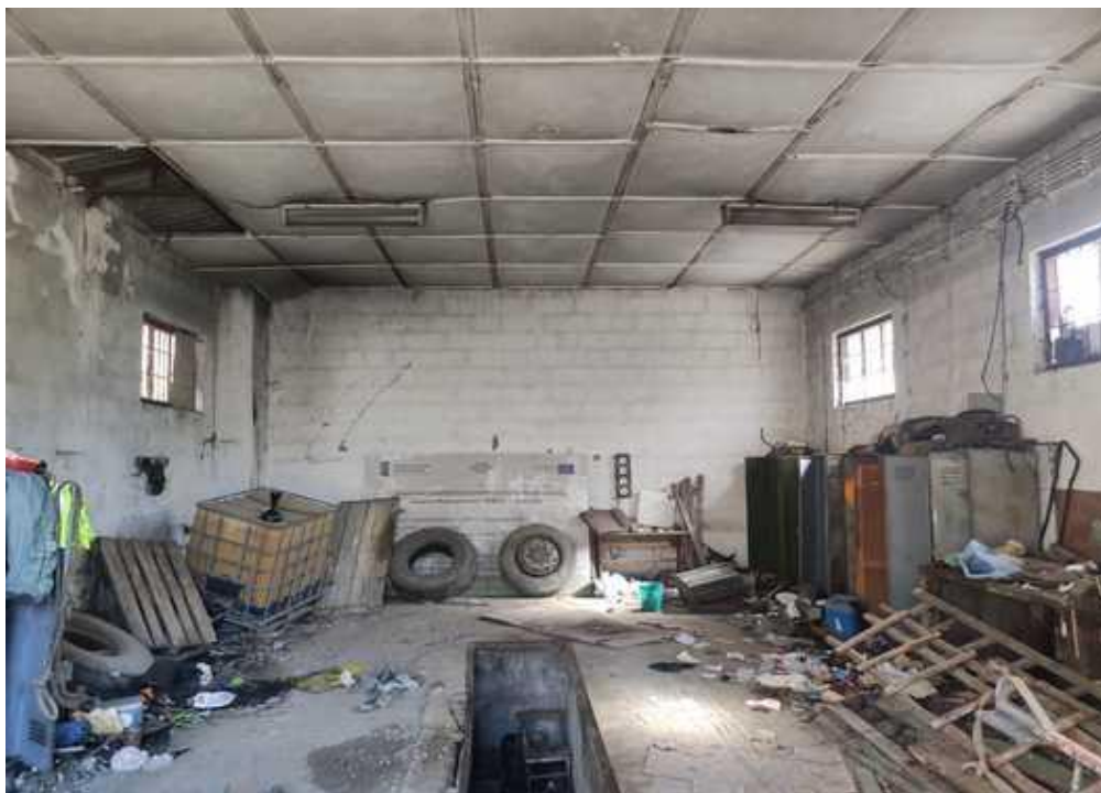
Zdjęcie nr 10. Budynek magazynowy.
