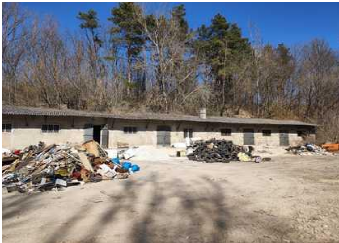
Zdjęcie nr 6. Budynek magazynowy, plac.
