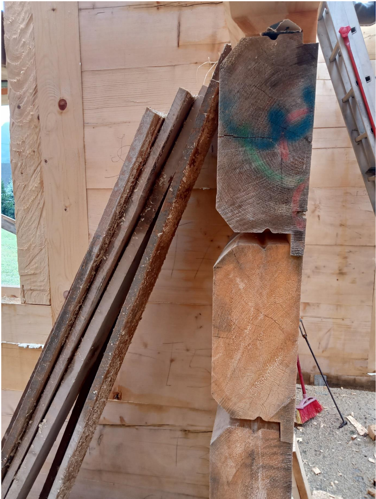
Fotografia nr 5 Płazy z wewnętrznym czopem
