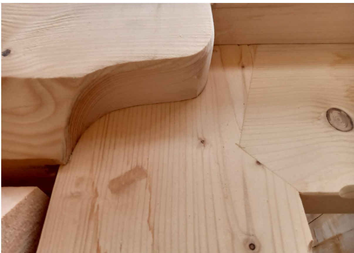
Fotografia nr 3 Widok elementu pokazanego na fotografii nr 2 z zewnątrz
