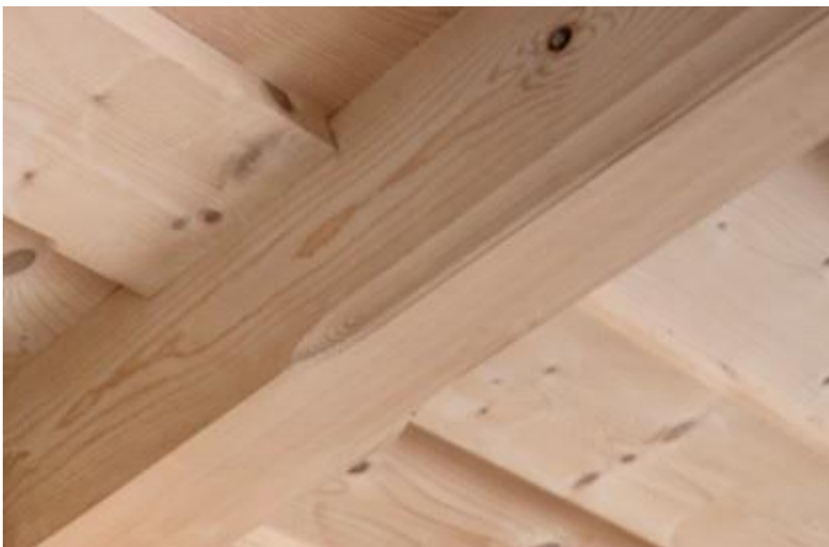
Fotografia nr 8 Połączenie stropu z belką stropową oraz zdobienie „fazowanie” belki „Tragarza”
