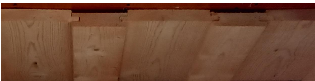
Fotografia nr 7 Strop „Powąła na zakład”
