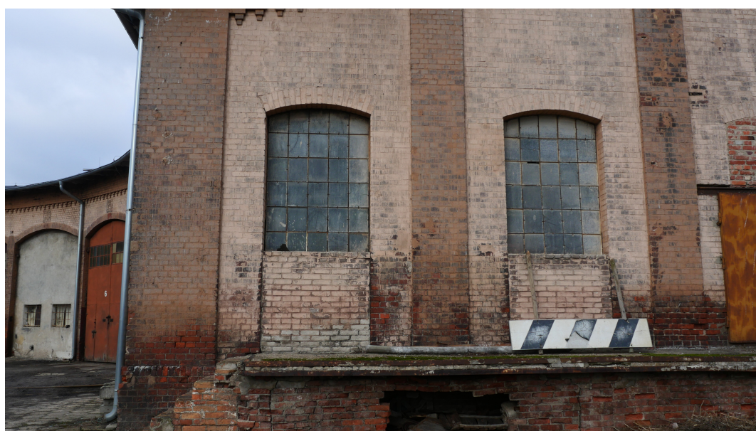
Foto 5: Widok elewacji południowej
