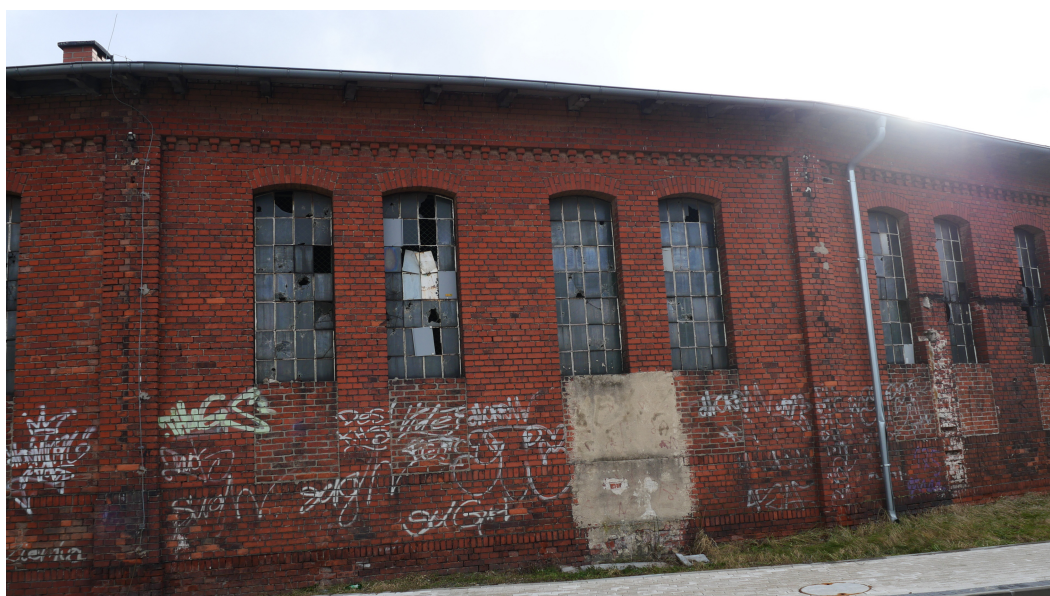
Foto 2: Widok elewacji - północnej
