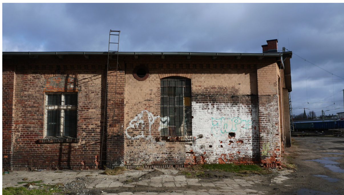
Foto 3: Widok elewacji - zachodniej
