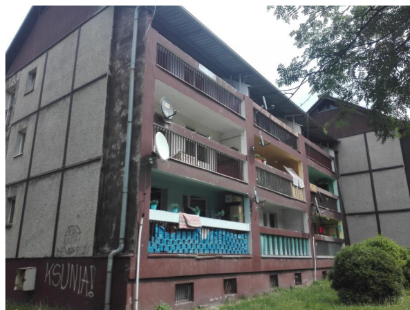
Fot.4 Fragment elewacji południowo-zachodniej
