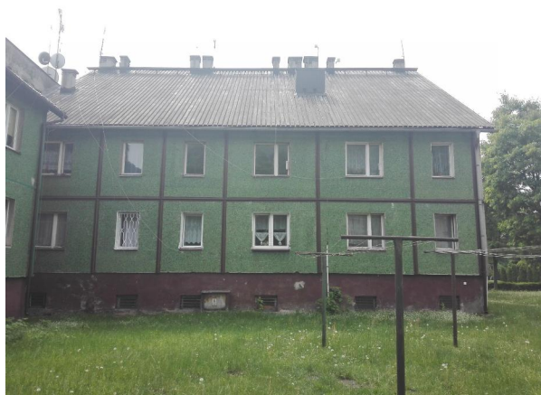
Fot.1 Fragment elewacji północno-wschodniej
