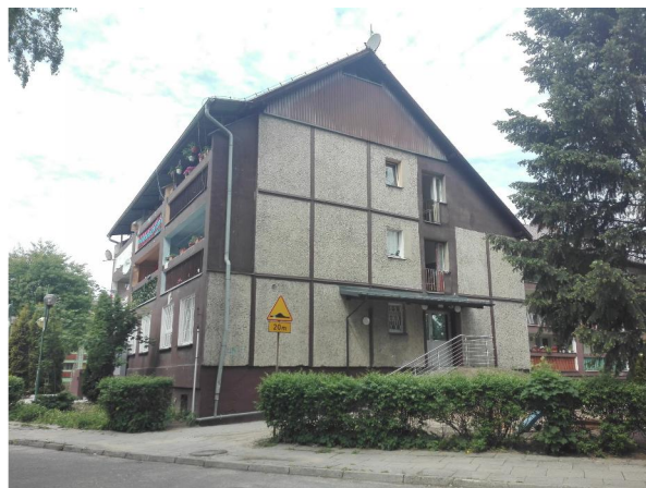
Fot.2 Fragment elewacji południowo-wschodniej
