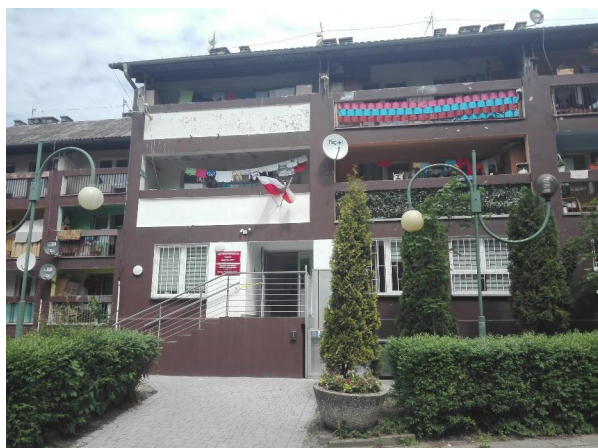
Fot.3 Fragment elewacji południowo-zachodniej
