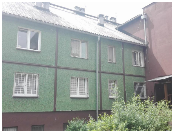
Fot.6 Fragment elewacji północno-wschodniej
