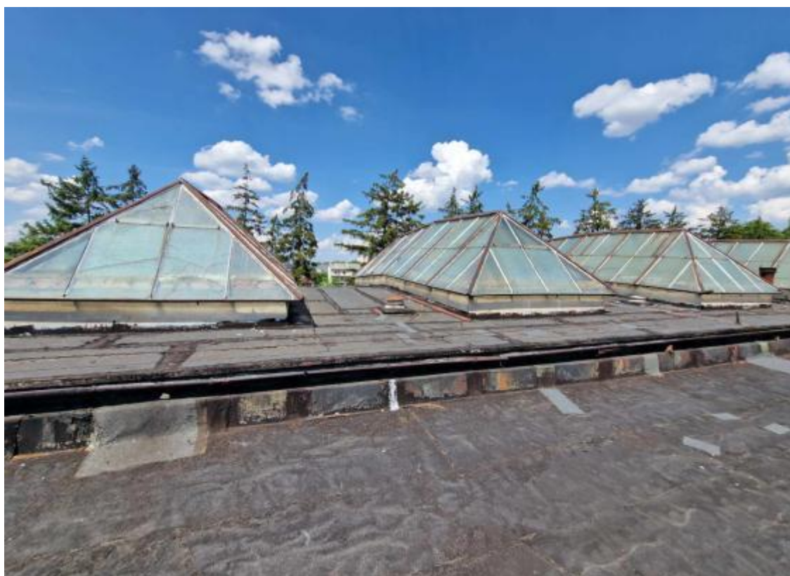
Fot. 15. Świetliki dachowe do wymiany.
