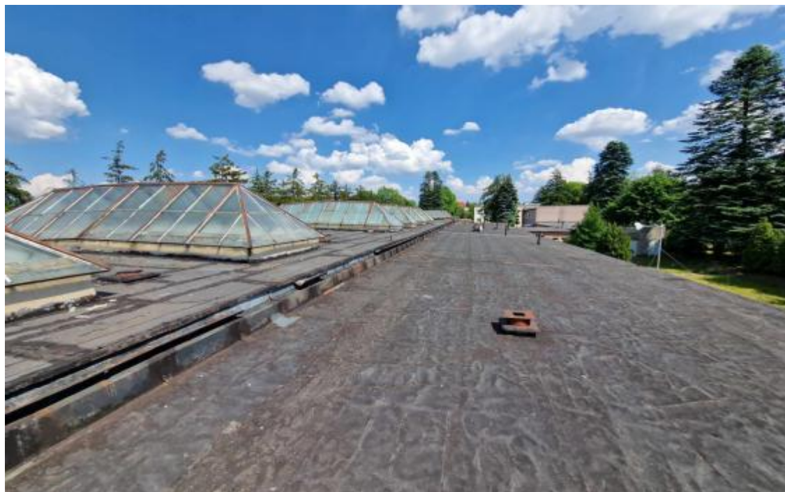
Fot. 13. Dach wraz ze świetlikami do remontu i wymiany .
