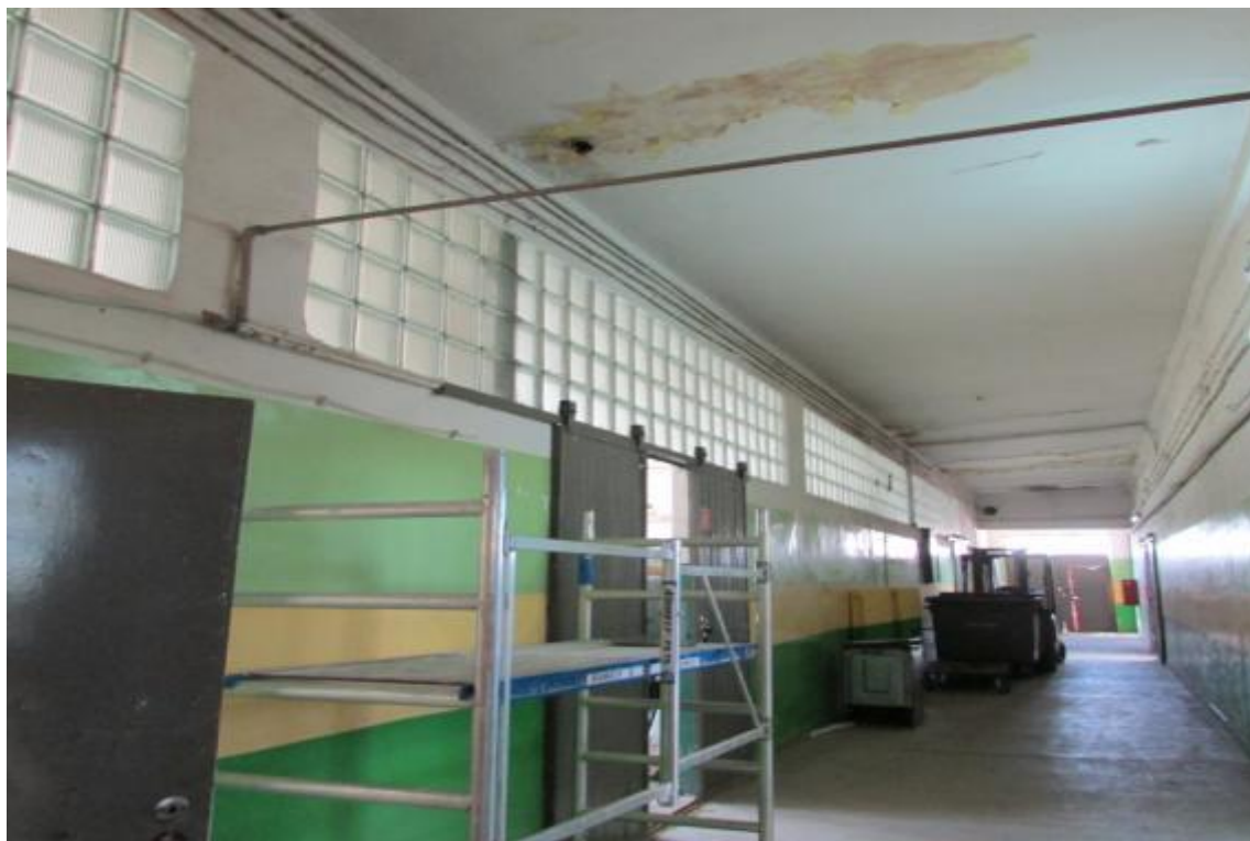
Fot. 12. Luksfery do wymiany na naświetla okienne.
