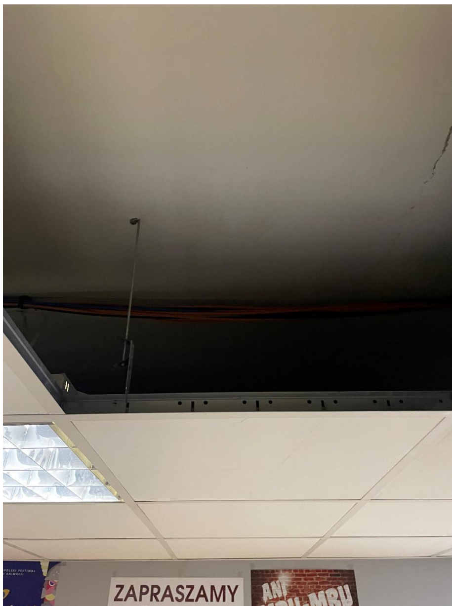
Mocowanie sufitu podwieszanego
