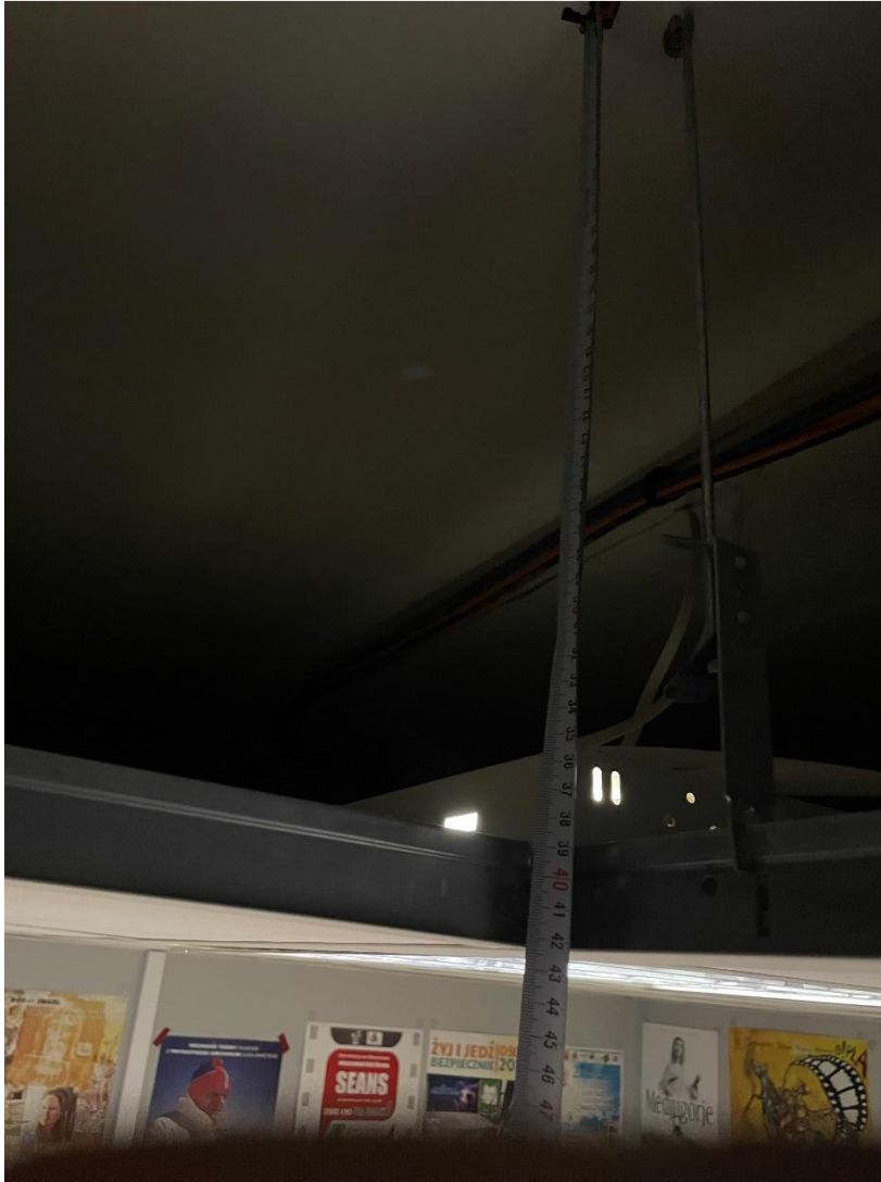
Wysokość od sufitu podwieszanego do poziomu stropu konstrukcyjnego
