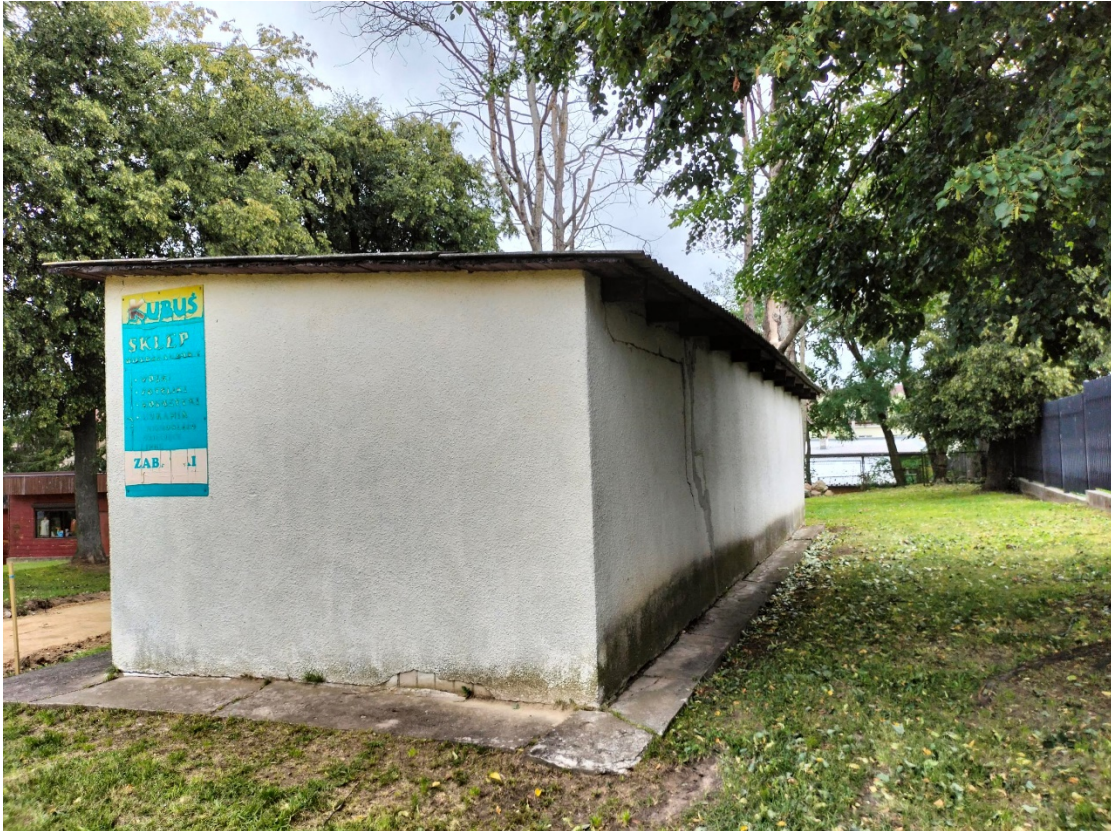
(Fot. 2 Budynek do remontu)
