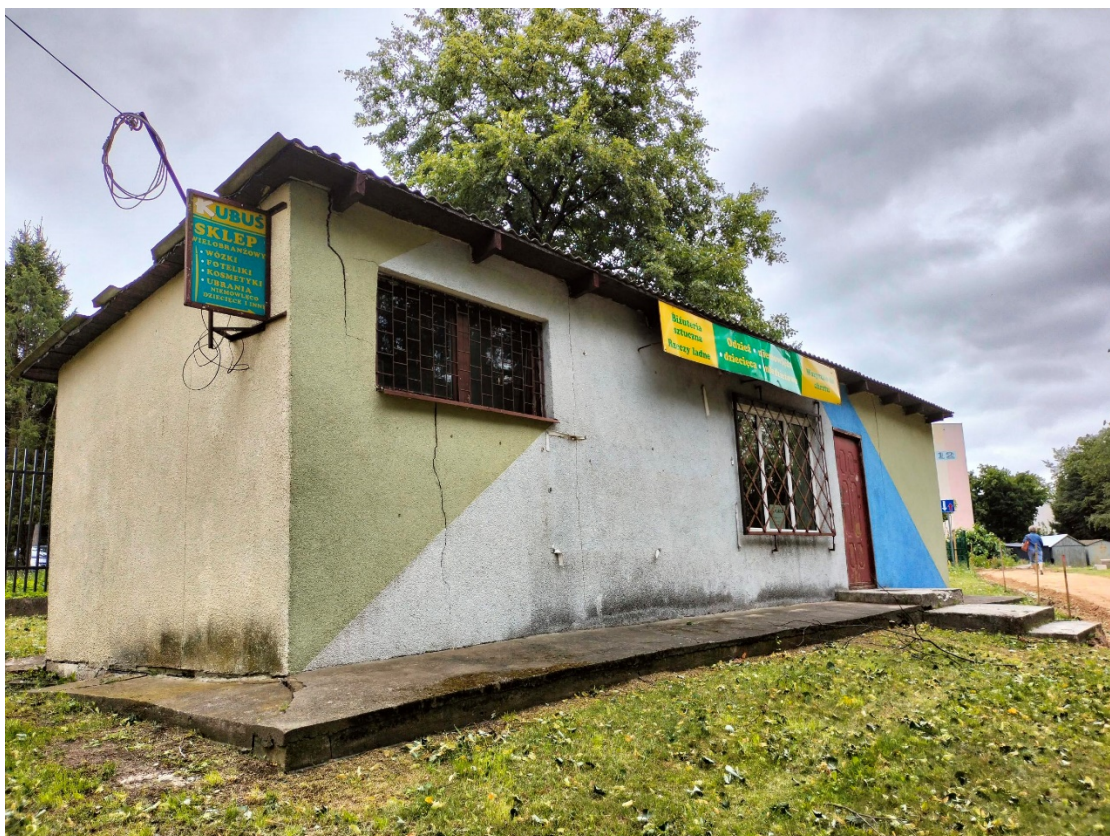
(Fot. 1 Budynek do remontu)
