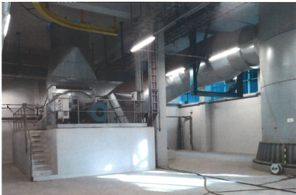
Rysunek 4 Istniejące połączenie wentylatora wyciągowego z kominem
