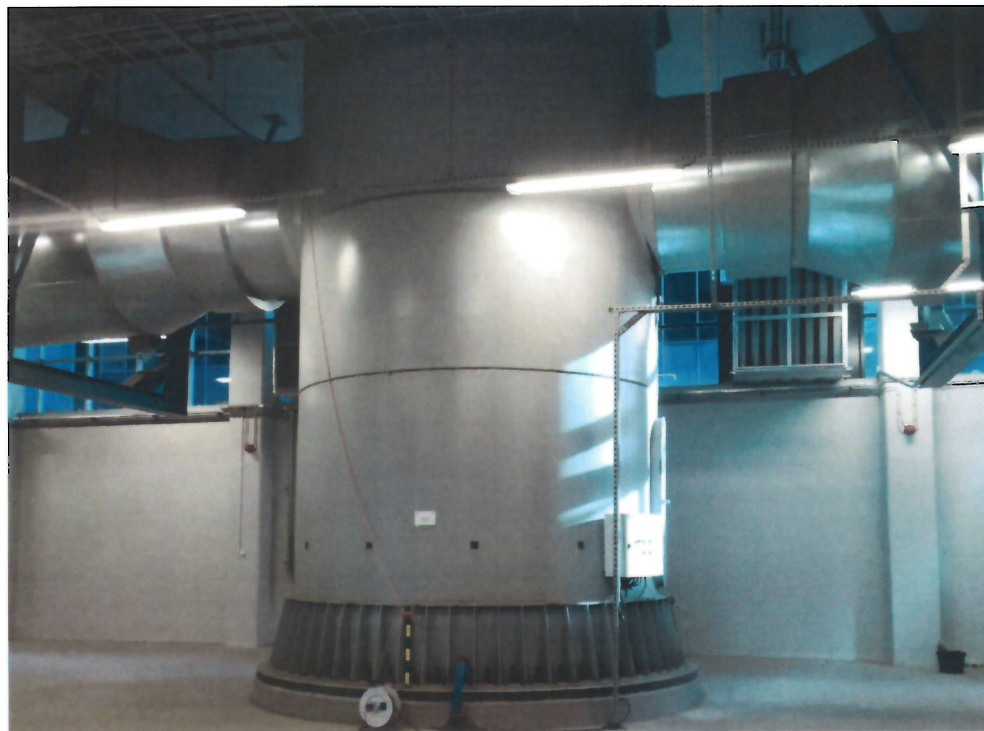
Rysunek 5 Istniejące połączenie kanałów spalin z kominem
