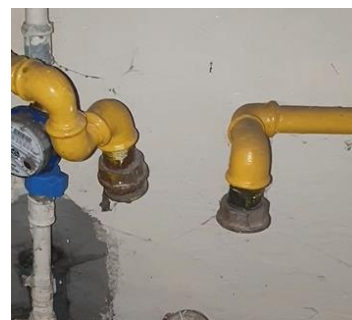
Podejście pod gazomierz – klatka schodowa
