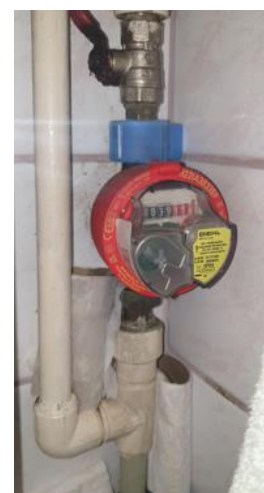
Wodomierz/ pion wodociągowy - łazienka
