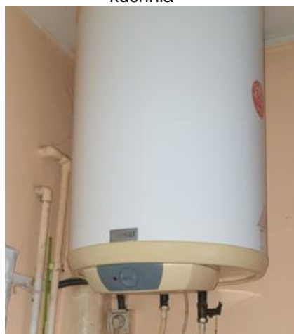
Elektryczny podgrzewacz c.w.u. - kuchnia
