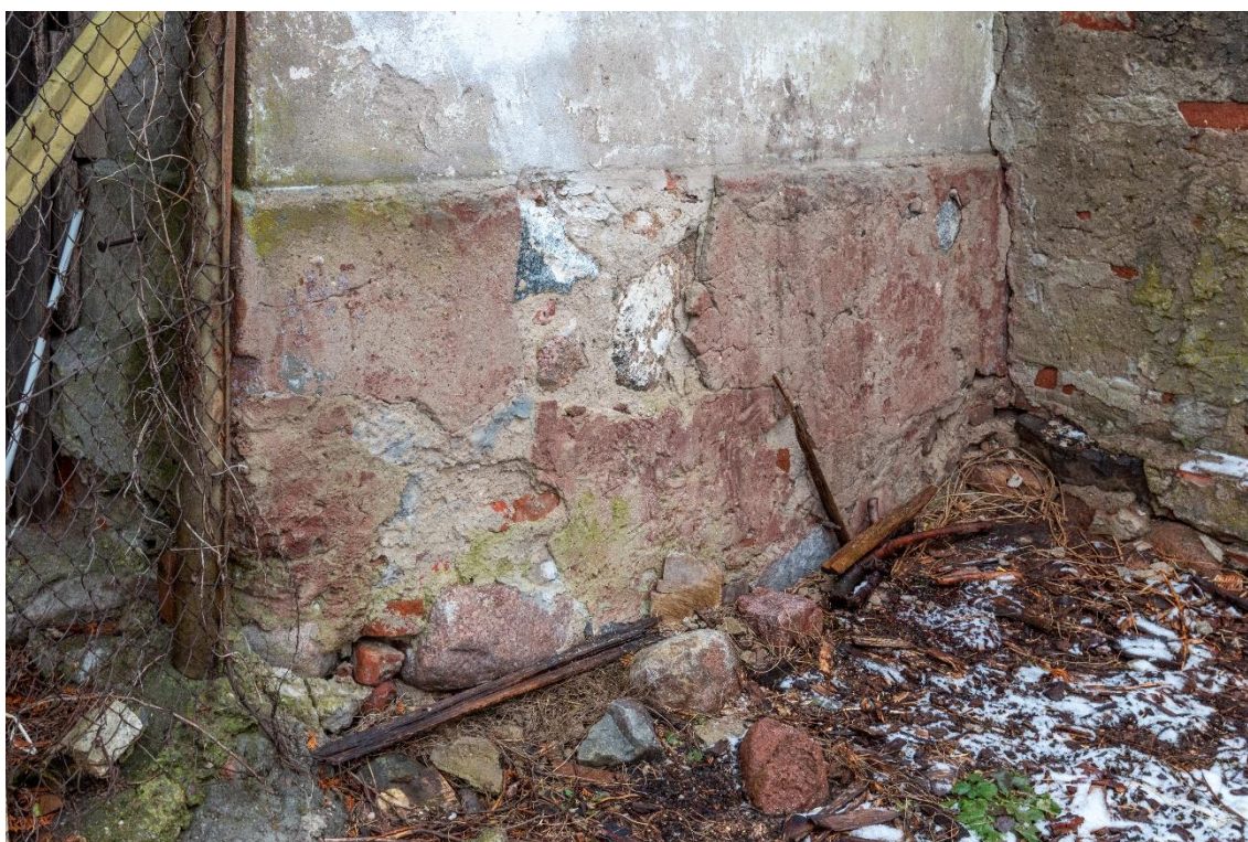
Fot. 31. Elewacja boczna, południowo-zachodnia, prawy, południowy narożnik. W tej części budynku ze względu na ukształtowanie terenu cokół jest wyższy. Pod wtórnym tynkiem widoczny jest wążek kamienny.
