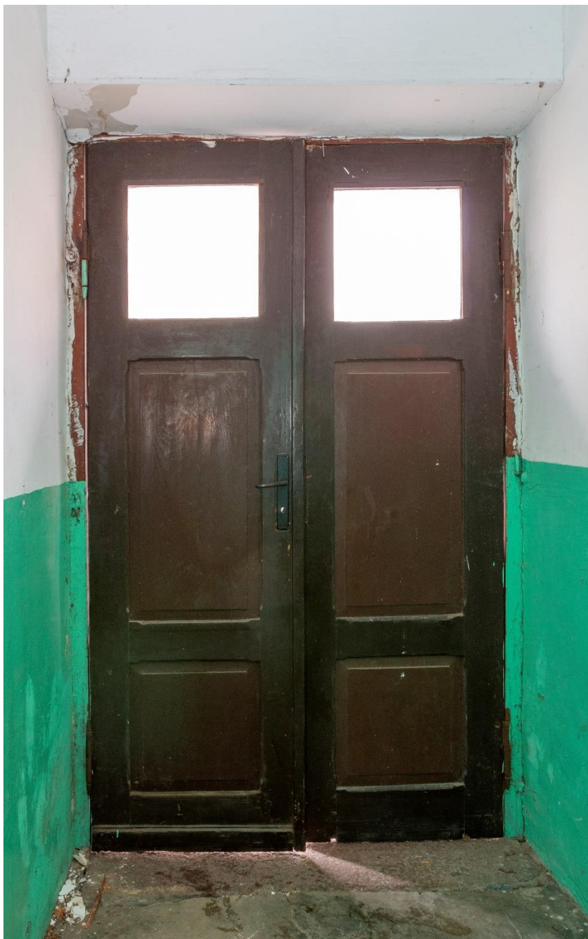
Fot. 27. Drzwi od strony wnętrza. Niewykluczone, że w zabudowie powyżej nadproża w przeszłości umieszczona była skrzynka na roletę, którą zabezpieczano drzwi mieszczącego się na parterze sklepu lub zakładu rzemieślniczego. Powłoka malarska jest cienka, na powierzchni drzwi czytelne jest usłojenie drewna.
