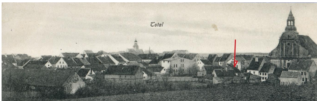
Fot. 1. Fotografia panoramy Bisztynka z początku XX w. Strzałką zaznaczono dach budynku przy ul. Kościelnej 33, jeszcze bez lukarny. Źródło:
