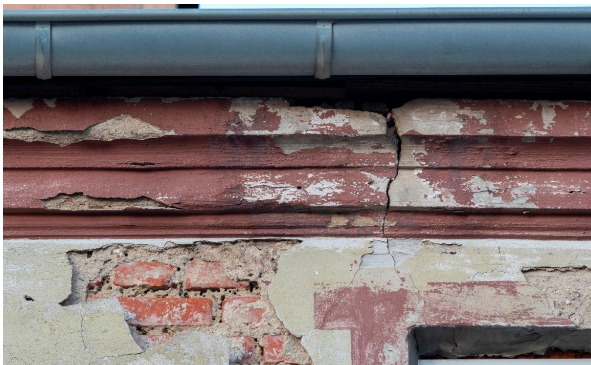
Fot. 24. Fragment gzymsu wieńczącego lukarnę w elewacji południowo-zachodniej. Profil inny niż na zachowanym fragmencie gzymsu poniżej, lepiej zachowany, najprawdopodobniej wykonany został w trakcie budowy lukarny później niż pozostałe elementy dekoracji elewacji, jednak przed 1945 r.
