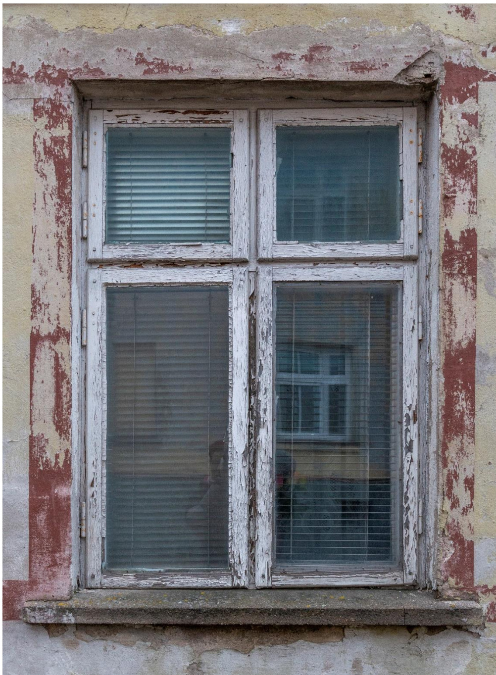
Fot. 25. Okno w elewacji frontowej po prawej stronie drzwi wejściowych. Wszystkie okna na parterze mają konstrukcję polską, jednak sposób wykonania oraz forma klamek i zawiasów (analogiczna do elementów zaobserwowanych na poddaszu) mogą dowodzić, iż stolarka została wykonana po wojnie (na wzór starych okien, w sposób najtańszy i najprostszy).
