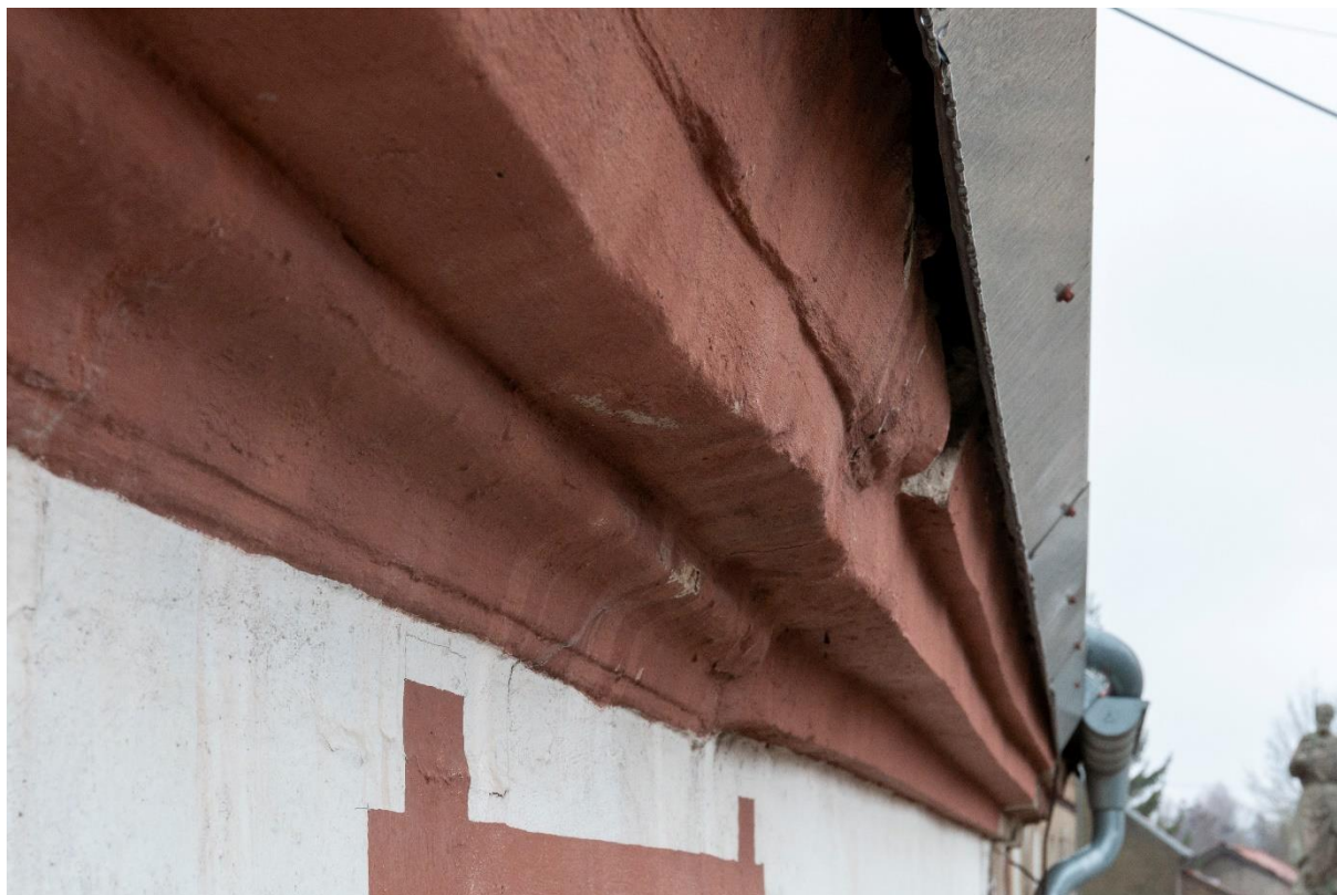
Fot. 23. Gzyms podokapowy na elewacji bocznej, południowo-zachodniej. Po lewej stronie zachował się fragment oryginalnego profilu. W dalszej części (po prawej stronie elewacji, a na fotografii w głębi) pierwotny profil (tzw. ciągniony) usunięto. Otynkowane zostały trzy rzędy cegieł, które stanowiły podłoże pod rdzeń profilu.
