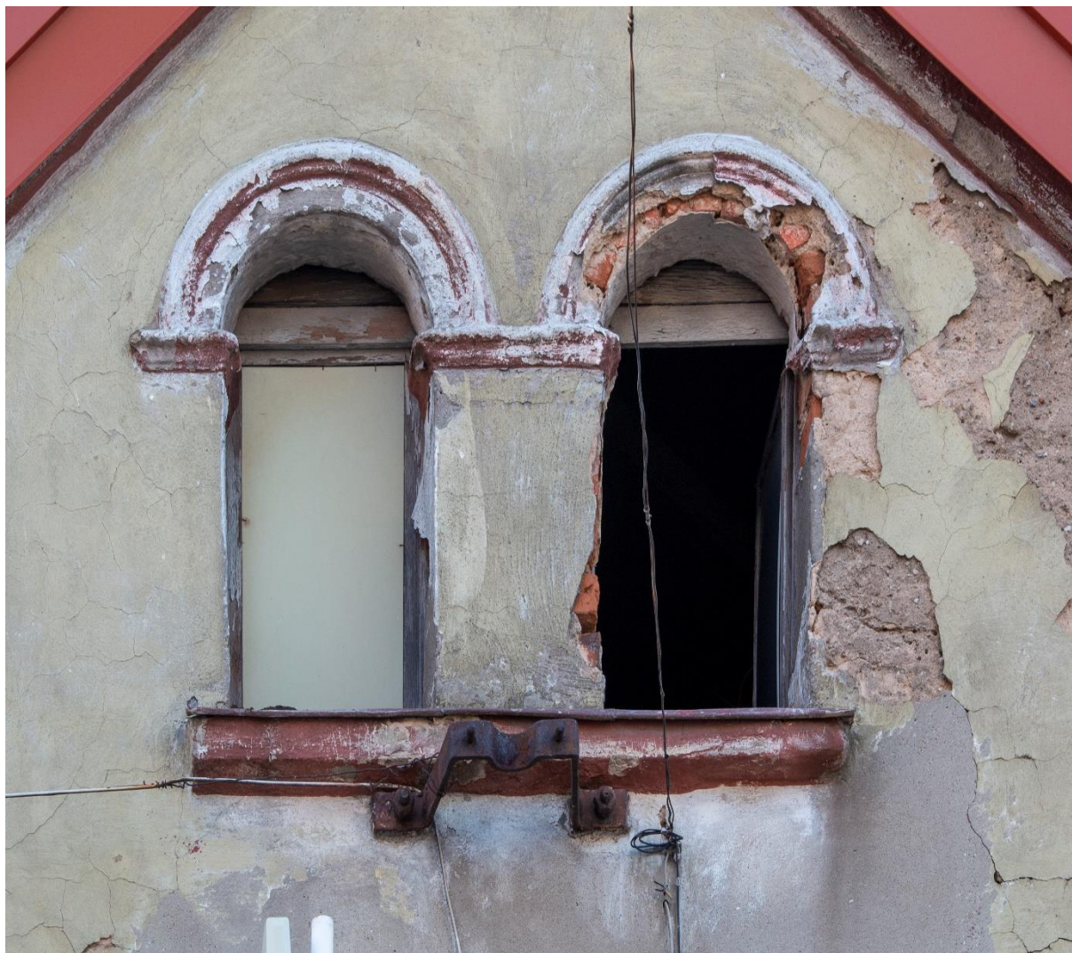
Fot. 12. Okna na poddaszu elewacji frontowej. Profilowane opaski otaczały także otwory na pierwszym piętrze. Forma gzymsu parapetowego jest zniekształcona, jednak obserwacja najprawdopodobniej pierwotna, co potwierdza analiza archiwalnej fotografii. Stolarka jest wtórna, skrzydła prostokątne. Górna, zamknięta łukiem część otworu została zaślepiona. Od strony wnętrza drewno nie zostało pomalowane.
