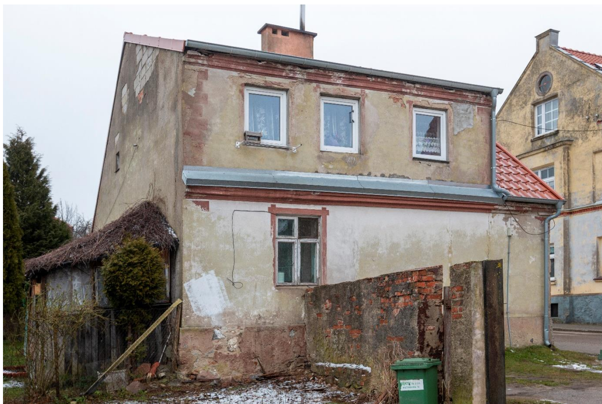
Fot. 7. Elewacja boczna, południowo-zachodnia oraz fragment elewacji podwórzowej. Mur zamykający podwórze nie jest przewiązany ze ścianą. Lukarna jest najprawdopodobniej późniejsza niż zasadnicza bryła budynku, jednak profil gzymsu dowodzi, że powstała jeszcze przed 1945 rokiem. Współcześnie naprawiane gzymsy podokapowe wykonano bez szablonu, otynkowano jedynie wymurowane schodkowo cegły, które pierwotnie służyły do osadzenia rdzenia profilu.
