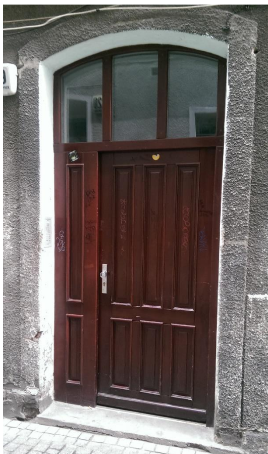
il.10 wejście główne do budynku
