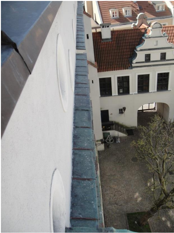
Brak osłon z blachy na prętach - dolny poziom ściany pd ,skrzydło zachodnie
