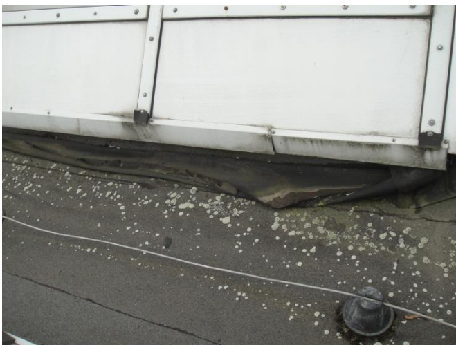
Odklejone gumy na świetlikach skrzydła zachodniego
