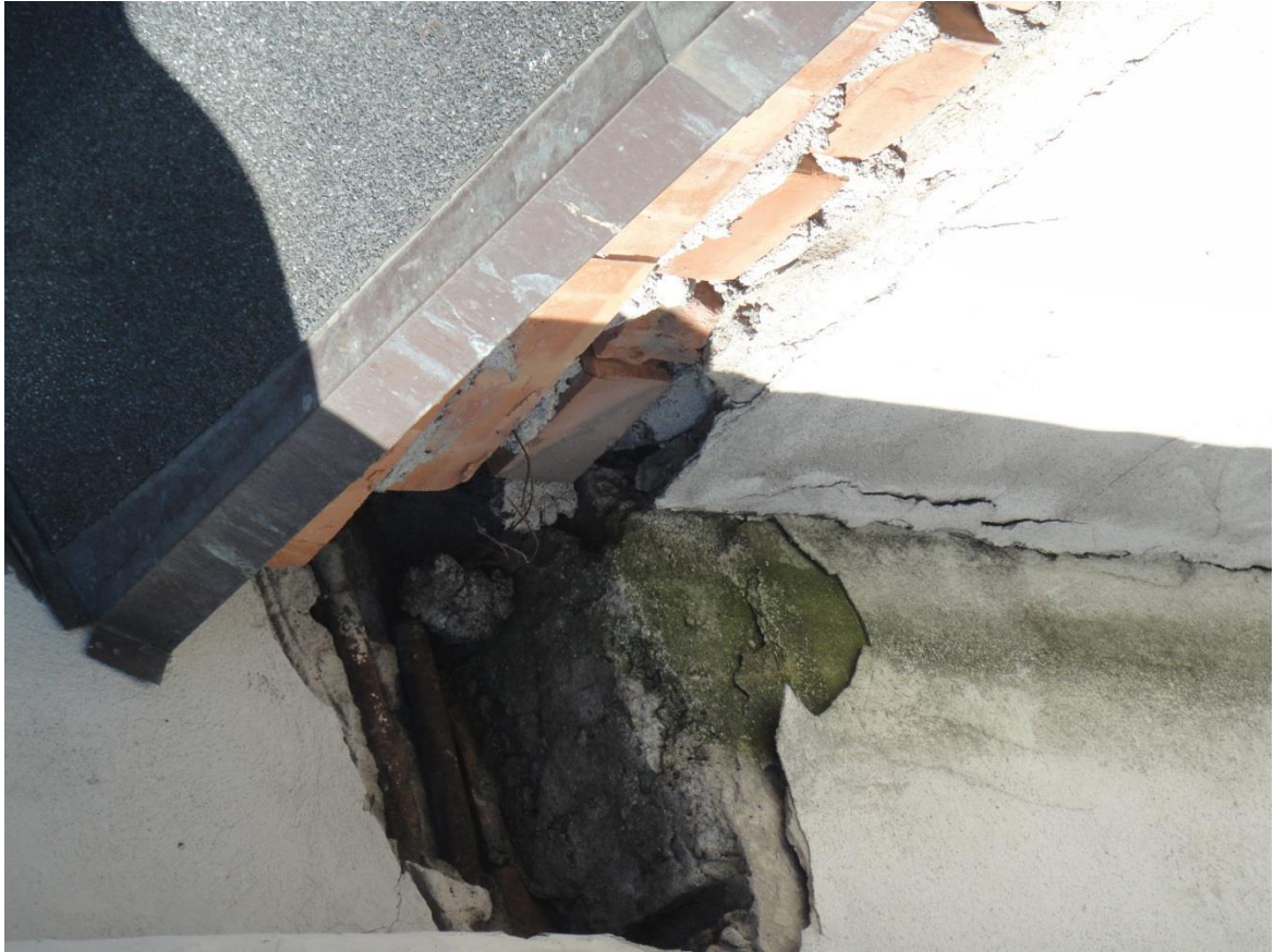
Widoczne zbrojenie na połączeniu skrzydła wschodniego z Operą
