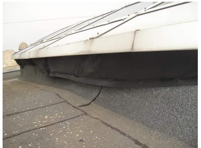
Odklejone gumy na świetlikach skrzydła zachodniego
