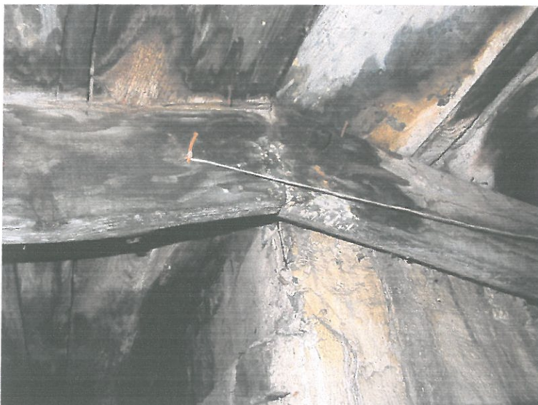
Widoczne zawilgocenia i zagrzybienie elementów konstrukcyjnych oraz odeskowania
