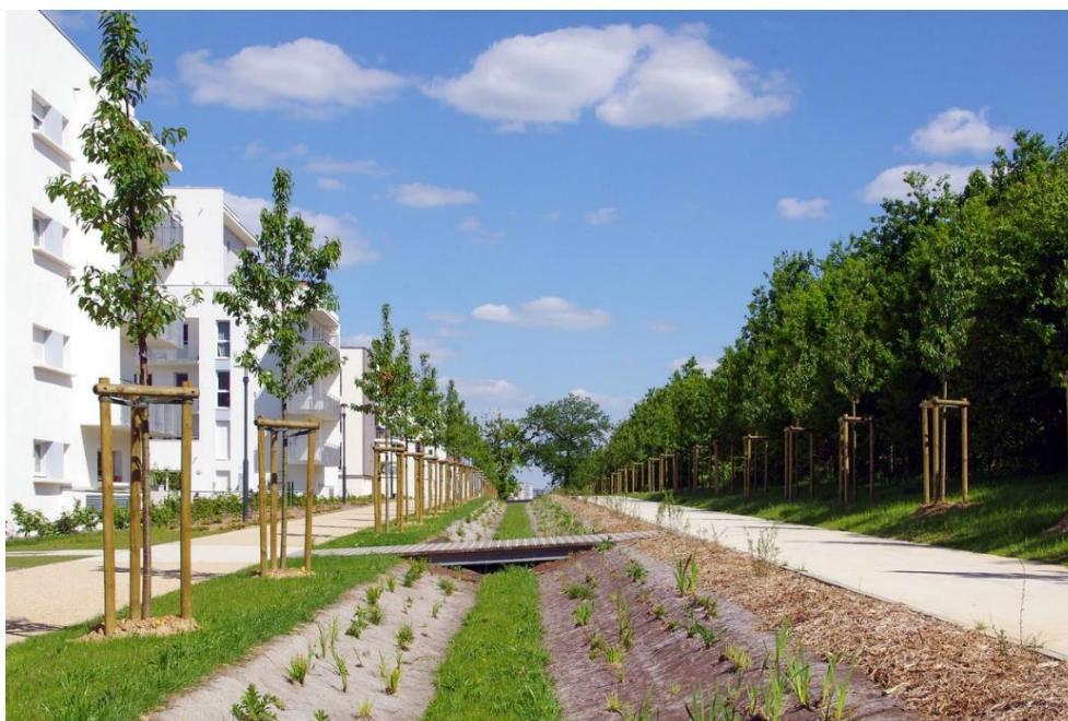
Fot.13. Prawidłowo wykonane palikowanie drzew. / źródło: internet
