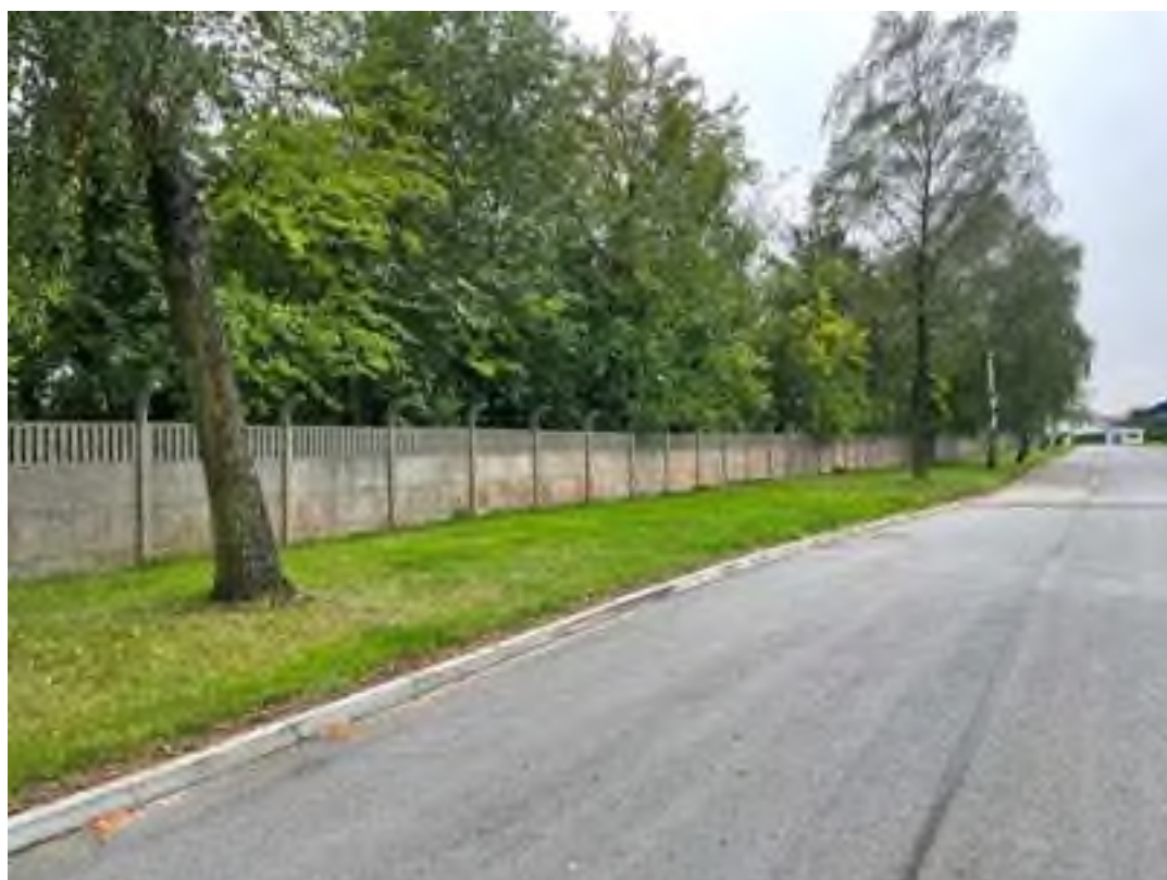
Fot. 15 – Istniejące ogrodzenie zewnętrzne z płyt betonowych, prefabrykowanych- do rozbiórki
