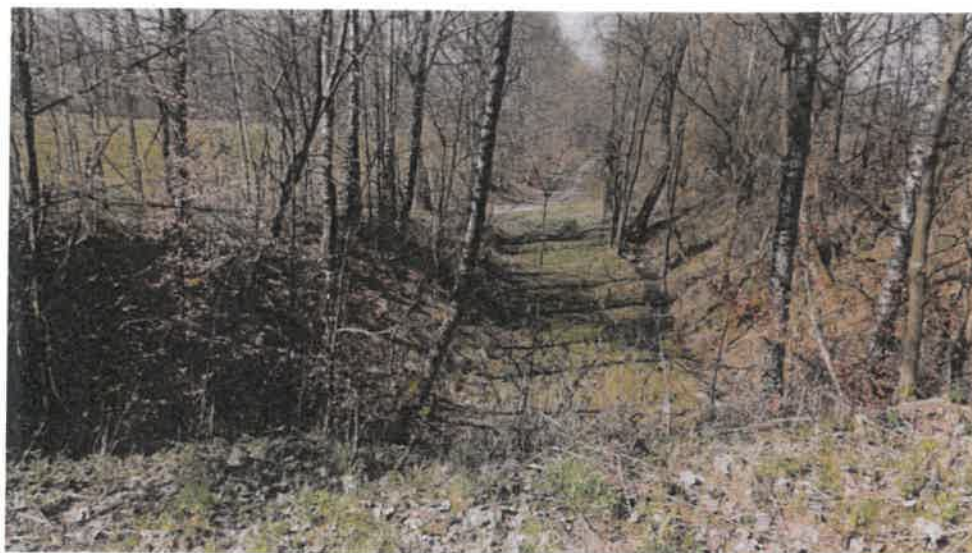
Dolsko - widok dalszego odcinka torowiska w kierunku wschodnim z dawnego wiaduktu.
