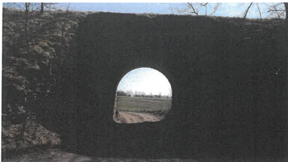
Piaszczyzna - wiadukt linii kolejowej
