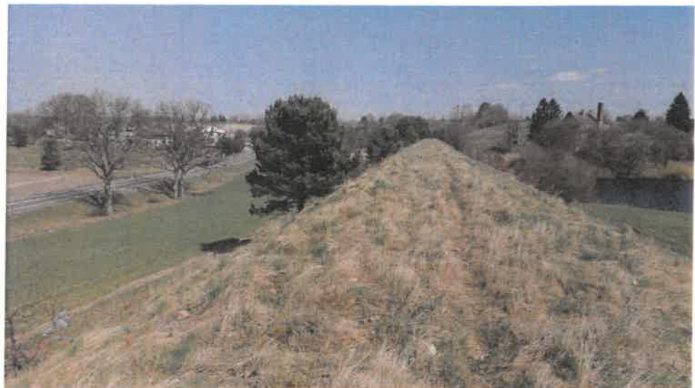
Głódowo - wysoki nasyp dawnej linii kolejowej po południowej stronie DK 20, dalej rozebrany wiadukt
