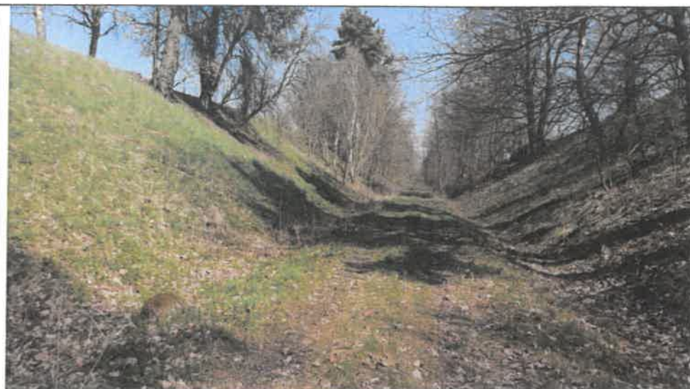
Wykop dawnej linii kolejowej pomiędzy Piaszczyną a Głodowem
