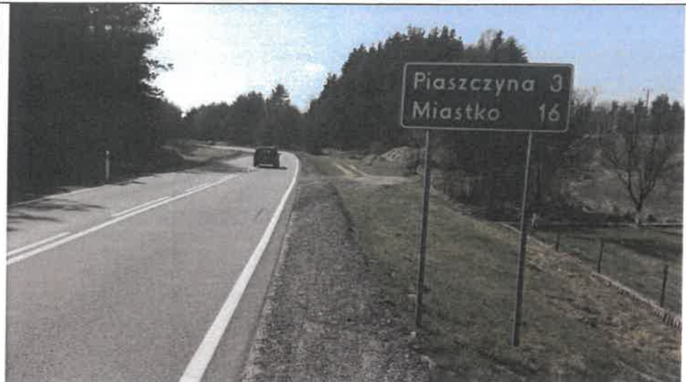
Głódowo - początek proponowanego ciągu pieszo-rowerowego wzdłuż DK20 (widok w kierunku zachodnim) - widoczny zakręt, przez który prowadzić powinna trasa poprowadzona dalej na nasypie
