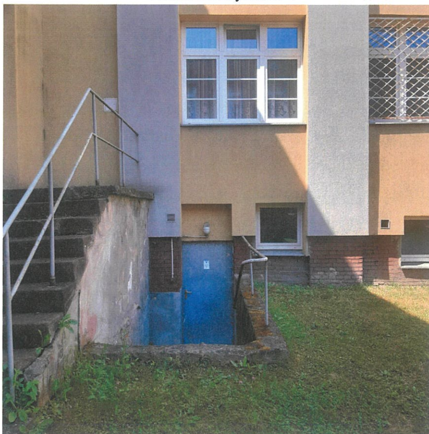
Fot. nr 2 budynek nr 1
