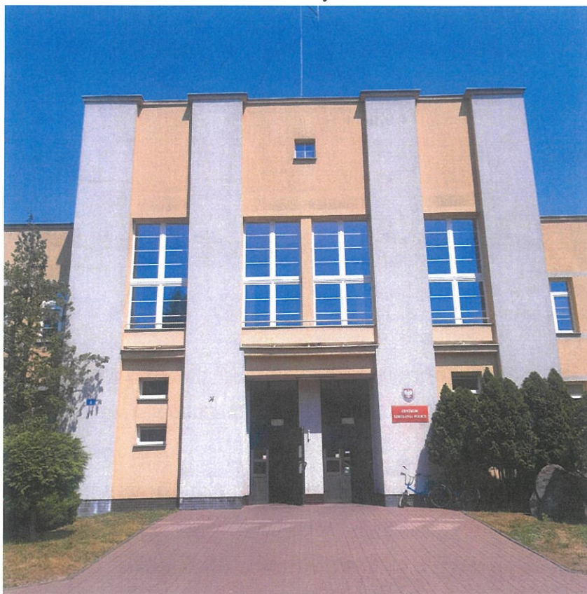
Fot. nr 1 budynek nr 1
