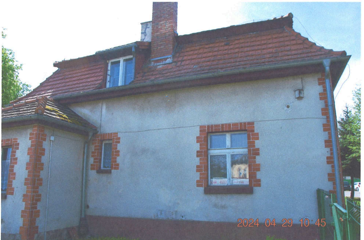
fot.2 Widok połaci północnej
