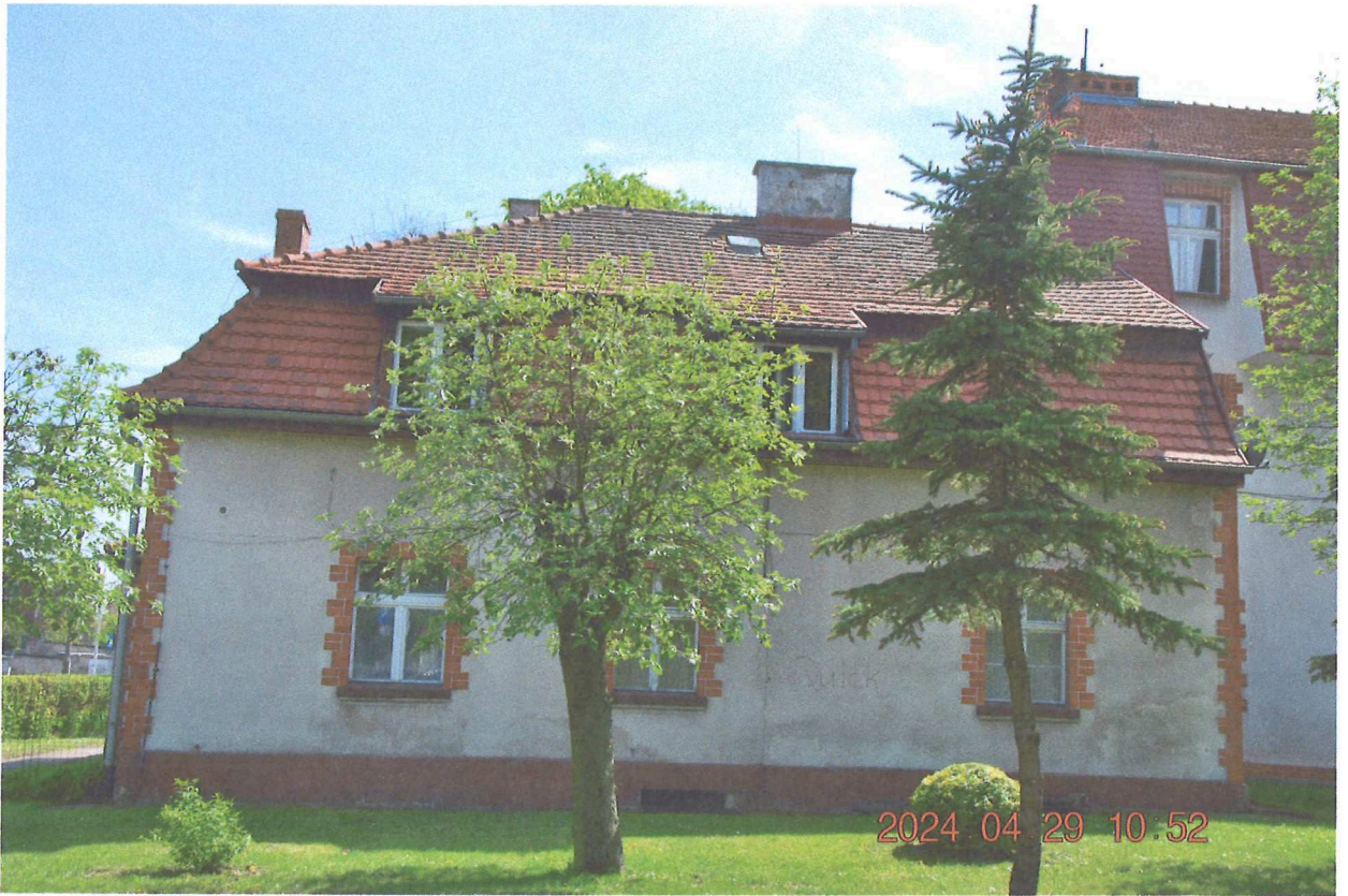
fot.3 Widok połaci zachodniej
