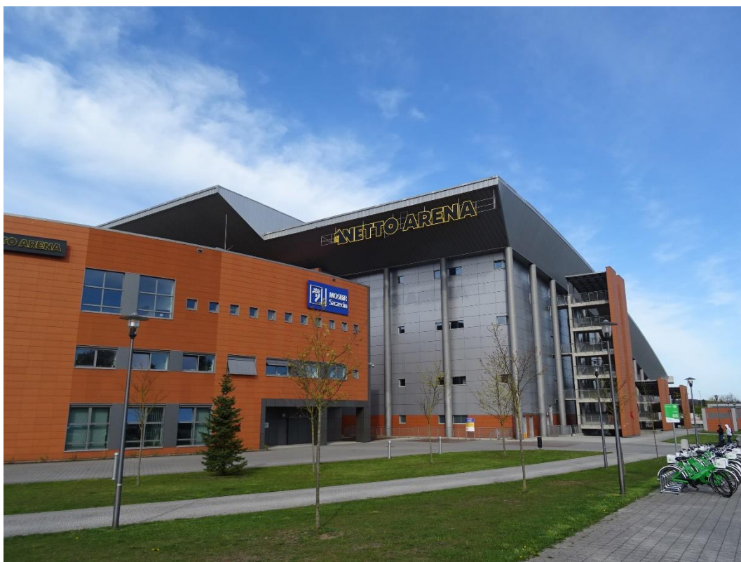
Fot. 1. Hala Netto Arena – widok od południa
