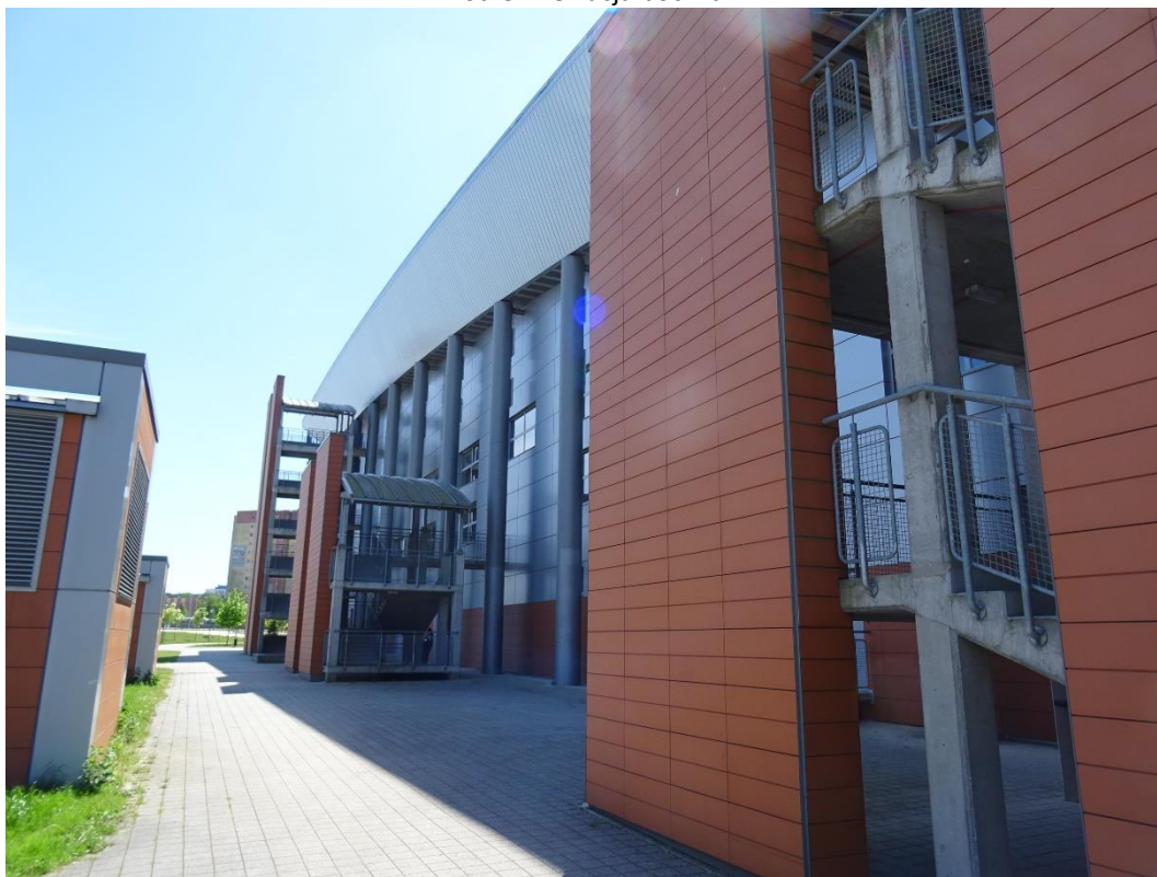
Fot. 4. Elewacja boczna
