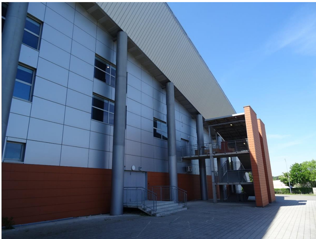
Fot. 3. Elewacja boczna
