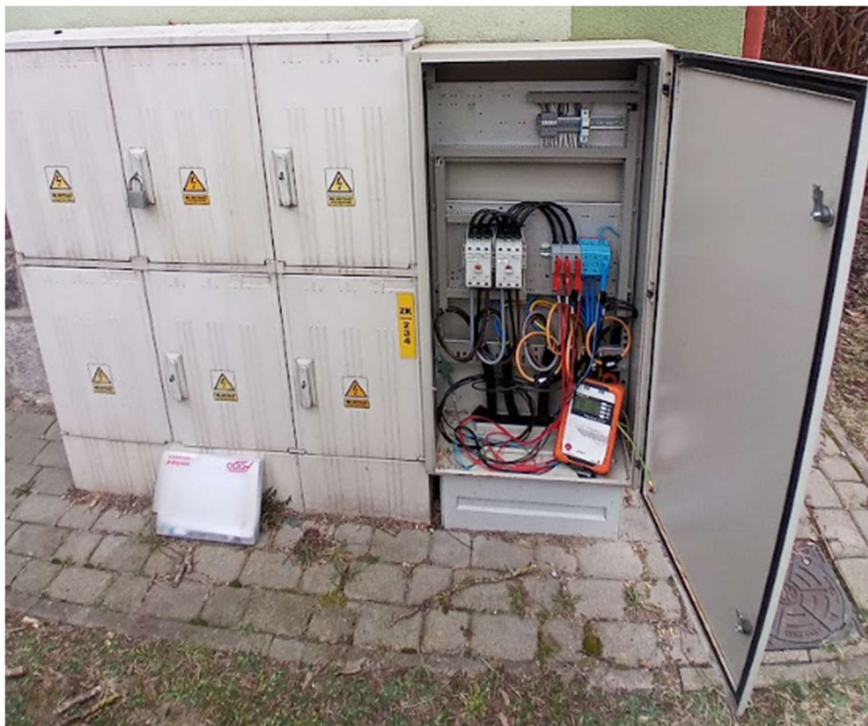
Rys. 1. Widok punktu pomiarowego.
