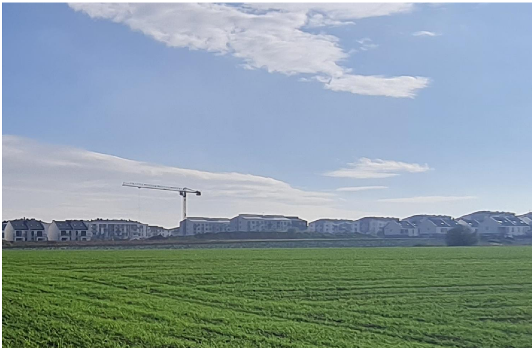
ZDJĘCIE 1. Widok obszaru. W oddali widoczna budowa przedszkola gminnego.
