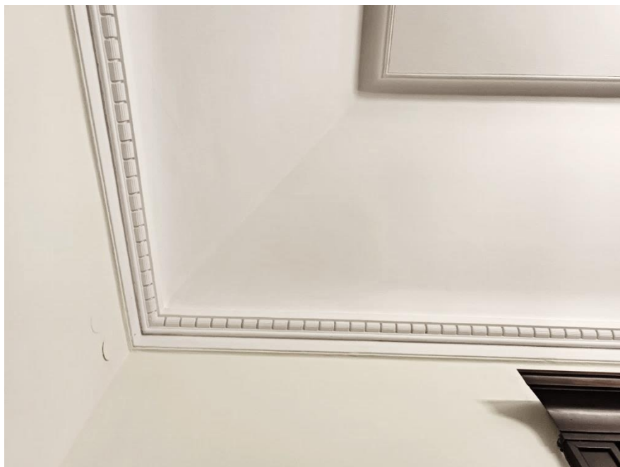
Fot nr. 142. Zbliżenie profilu gzymsowego
