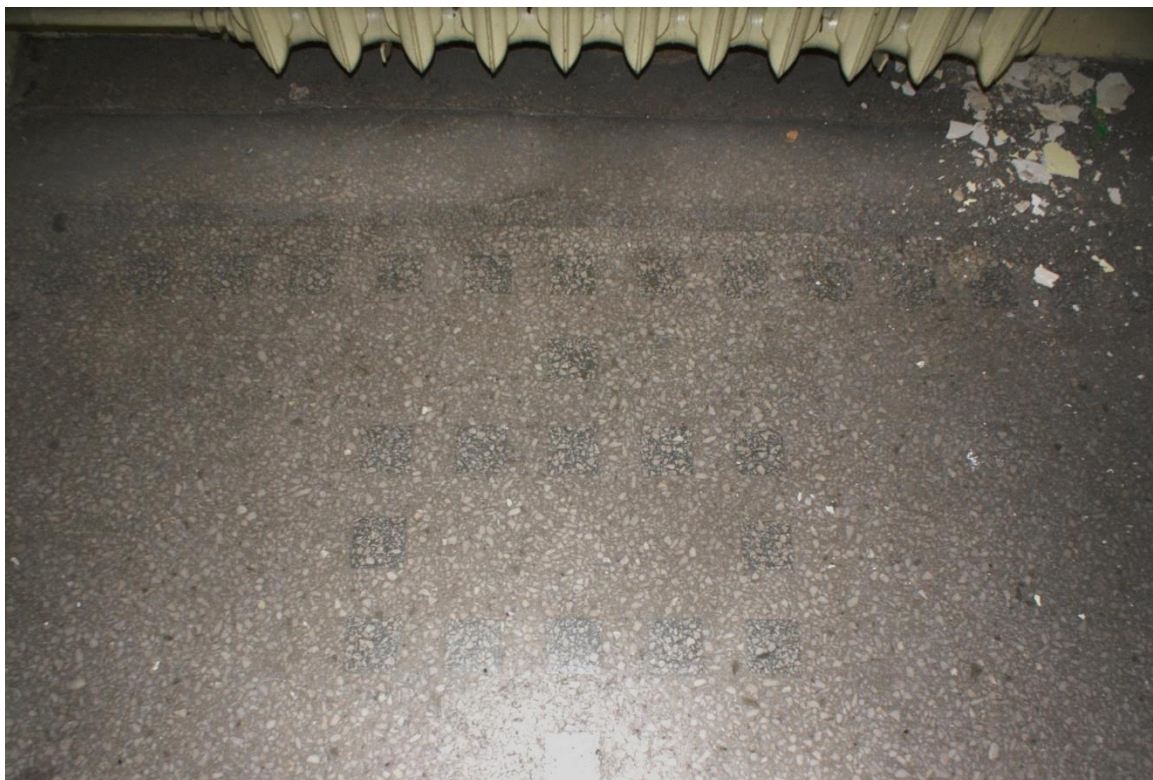
Fot nr 18. Posadzka z lastriko z motywem bordiury z kwadracików i motywu prostokąta także z kwadracików
