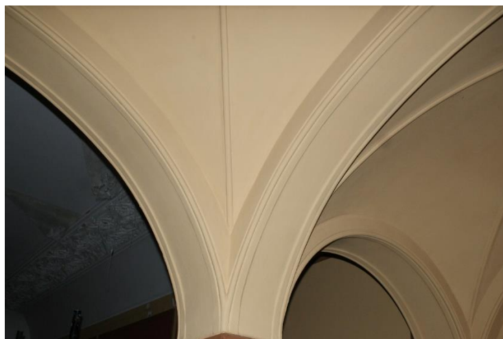
Fot nr 57. Krzyżowe sklepienie części północnej
