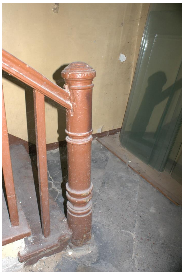
Fot nr 9 i 10. Dolna część klatki północnej, widoczna pierwotna posadzka i słupek balustrady
