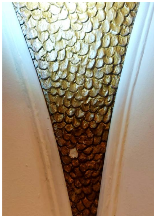
Fot nr 139 i 140. Zbliżenia struktury tynku dekoracyjnego
