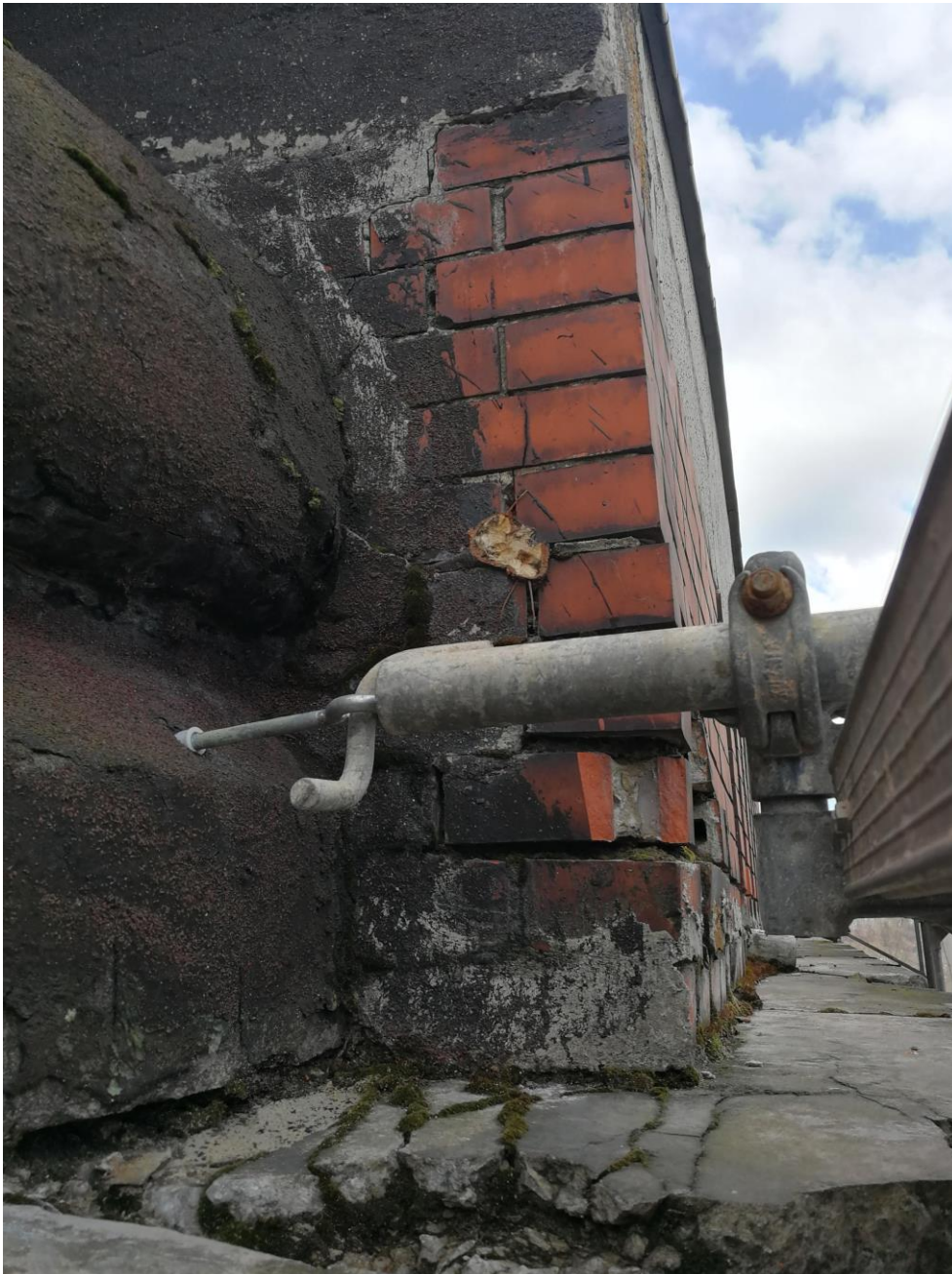
Fot. 29 Pozostałości samosiejki brzozy wrosnięte w spoiny muru ceglanego.
