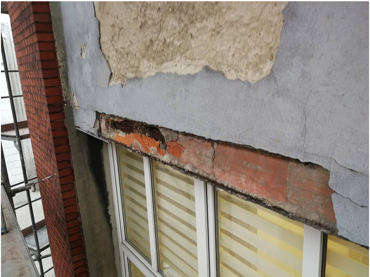
Zdjęcie 15. Widok skorodowanego nadproża okiennego.
