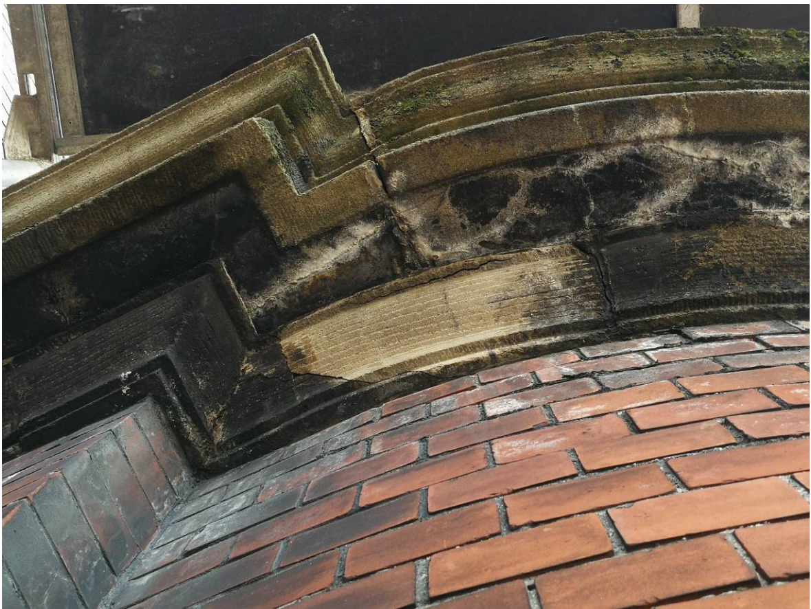
Zdjęcie 9. Widok gzymsu od dołu. Uwidoczniony rysunek ryflowania pierwotnego (do odtworzenia w nowych i naprawianych elementach)
