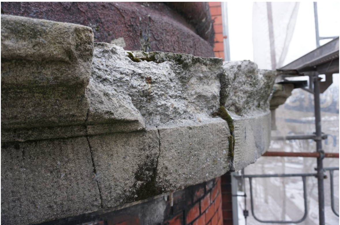
Zdjęcie 4. Widok uszkodzonego gzymsu wieńczącego. Widoczne ryflowania w wykończeniu gzymsów. W górnej części zdjęcia widoczna kopułka narożna.
