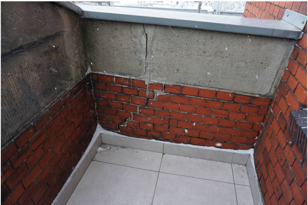
Zdjęcie 12. Widok attyki ryzalitów od strony wewnętrznej. Widoczne spękania ściany ceglanej oraz bloków betonowych.
