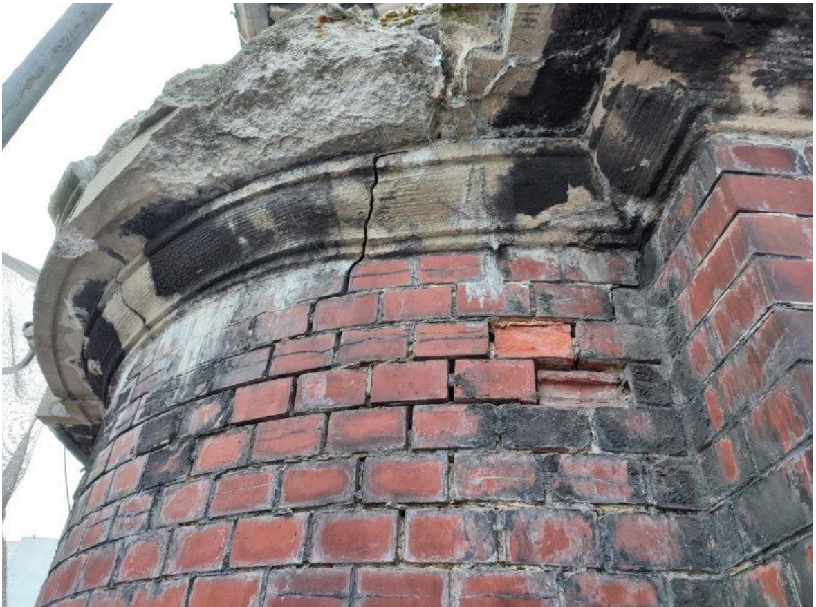
Zdjęcie 8. Widok narożnika łukowego. Wyraźne spękanie gzymsu oraz elewacji ceglanej. Widoczne ubytki w wątku ceglanym (do uzupełnienia).
