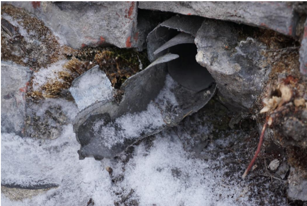
Fot. 25 Odwodnienie tarasu od strony zewnętrznej.
