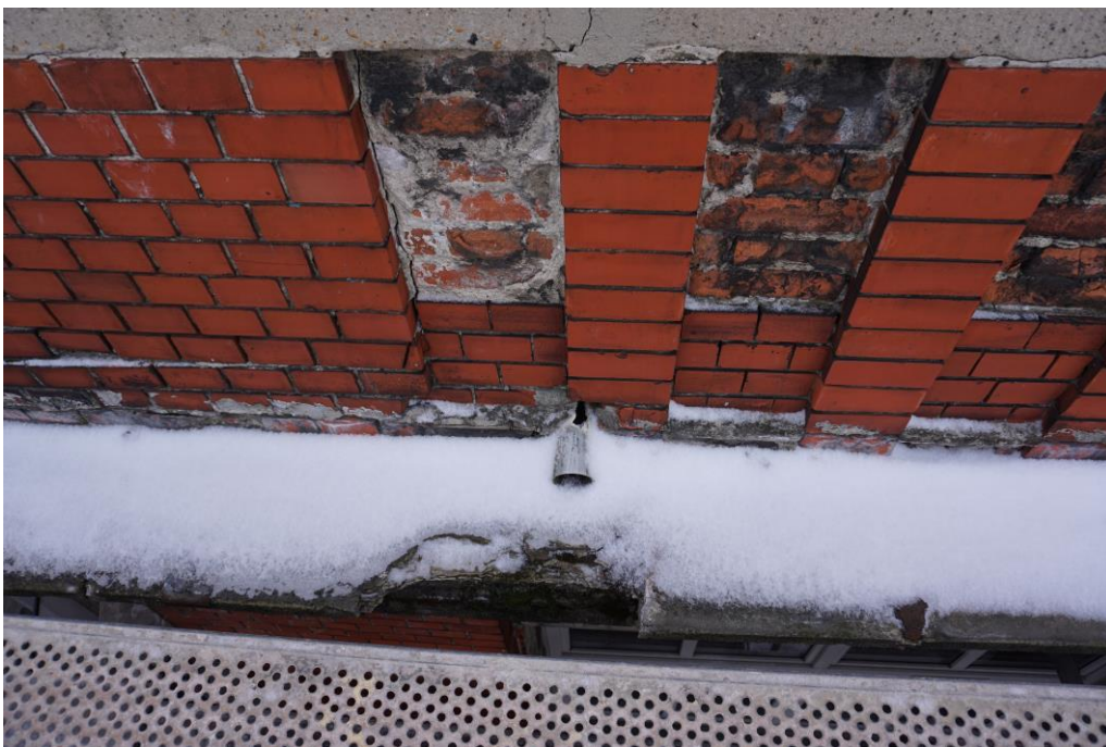
Fot. 26 Odwodnienie tarasu od strony zewnętrznej.
