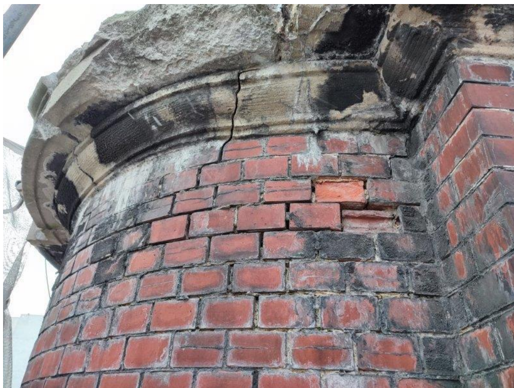
Fot. 18 Degradacja cegieł i zaprawy, zarysowanie ściany poniżej gzymsu.
