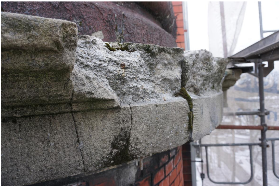
Fot. 9 Uszkodzenie gzymsów przylegających do kopuł ozdobnych.
