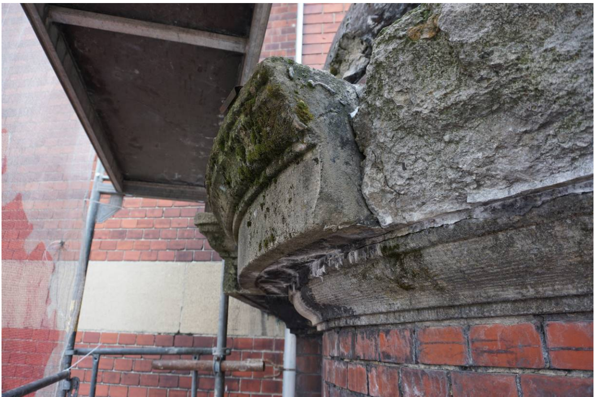
Zdjęcie 6. Widok uszkodzonego gzymsu wieńczącego na fragmencie narożnym (łukowym). Widoczne podziały pierwotnych gzymsów oraz ryflowane wykończenia (do odtworzenia w nowych elementach).
