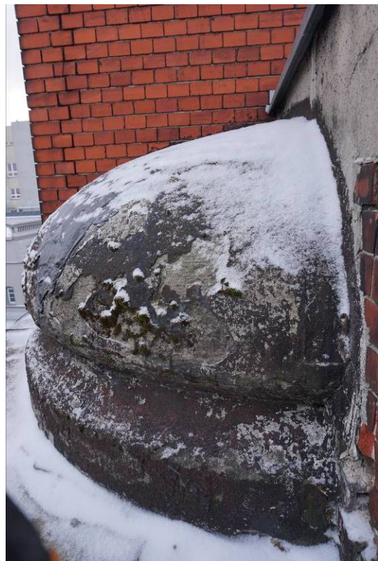
Zdjęcie 19. Kopułka wieńcząca narożna ryzalit. Widoczne złuszczone powłoki zabezpieczające przed wilgocią.
