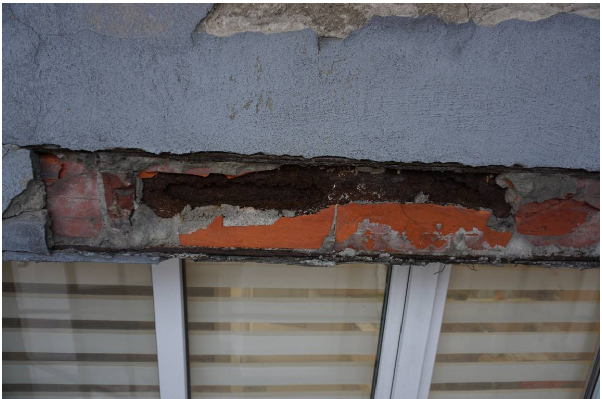
Zdjęcie 16. Widok skorodowanego nadproża okiennego - zbliżenie.
