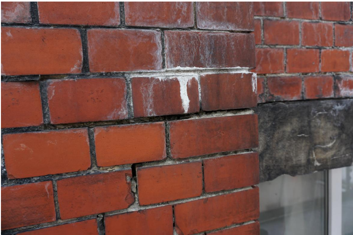
Fot. 21 Zarysowania ściany w rejonie oparcia nadproży okiennych.
