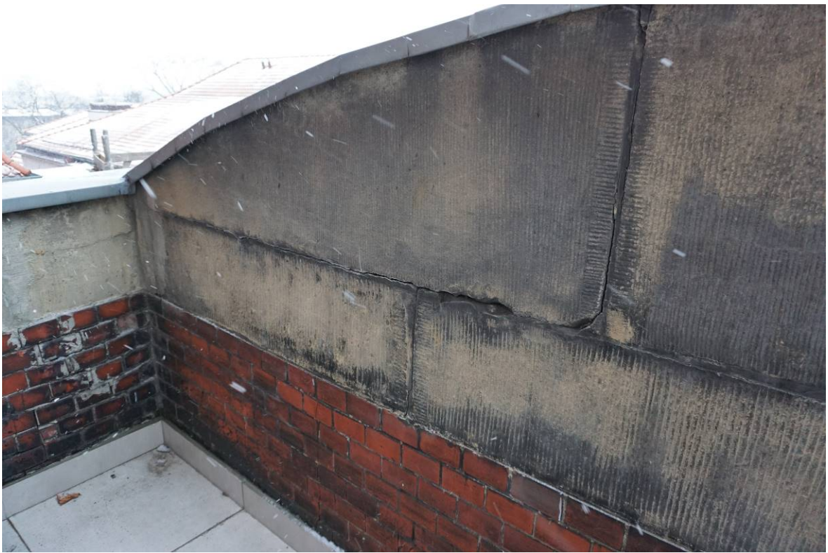
Zdjęcie 13. Widok attyki ryzalitów od strony wewnętrznej. Widoczne odspojenia bloków betonowych.
