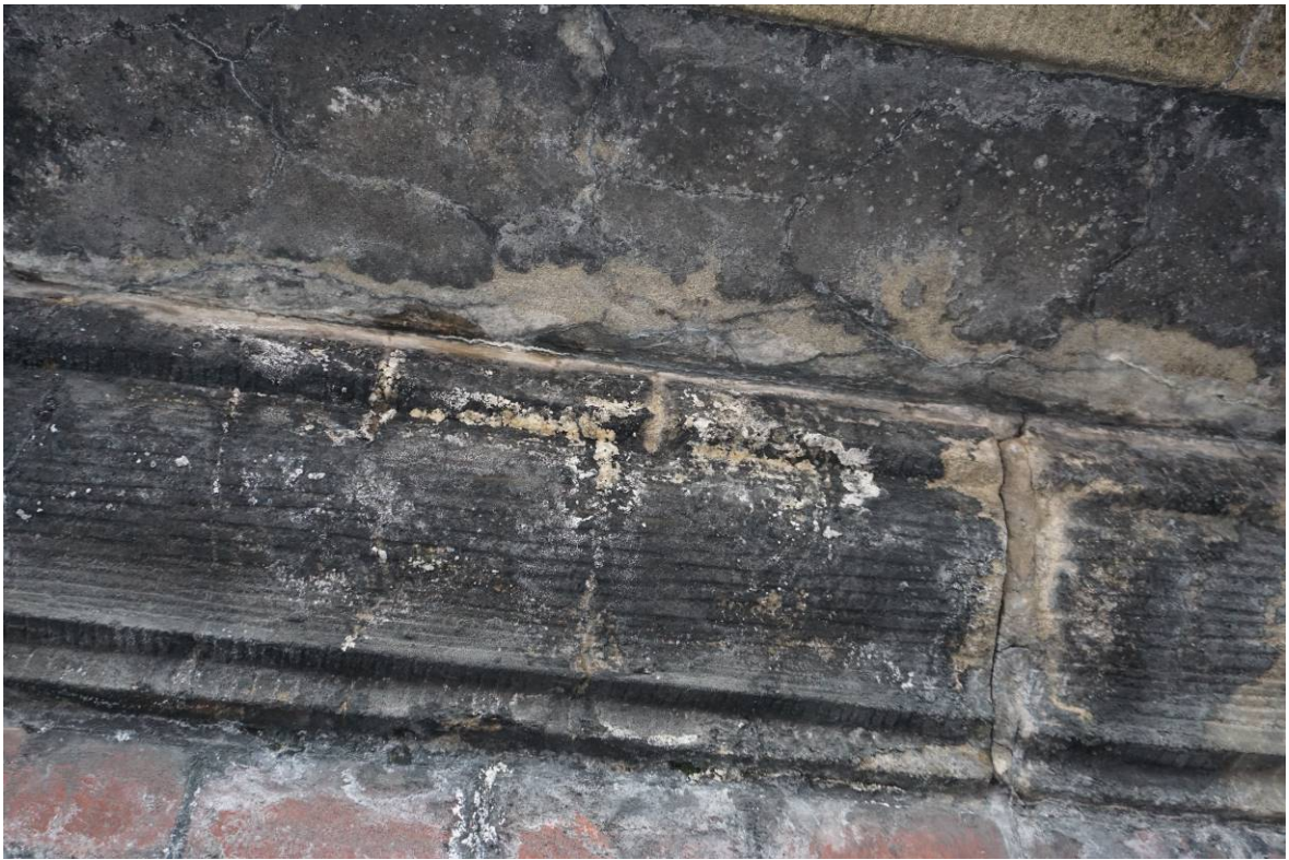
Zdjęcie 5. Widok uszkodzonego gzymsu wieńczącego. Widoczne ryflowania w wykończeniu gzymsów oraz spękania.
