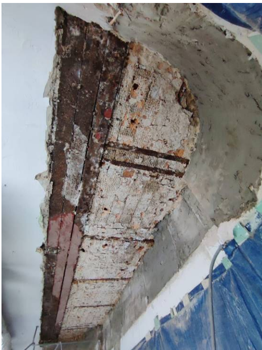
Zdjęcie 18. Strop wieńczący ryzality. Odkrywka tynku wewnętrznego ukazująca konstrukcję stalowo-ceglaną narożnika.
