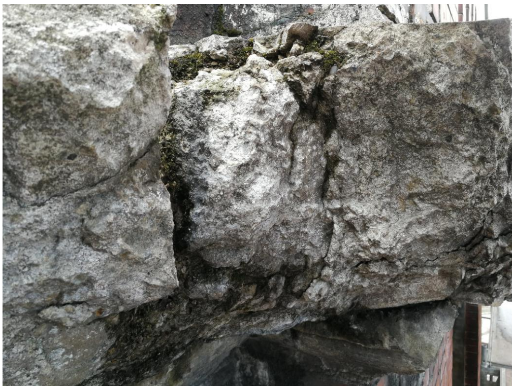
Fot. 10 Rozwarstwienie betonu w przekroju poprzecznym gzymsów.
