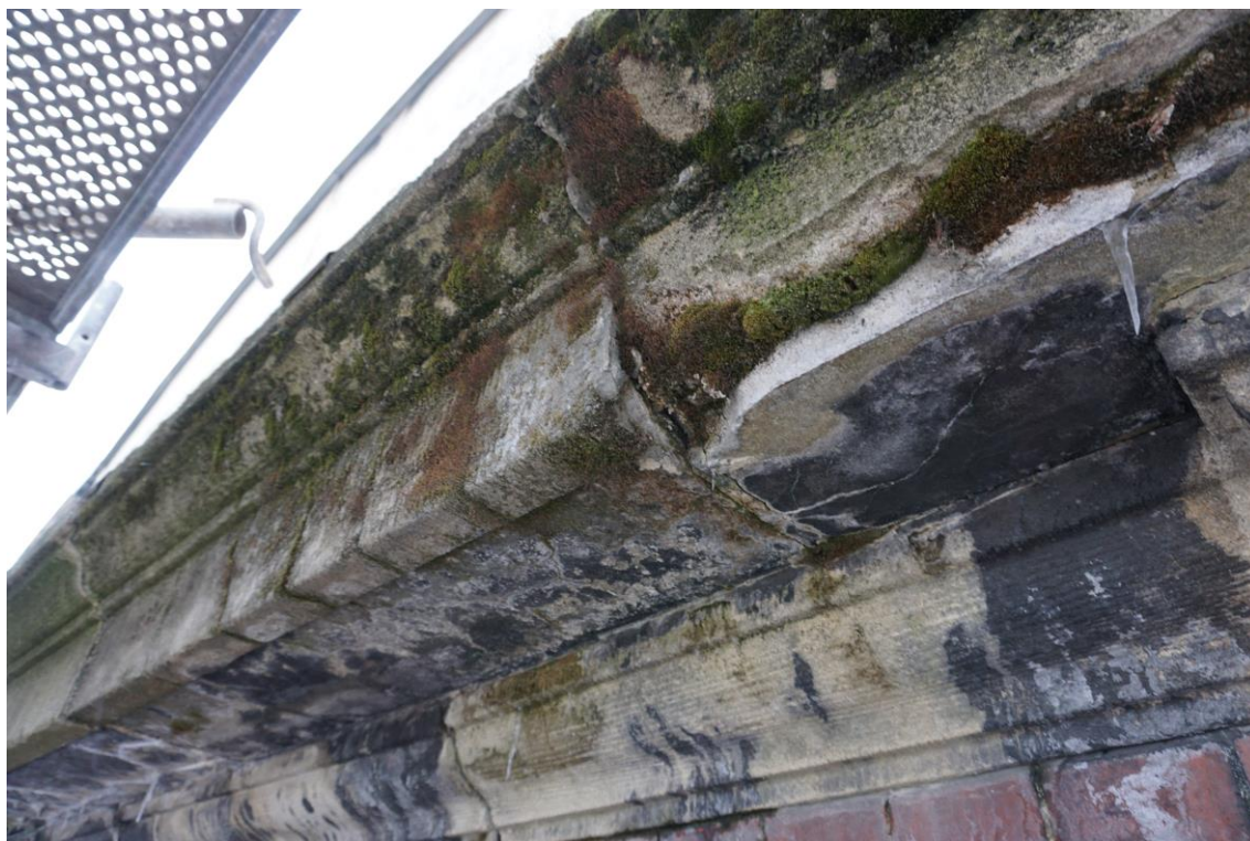
Fot. 3 Gzyms betonowy górny i dolny.
