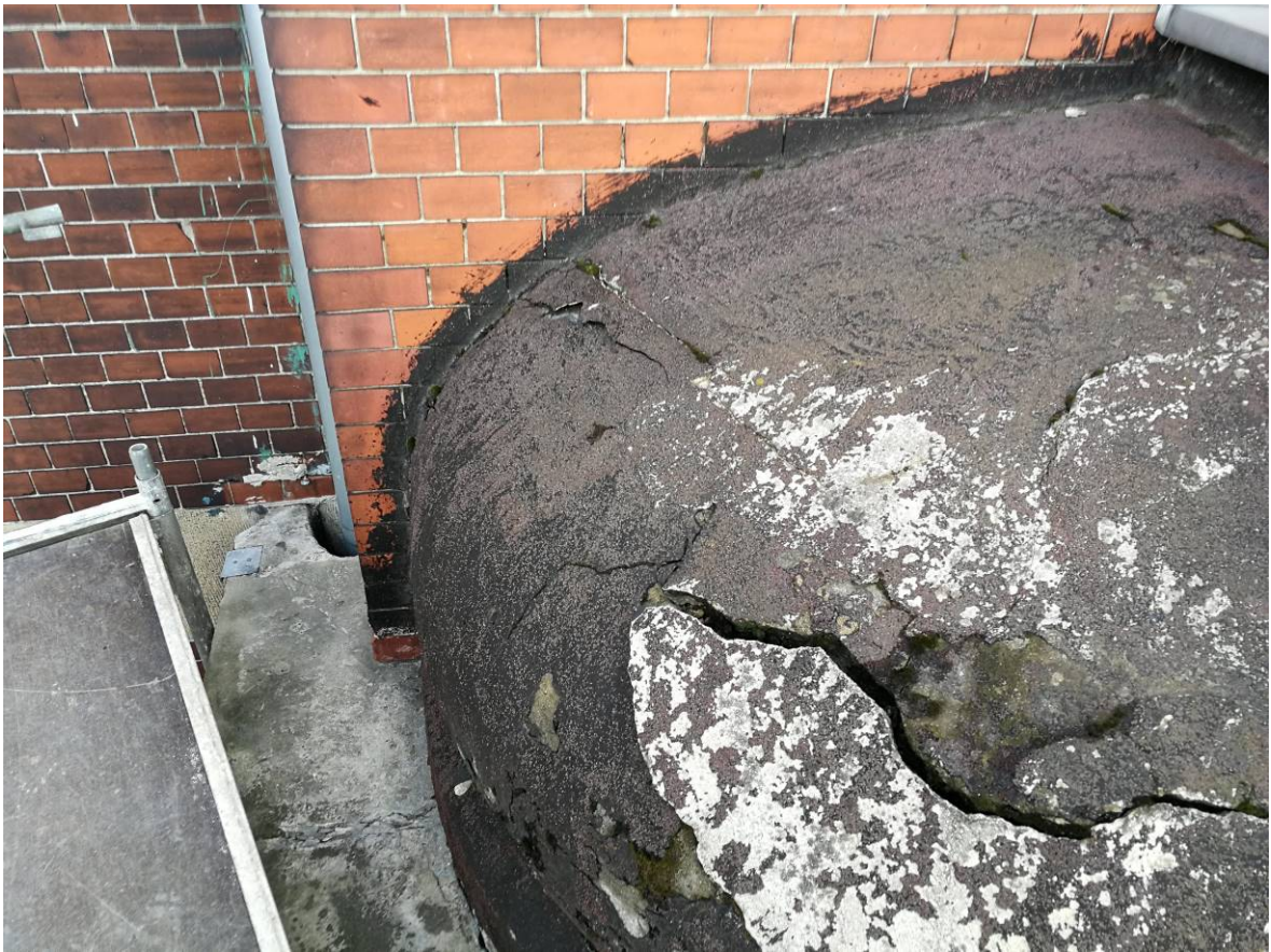
Zdjęcie 17. Kopułka wieńcząca narożna w ryzalicie północno-wschodnim. Widoczne spękanie erozyjne betonu..
