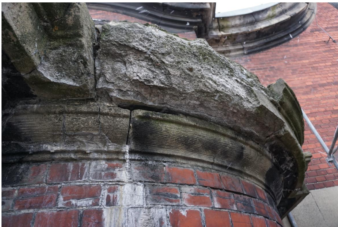
Fot. 19 Wykwity soli, zarysowanie wzdluzne zawilgoconych cegieł poniżej gzymsu.
