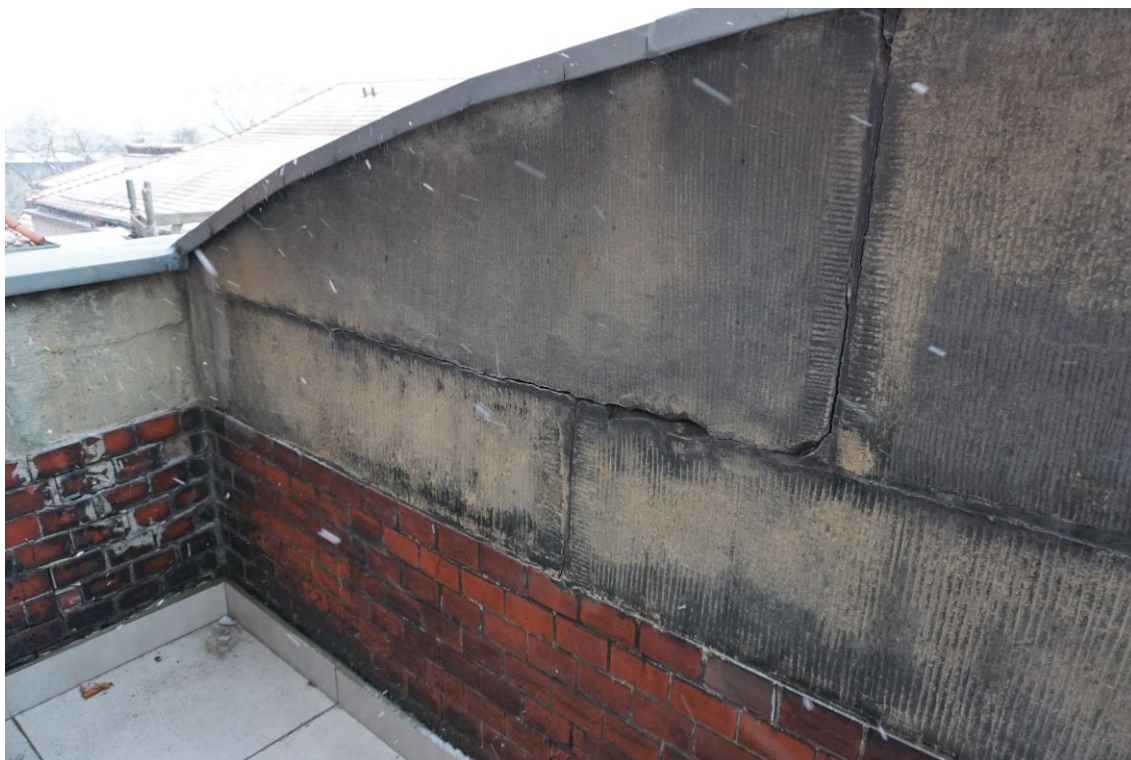
Fot. 16 Rozwarstwienie bloków betonowych
