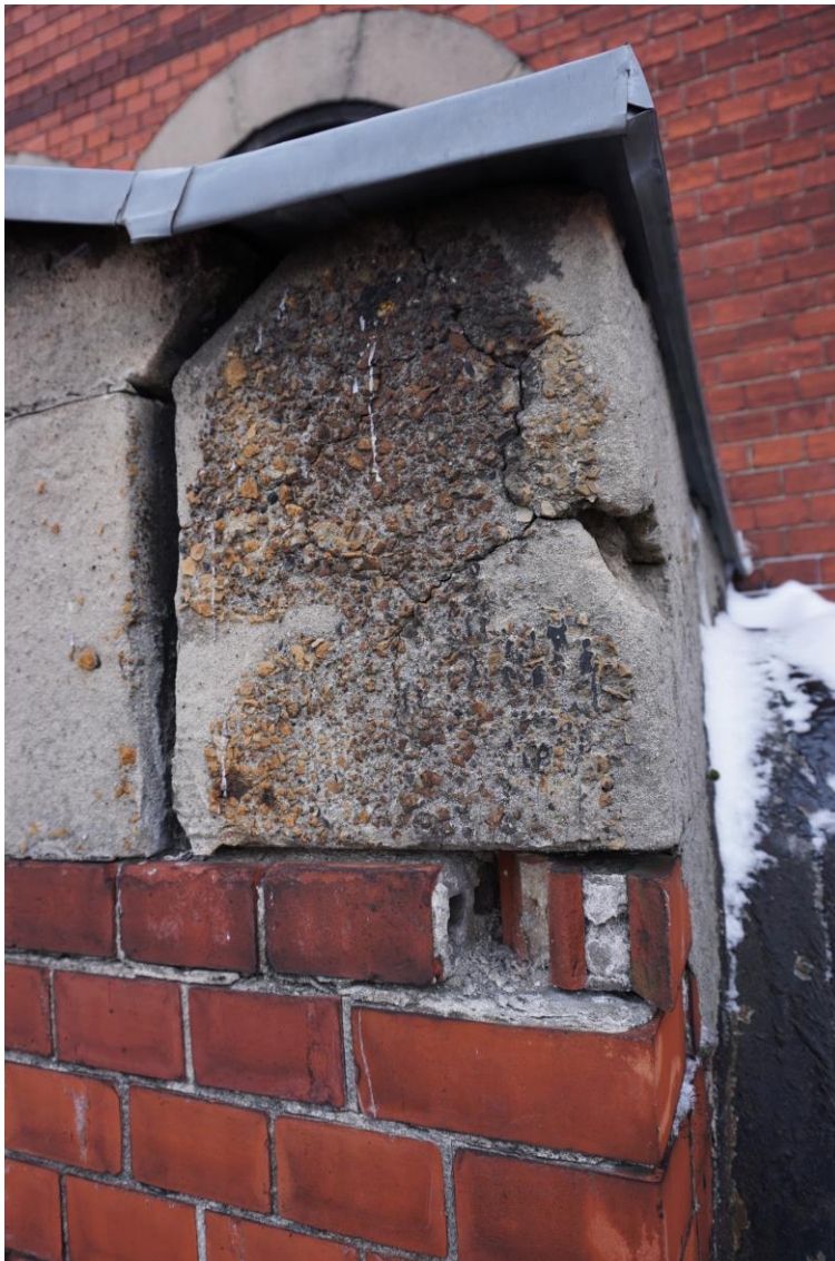
Fot. 17 Uszkodzenie cegieł, spękanie bloków betonowych.
