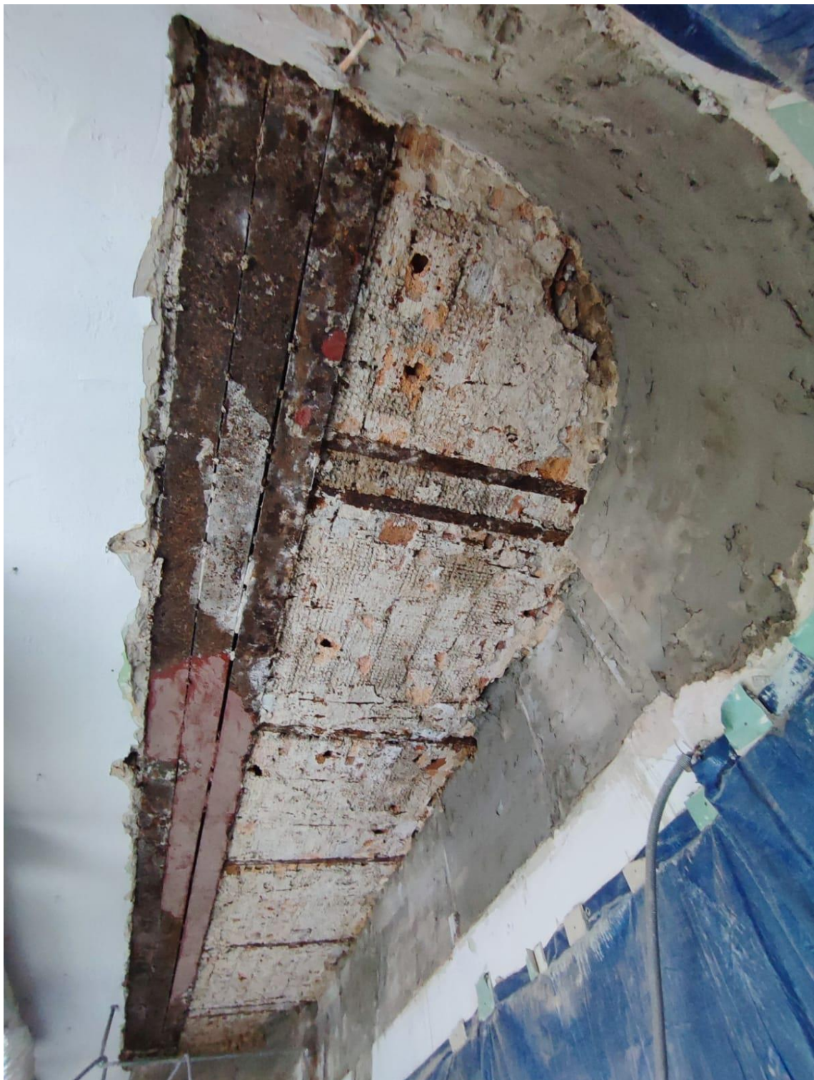
Fot. 14 Skute tynki oraz odsłonięte belki stalowe przygotowane do renowacji.
