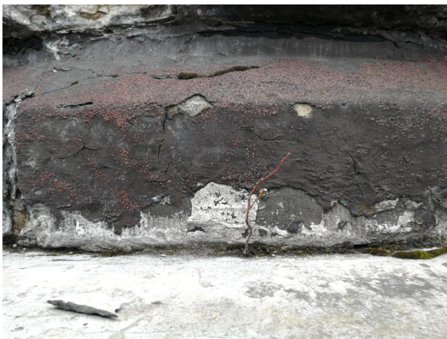
Fot. 27 Jednoroczny pęd brzozy wrastający w spoinę.
