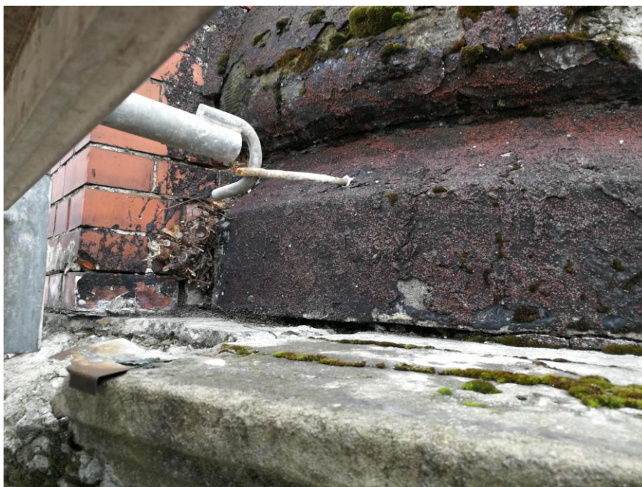
Fot. 22 Pozostałości obróbki blacharskiej na górnej powierzchni gzymsu
