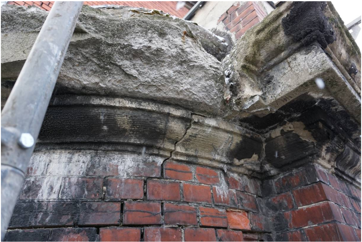
Zdjęcie 7. Widok narożnika łukowego. Wyraźne spękanie gzymsu oraz elewacji ceglanej.
