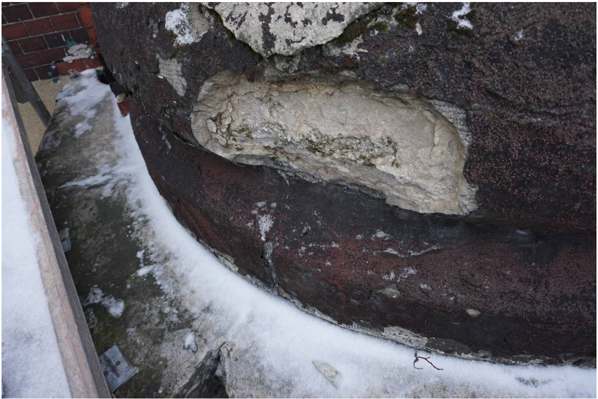
Zdjęcie 20. Uszkodzony fragment kopułki betonowej.
