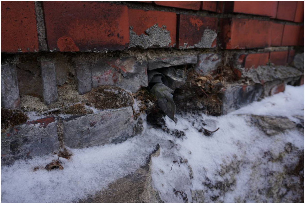
Zdjęcie 11. Uszkodzony i skorodowany przelew w attyce ryzalitów.
