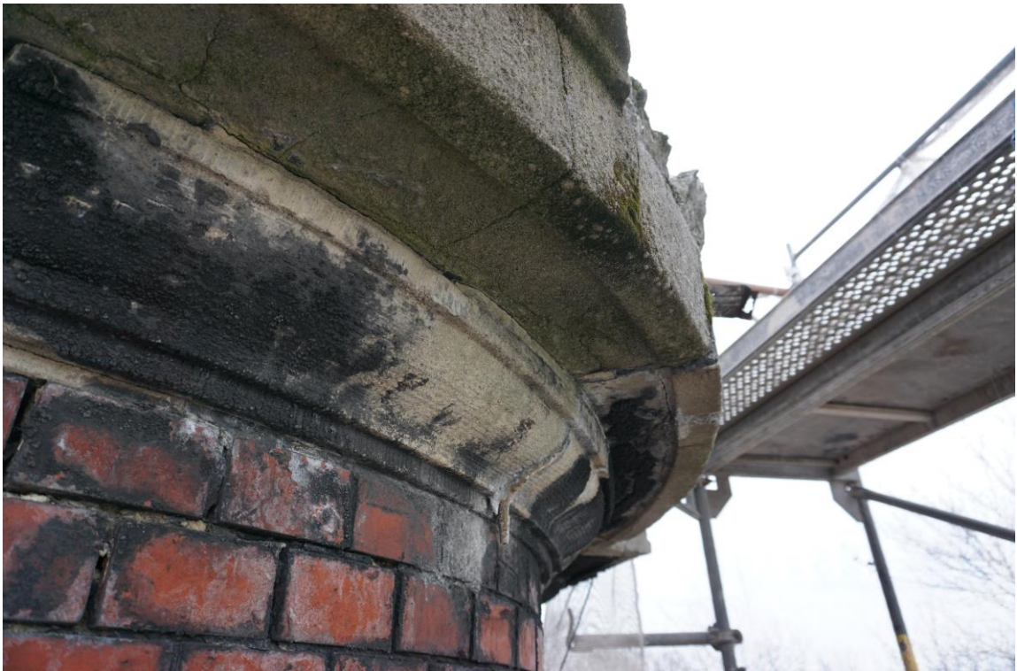
Fot. 11 Zarysowanie podłużne na dolnej powierzchni gzymsów.
