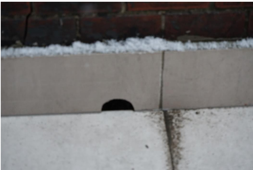
Fot. 24 Odwodnienie tarasu północno wschodniego od strony tarasu.
