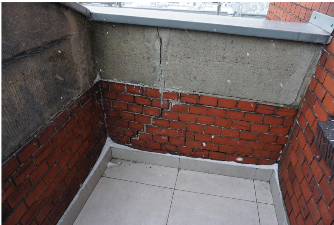
Fot. 15 Zarysowanie ściany murowanej, rozwarstwienie bloków betonowych
