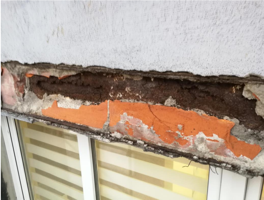
Fot. 20 Korozja nadproża okiennego nad piętrem od strony północno-wschodniej
