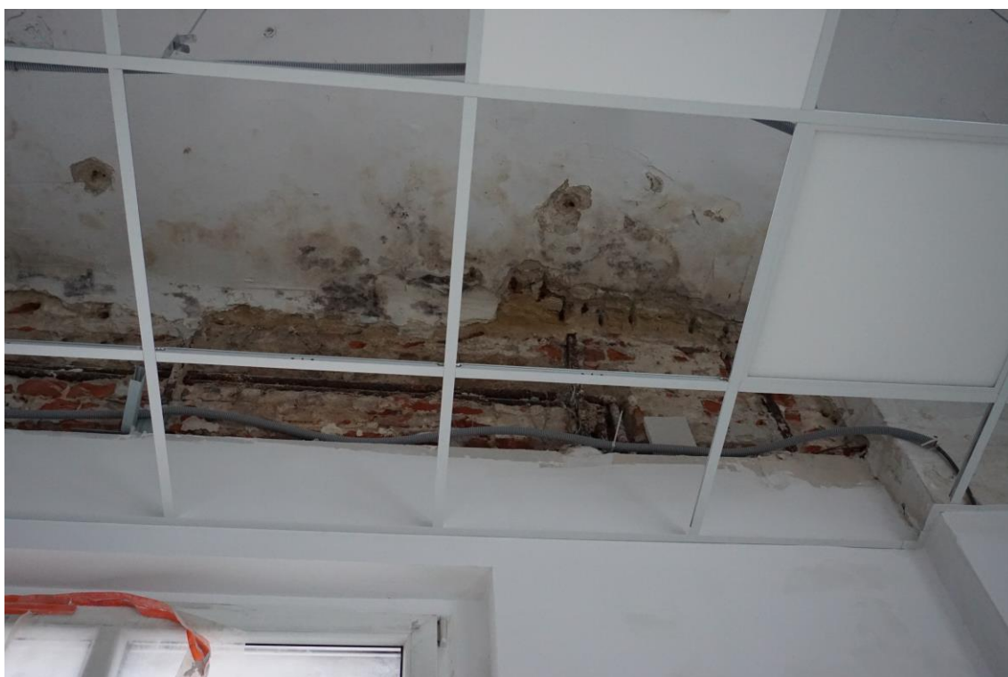
Fot. 13 Zawilgocenia stropu nad piętrem od strony północno wschodniej.
