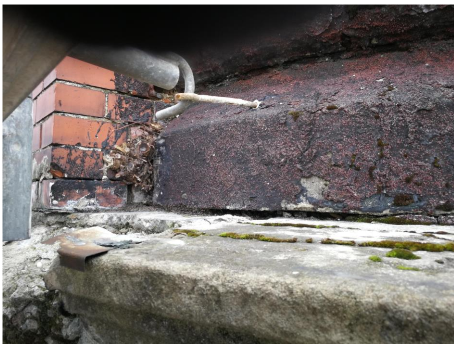
Fot. 27 Jednoroczny pęd brzozy wrastający w spoinę.
