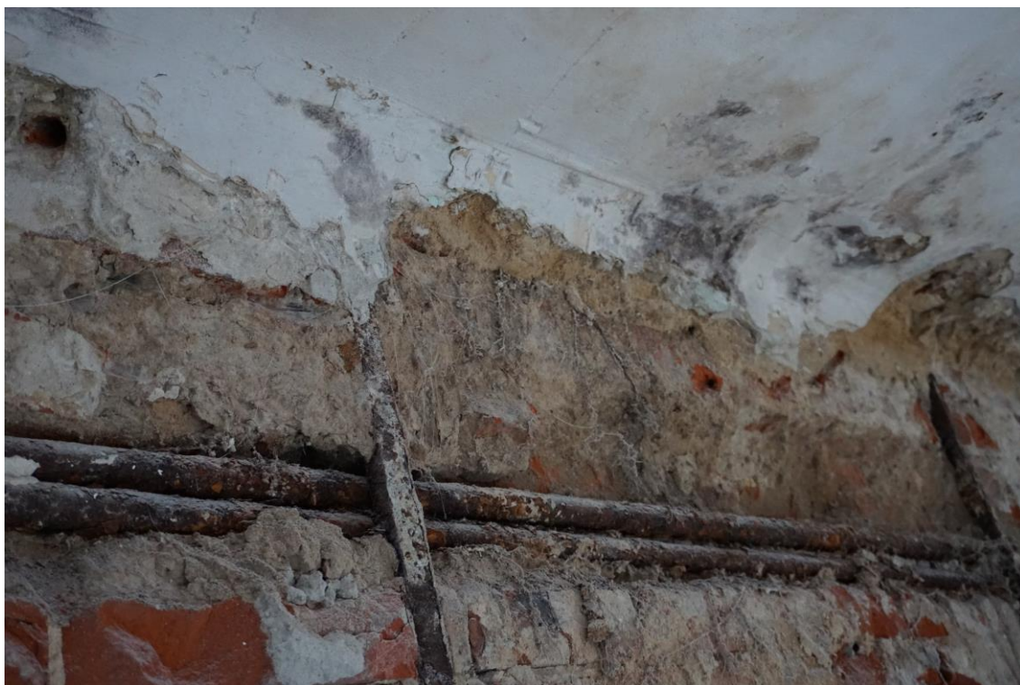
Rys. 5 Kotwy stalowe stabilizujące gzymsy.
