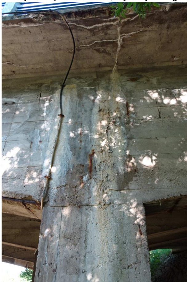
Korozja zbrojenia, zacieki, wykwity dźwigara skrajnego od strony zewnętrznej
