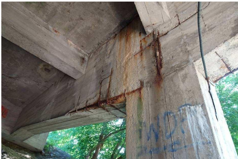
Korozja zbrojenia, zacieki, wykwity dźwigara skrajnego od strony wewnętrznej
