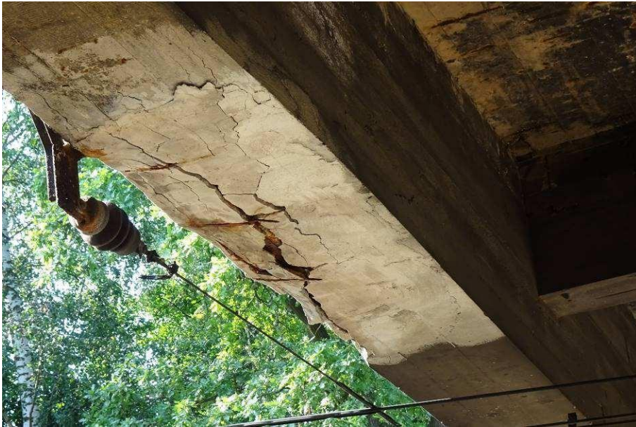
Spękania, ubytki otuliny, korozja zbrojenia dźwigara skrajnego
