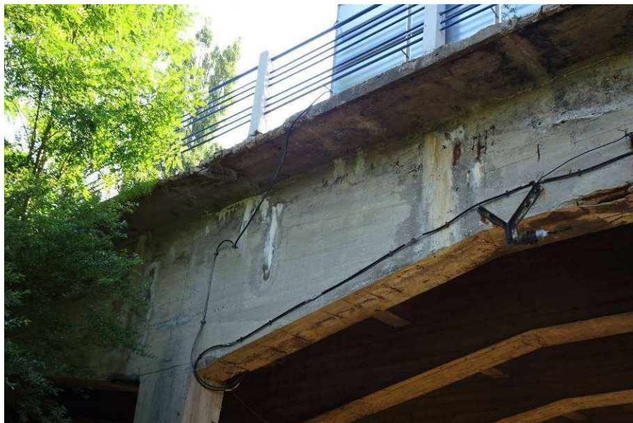
Korozja zbrojenia, zacieki, wykwyty dźwigara skrajnego
