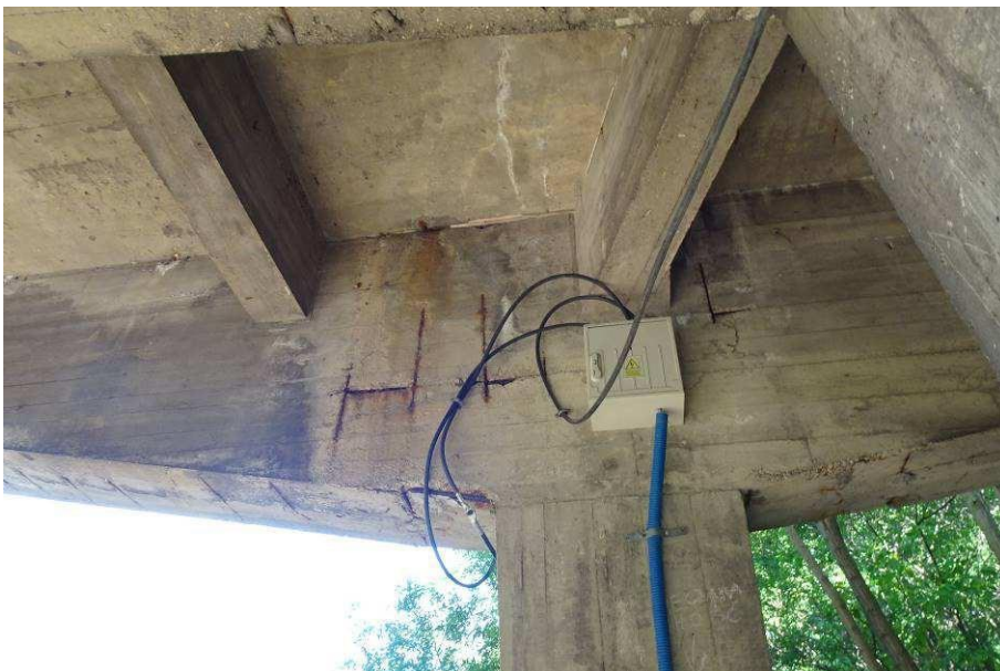
Korozja zbrojenia, zacieki, wykwyty dźwigara skrajnego
