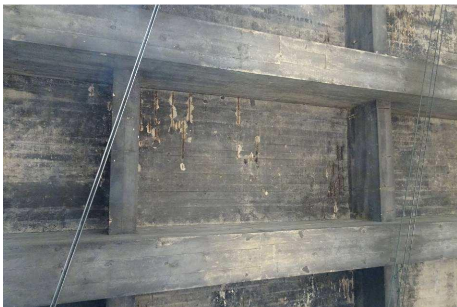
Korozja zbrojenia płyty pomostu
