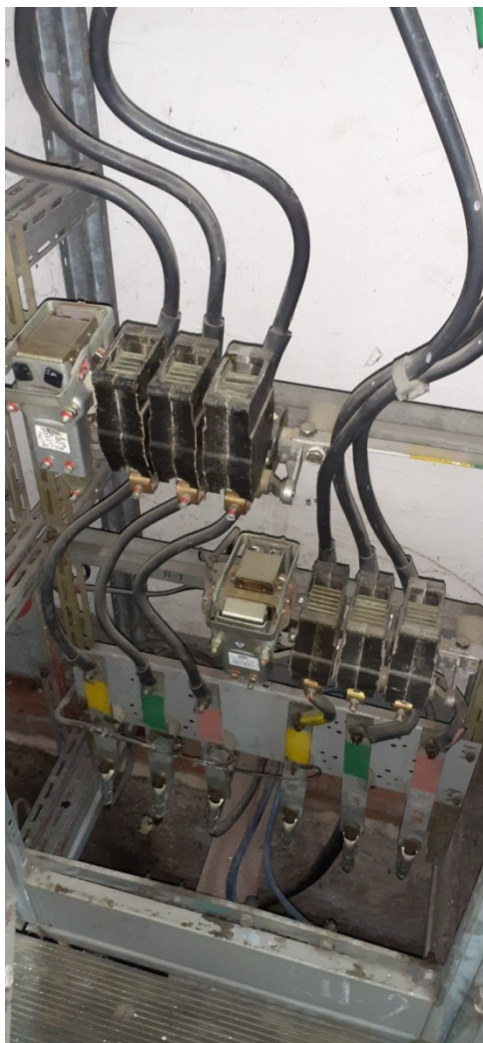
Wymiana – modernizacja pól odpywowych w rozdzielni NN.
