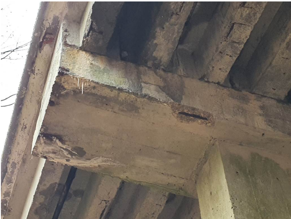
Fot. 8 Skrajna strefa oczepu podpory pośredniej. Widoczne przecieki i ubytki betonu.
