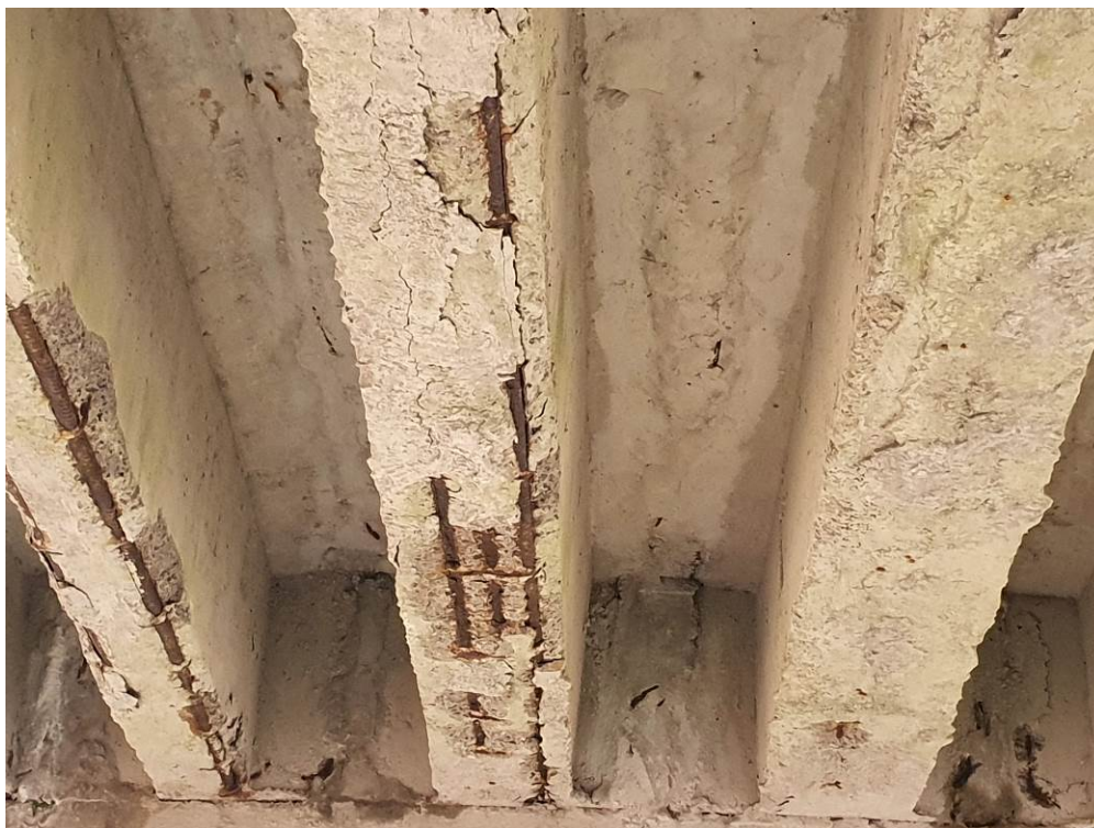
Fot. 9. Odspojona otulina zbrojenia dolnego oraz spękana otulina na pozostałej powierzchni belki.
