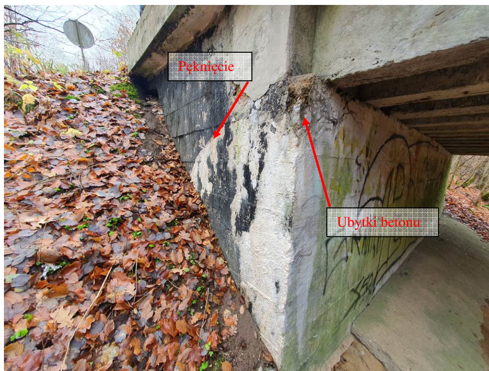
Fot. 5 Przyczółek od strony Mojuszewskiej Huty. Widoczna korozja betonu, pęknięcia i przecieki w miejscu pęknięć. Nieprawidłowo ukształtowana skarpa w obrębie skrzydła.
