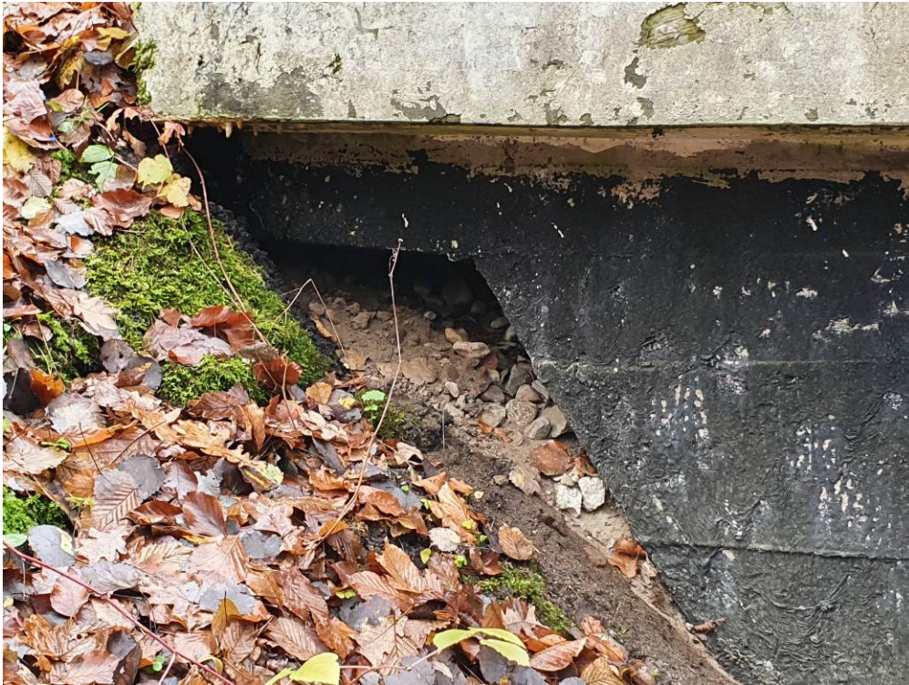
Fot. 6 Przyczółek od strony Mojuszewskiej Huty. Nieprawidłowo ukształtowana skarpa wykopu. Wymywany grunt spod nawierzchni jezdni.
