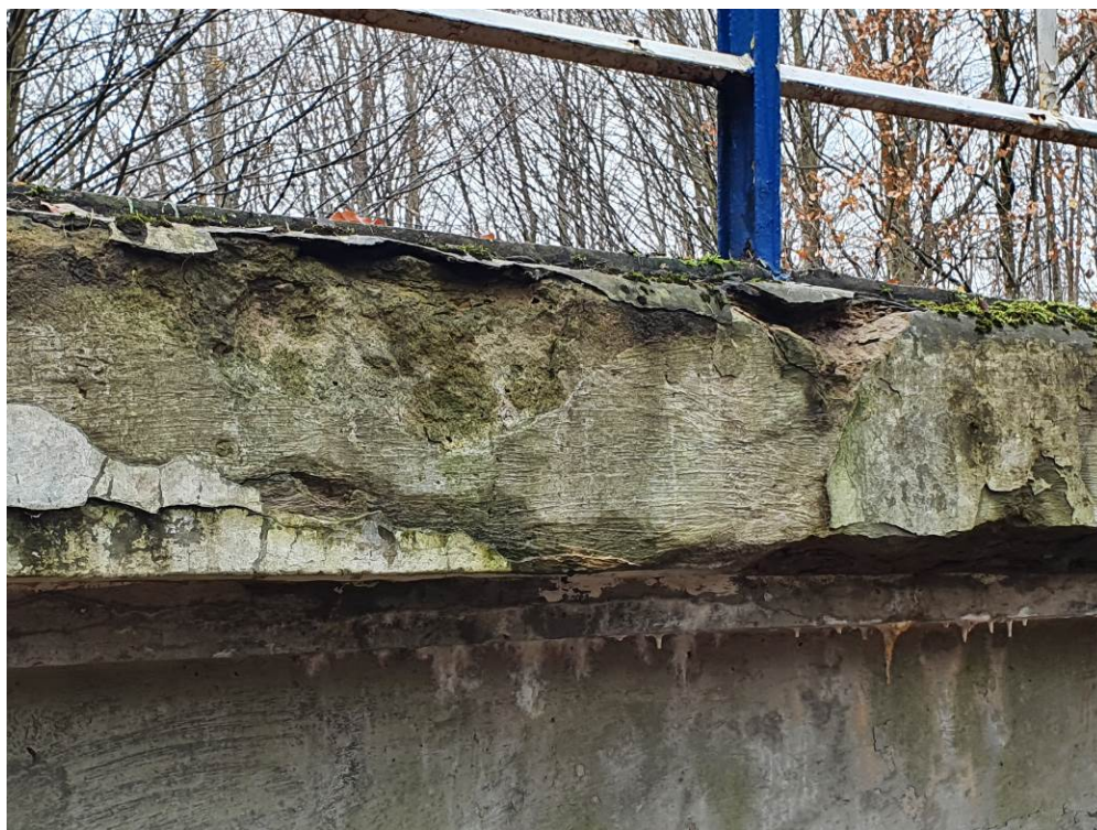
Fot. 14. Skorodowany beton belki gzymsowej. Widoczne liczne ubytki betonu.
