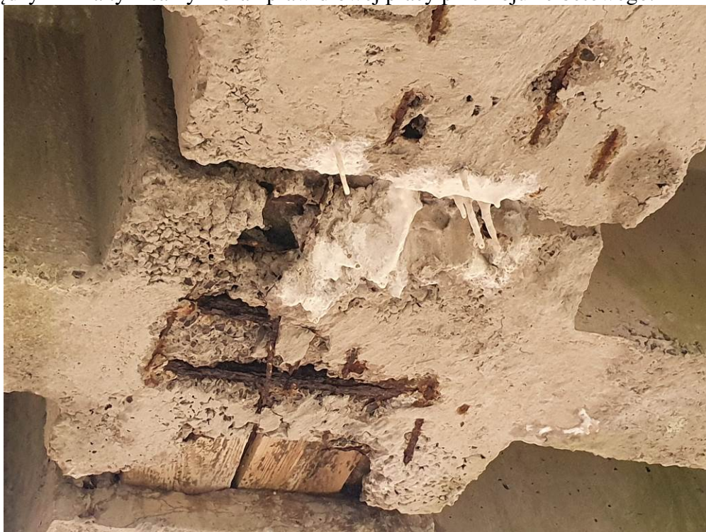
Fot. 10. Rozsegregowany beton, ubytki betonu, korozja stali i wykwyty w prowizorycznej poprzecznicy. Widoczne prowizoryczne, drewniane szalunki wewnątrz poprzecznicy wykonane z uwagi na brak powtarzalności kształtu belek prefabrykowanych.
