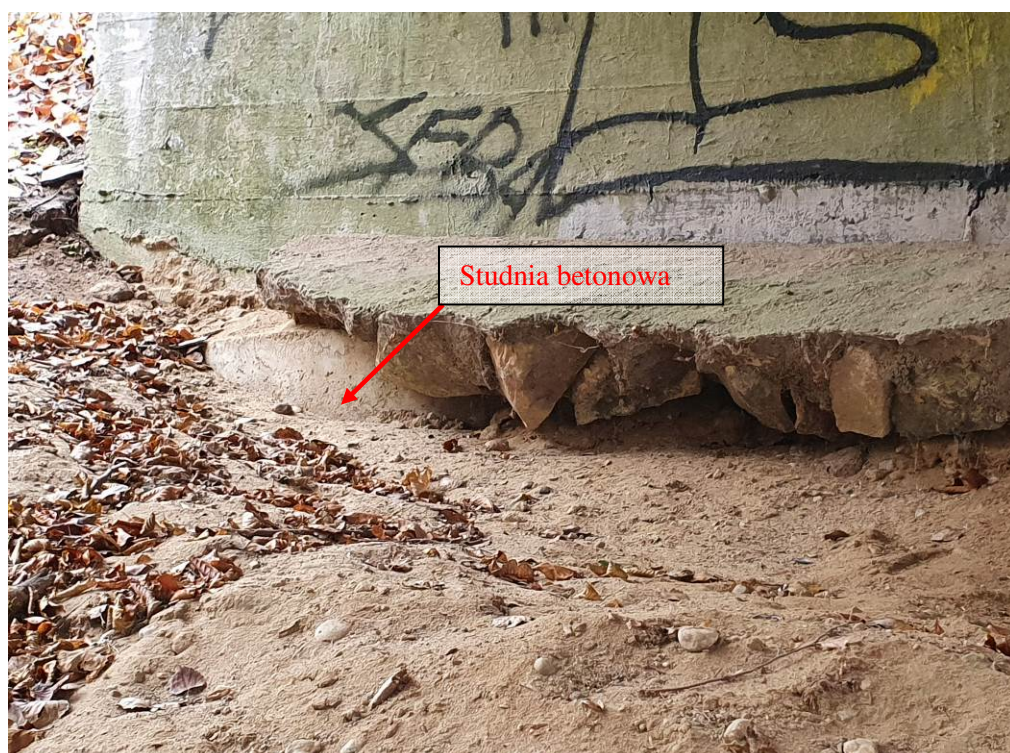
Fot. 3 Przyczółek od strony Mojuszewskiej Huty. Widoczna studnia betonowa posadowienia. Częściowo wypłukany grunt spod korpusu przyczółka.
