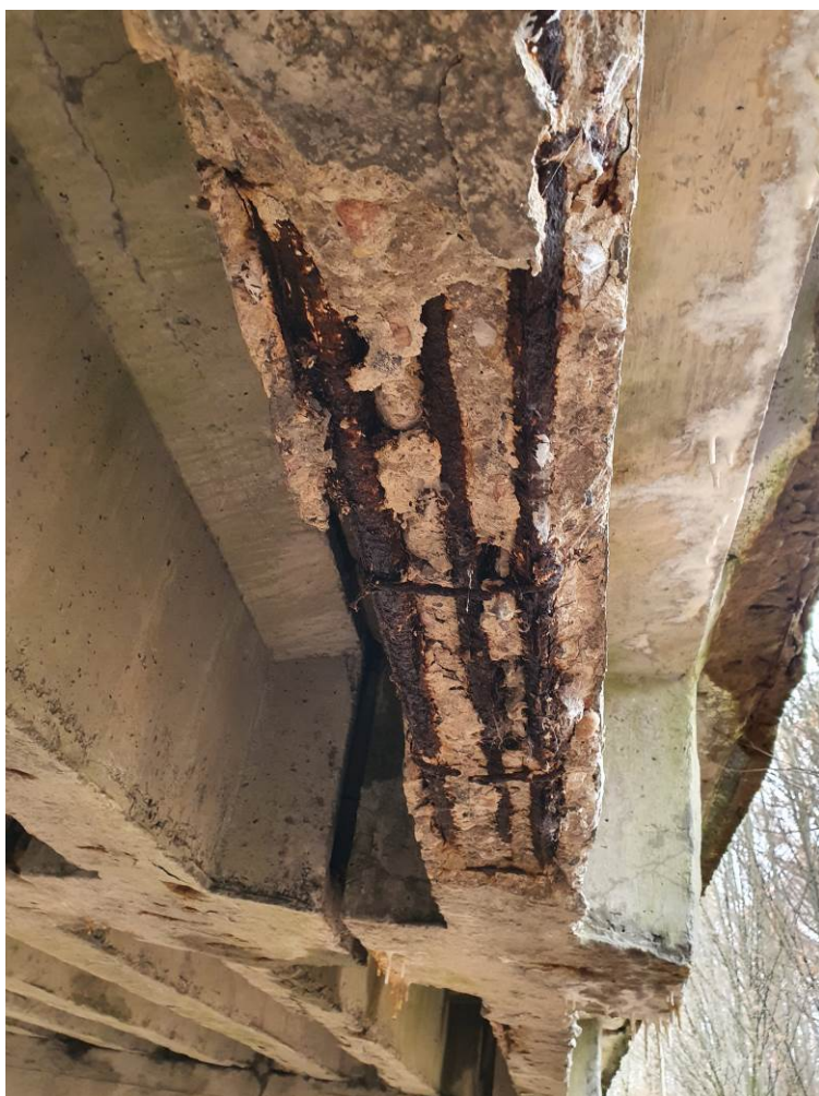
Fot. 9. Przykład odspojenia otuliny na całej szerokości belki, zbrojenie skorodowane.
