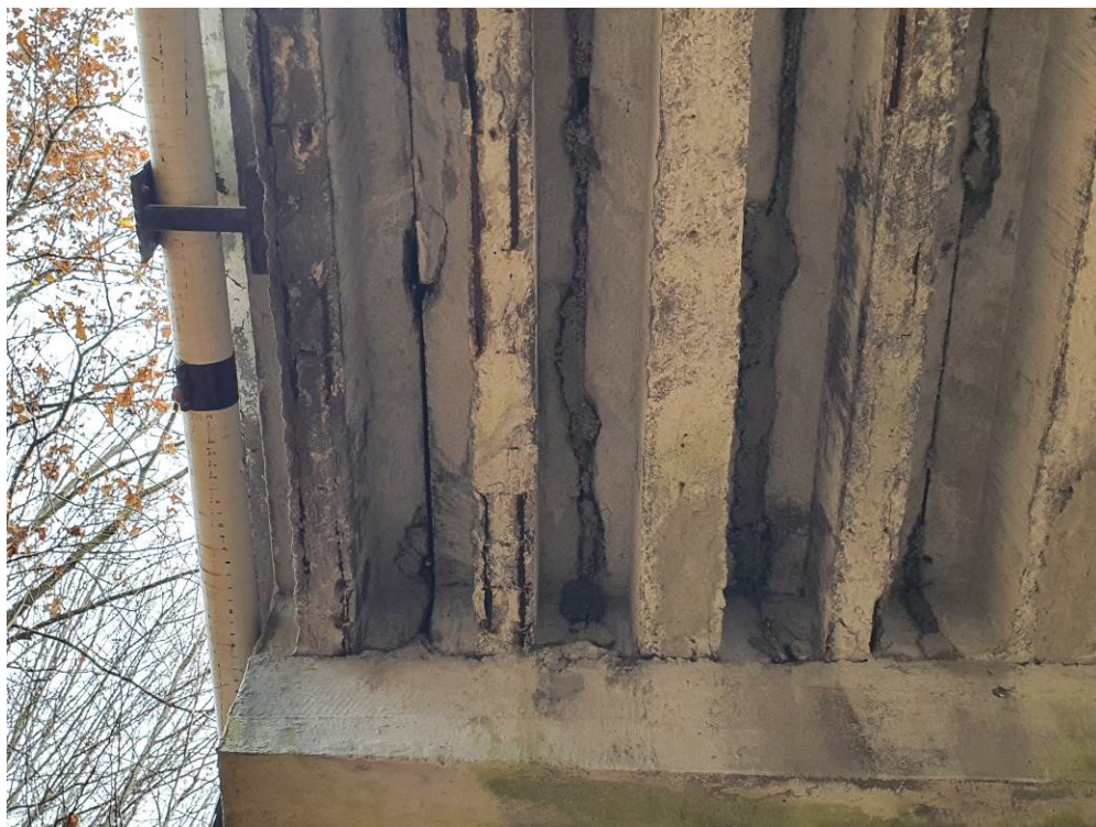
Fot. 13. Widok na dolną powierzchnię przęsła. Brak otuliny betonowej w strefie podporowej, skorodowana stal zbrojeniowa, nieregularność kształtu belek i spowodowane tym wycieki mieszanki betonowej płyty pomostu.
