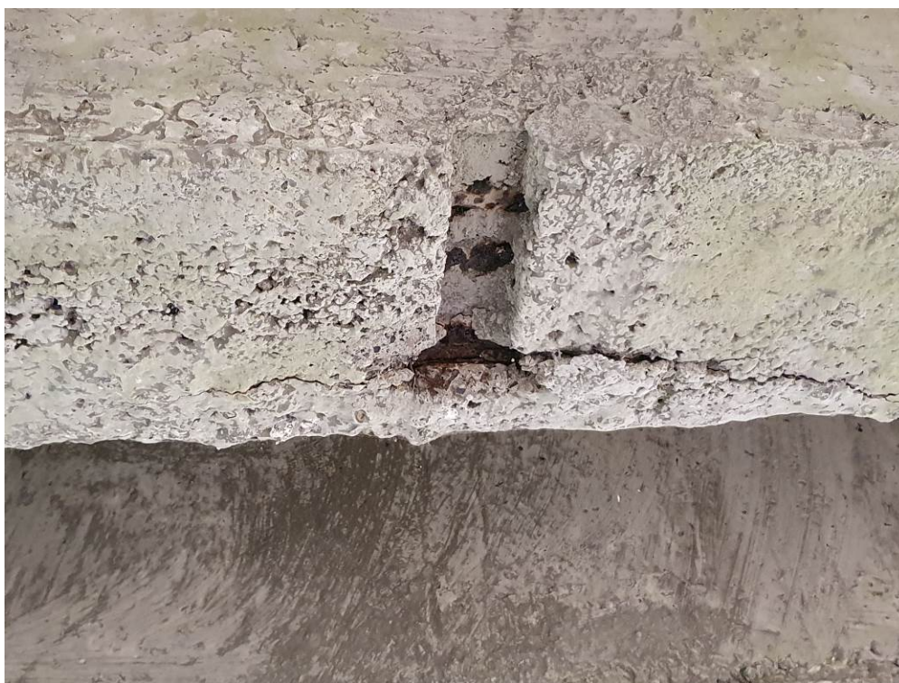
Fot. 12. Widok na dolną powierzchnię belki. Widoczny ubytek po drewnianym dystansie i korozja zbrojenia.
