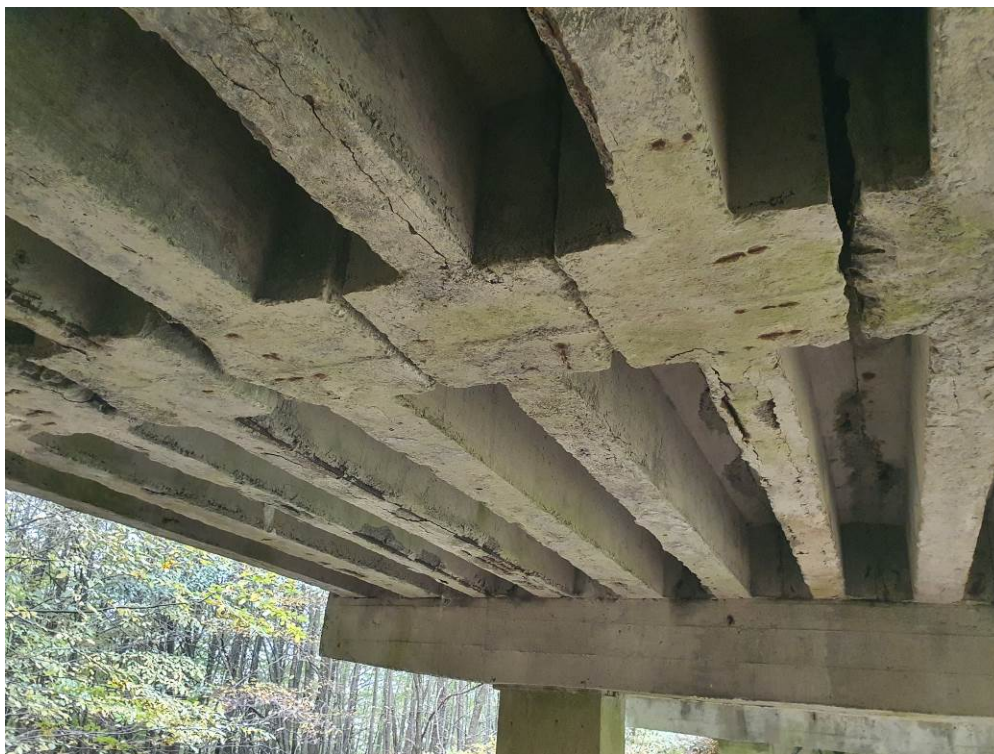
Fot. 11. Widok na dolną powierzchnię przęsła. Widoczne liczne spękania na dolnych powierzchniach belek, postępującą korozję betonu, odsłonięte zbrojenie i ubytki betonu.
