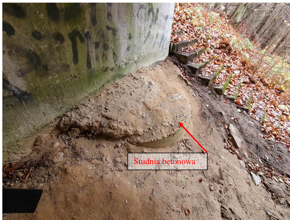
Fot. 4 Przyczółek od strony Mojuszewskiej Huty. Widoczna studnia betonowa posadowienia. Częściowo wypłukany grunt spod korpusu przyczółka.
