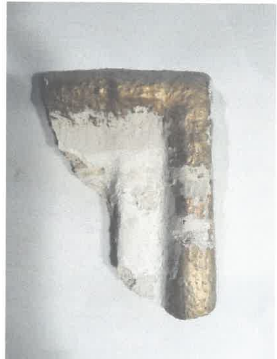
Fot. 7 Wnętrze Kościoła pw. Matki Boskiej Różańcowej, Nowy Kościół. Stan przed konserwacją, detal, widoczne uszkodzenia warstwy tynku, monochromii, elementów ciągnionych oraz złożonych. Obserwuje się liczne warstwy stratygraficzne, styczeń 2019 r.
