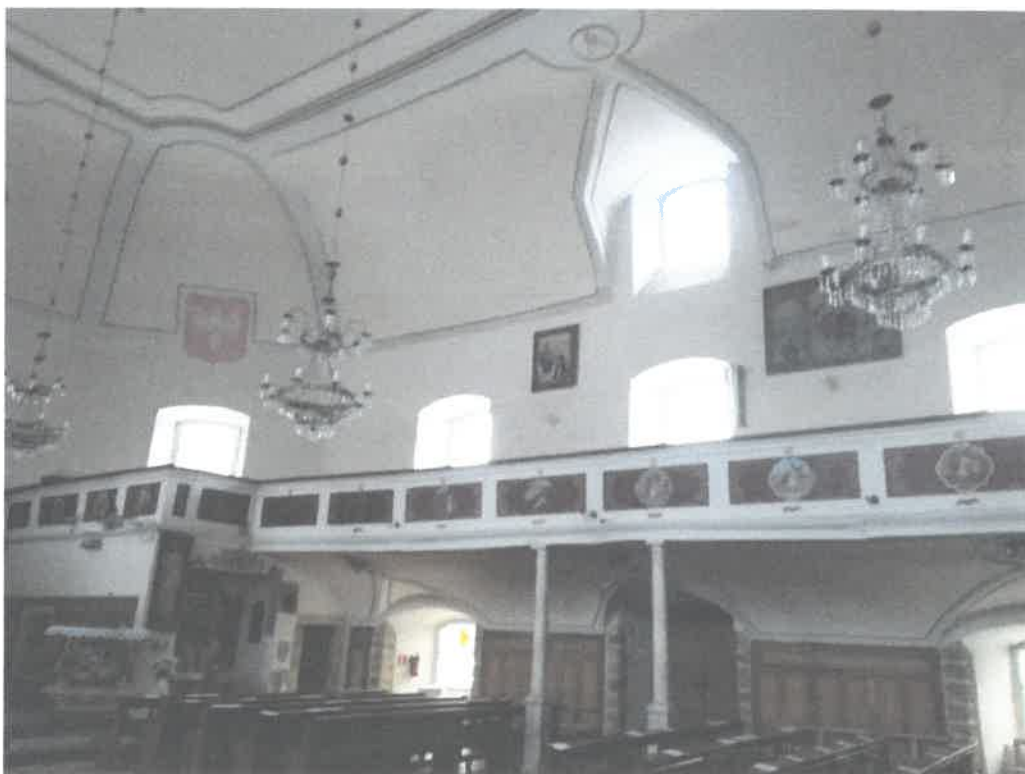
Fot. 6 Wnętrze Kościoła pw. Matki Boskiej Różańcowej, Nowy Kościół. Stan przed konserwacją, widok ogólny na empory, styczeń 2019 r.
