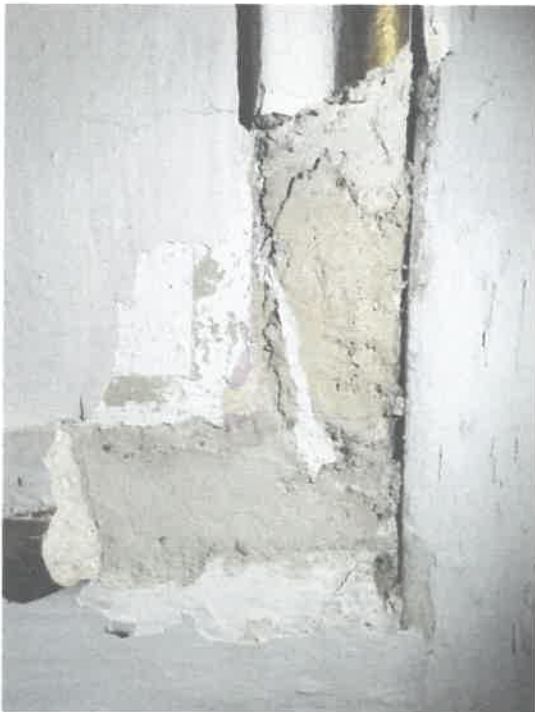
Fot. 7 Wnętrze Kościoła pw. Matki Boskiej Różańcowej, Nowy Kościół. Stan przed konserwacją, detal, widoczne uszkodzenia warstwy tynku, monochromii, elementów ciągnionych oraz złożonych. Obserwuje się liczne warstwy stratygraficzne, styczeń 2019 r.
