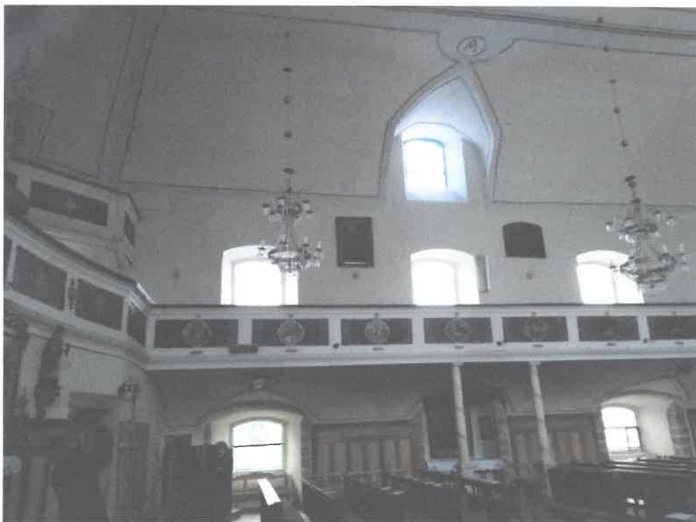
Fot. 4 Wnętrze Kościoła pw. Matki Boskiej Różańcowej, Nowy Kościół. Stan przed konserwacją, widok ogólny na empory, styczeń 2019 r.
